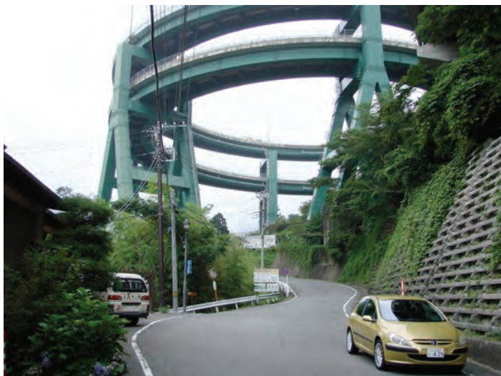
Fig.4.2 - Kavazu-Nandaru Loop Bridge, văzut de pe traseul de la baza structurii spiralate.
