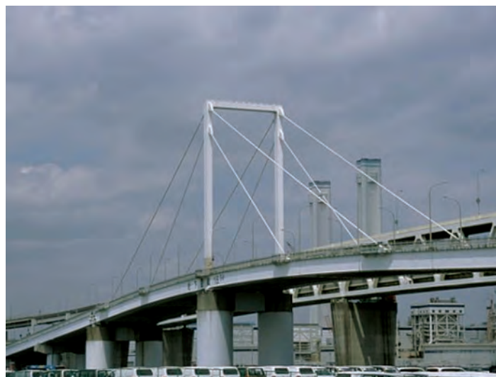
Fig.6.1 - Podul Daikoku Ohashi, susținut de cabluri staționare, pregătit să transfere utilitățile Toyota pentru export
