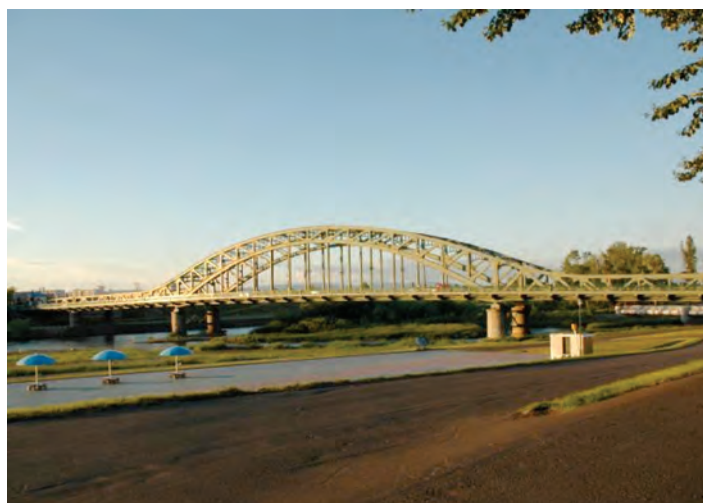
Fig.15 - Asahibashi Iron Bridge a fost construit în Hokkaido cea de-a doua insulă ca mărime din arhipelag
