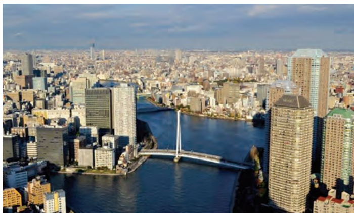
Fig.5.2 - Tsucada Ohashi susținut prin cabluri staționare conectează, din punctul de vedere al activităților locale, două sectoare cu activități economice complementare din capitala niponă
