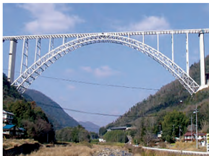
Fig.1 - Deschiderea centrală a podului Hiroshima Airport Bridge, văzută din imediata vecinătate a structurii
