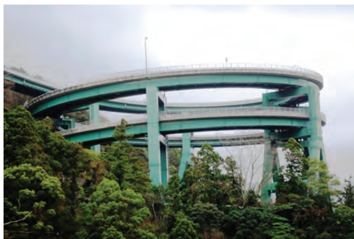
Fig.4.1 - Kavazu-Nandaru Loop Bridge și accesul descendent la podul rutier în spirală
