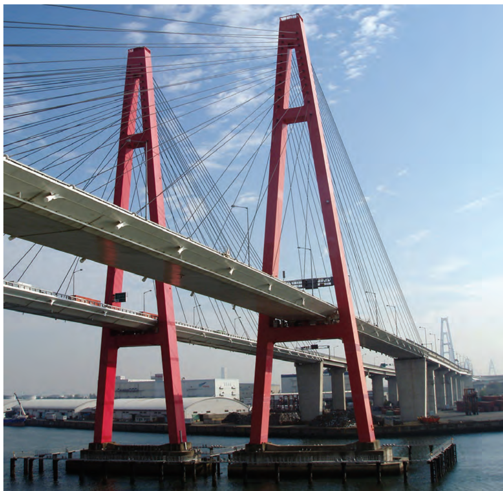
Fig.14 - Podurile cu hobane Meiko Nishi și Meiko Highashi, vopsite în roșu, au platelaje suprapuse în vederea satisfacerii necesităților teoretice de trafic în permanentă creștere pe acest traseu. După reevaluarea necesităților reale, s-a decis amânarea punerii în circulație a celui de-al doilea pod.
