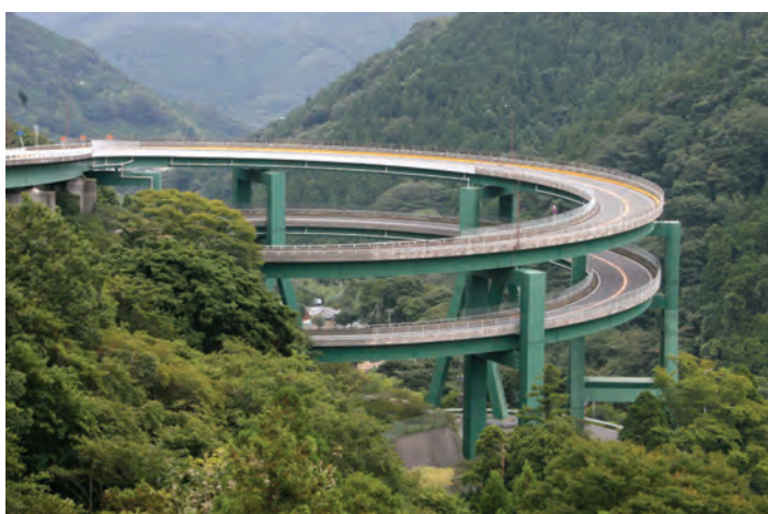
Fig.4.3 - Kavazu-Nandaru Loop Bridge și traseul rutier superior, cu acces la podul spiralat
