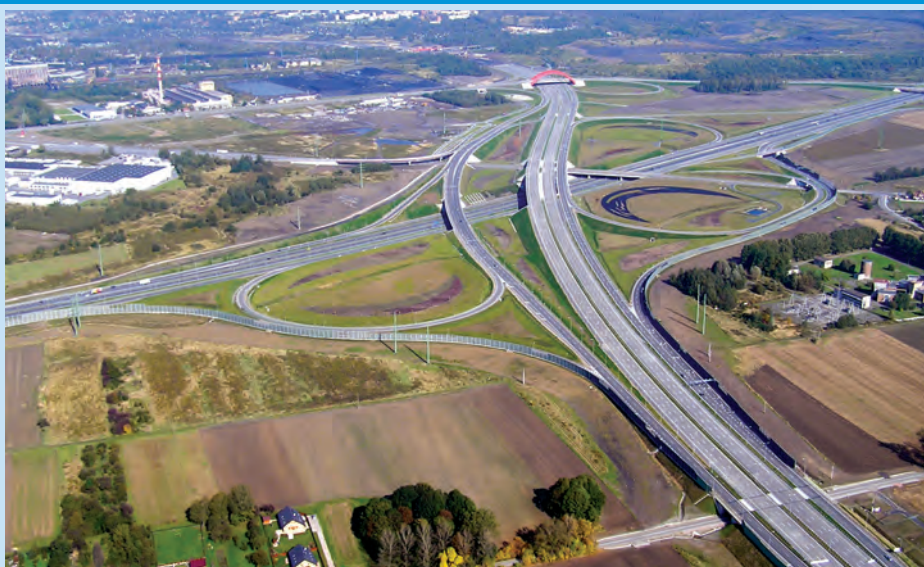
Nodul rutier Gliwice-Sosnica, între A1-A4 și Drumul Național 44 (cea mai largă construcție rutieră de acest gen din Europa Centrală și de Est)
