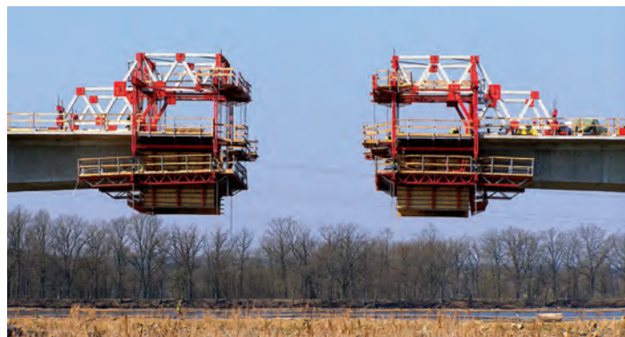
Fig. 2 - Tehnologia de execuție tip consolă în echilibru
