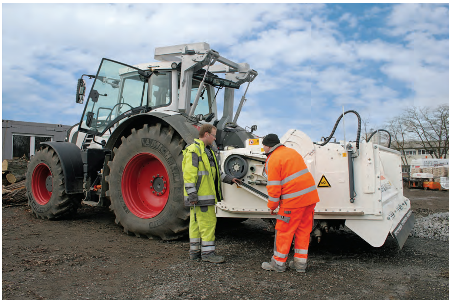
Asistența service este o prioritate: tehnicianul Wirtgen, Markus KLEIN (stânga) oferă instrucțiuni detaliate asupra operării stabilizatorului WS 250...
