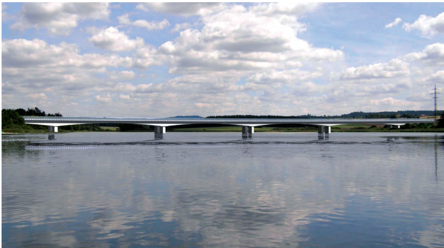
Fig. 1 - Vedere laterală a podului
