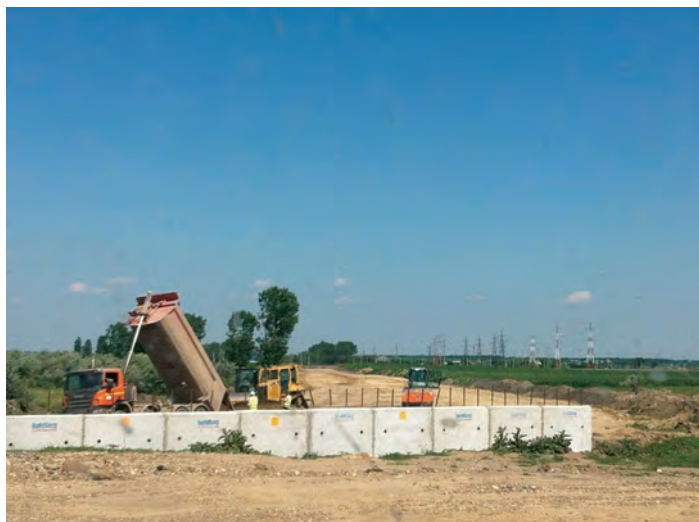
Foto 4. Lucrări la Varianta de ocolire a municipiului Tecuci, înainte de Pasajul peste linia dublă C.F. Făurei-Tecuci
