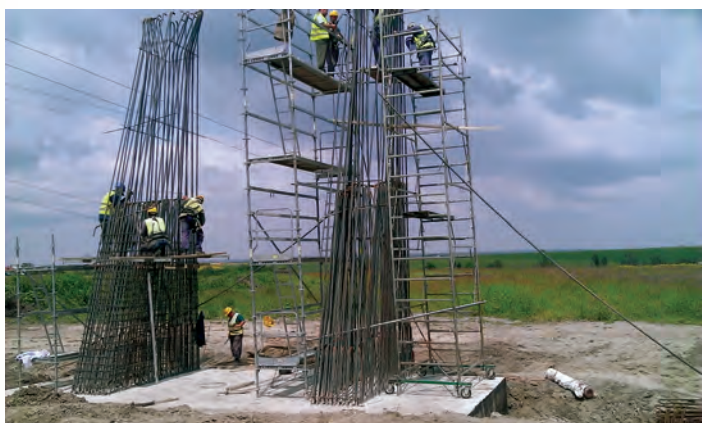
Foto 5. Se lucrează la armătura unei pile a viitorului pasaj peste D.N. 24
