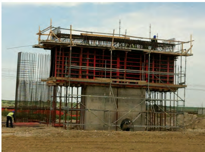
Foto 3. Lucrări la pilele Pasajului de racordare cu D.N. 24
