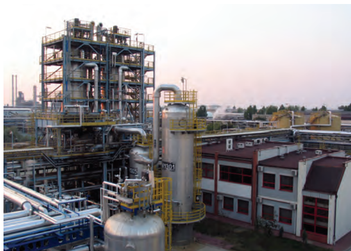
Grafic 2. Instalație de oxidare continuă - reactoare Biturox® (fot. „ORLEN Asphalt”)
