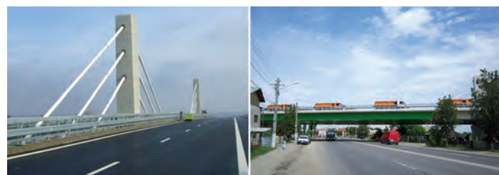
Figura 15. Aspectul pasajului peste D.N. 1, de la Bărcănești a) vâzut de la nivelul căii; b) vâzut de pe D.N. 1
