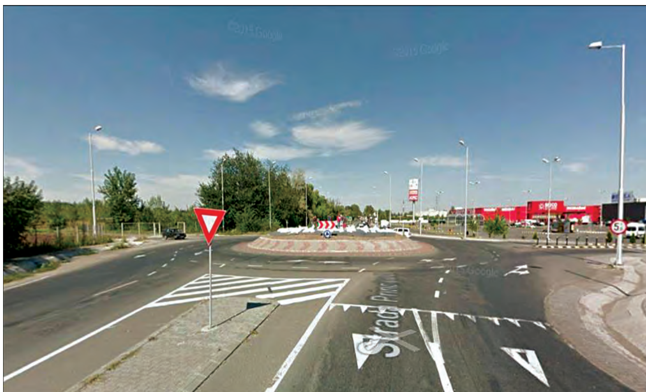
Figura 2. Exemplu de sens giratoriu cu 2 benzi de circulație pe sens
