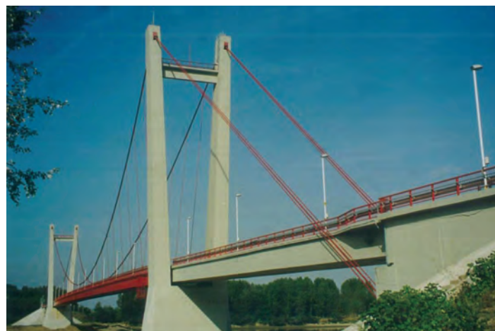
Figura 7. Vedere generală pod
