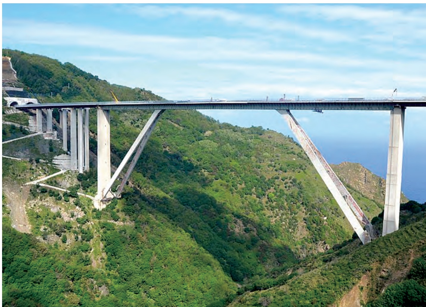
Fig. 8 - Viaductul Stalassa dintr-o perspectivă oblică, din care se văd cele două portaluri de tunel, pilonii cu înălțimi reduse, cei doi piloni principali din zona centrală dar și cele 4 contrafișe înclinate în sens transversal și longitudinal
