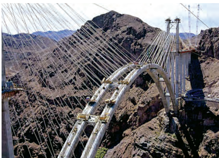
Fig. 13 - Tronsoanele arcelor podului Hoover, amplasate și susținute temporar cu ajutorul cablurilor staționare
