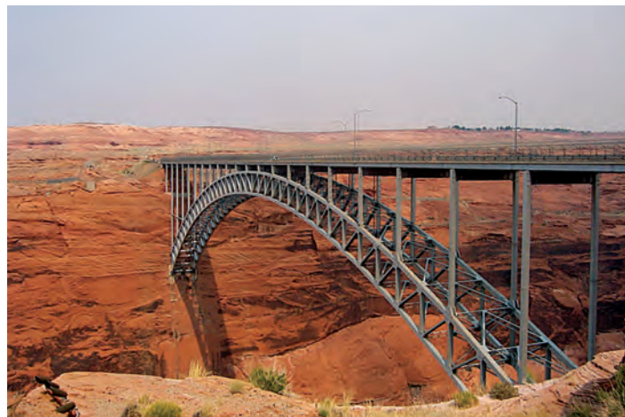
Fig. 11 - Glen Canyon Bridge: arc metalic spațial alcătuit din două arce plane cu zăbrele, având tălpi paralele interconectate cu bare, care sporesc rigiditatea la torsiune a ansamblului. Platelajul podului este susținut deasupra tălpiilor superioare ale arcelor, din două în două panouri, prin cadre-portal transversale, formate din perechi de montanți și antretoaze înalte.
