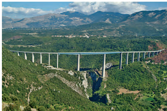
Fig. 9 - Viadotto Italia. Imagine a viaductului cu 19 deschideri, care reliefează poziția canionului prin care curge râul Liao
