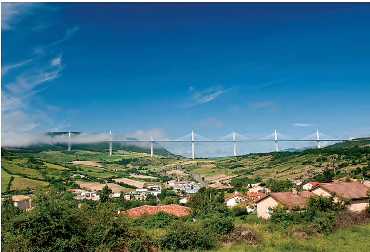
Fig. 2 - Elevația viaductului Millau, cu o parte a tablierului ascunsă în nori
