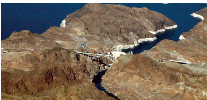
Fig. 5c - Barajul Hoover, lacul de acumulare și podul din aval de baraj, fotografie aeriană de Doc Searls de la Harvard University
