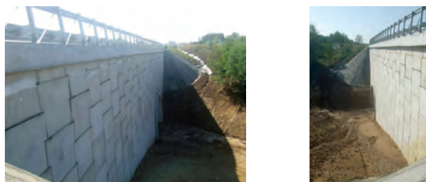
Figura 3 - Cedarea laterală a panourilor superioare - parament aval și amonte
