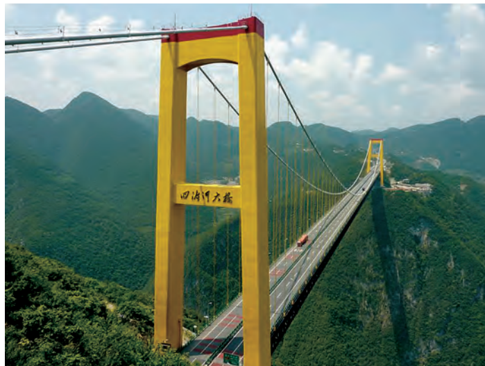
Fig. 3a - Siduhe, pod rutier cu patru benzi de circulație, trotuare și o bandă mediană de separare a sensurilor de parcurs
