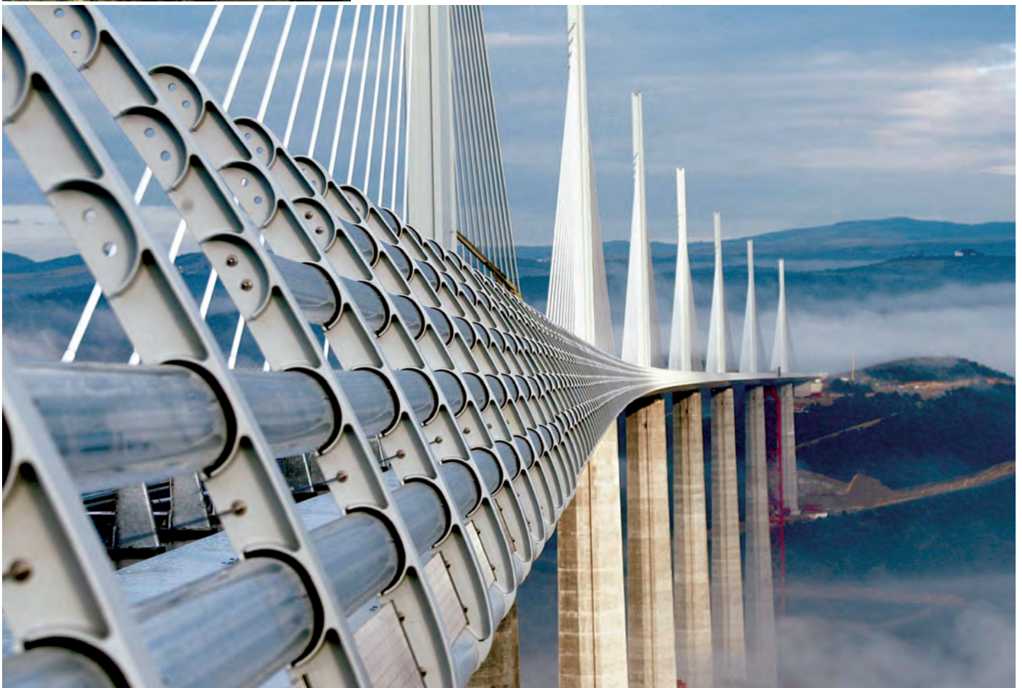
Fig. 2d - Parapetul viaductului Millau este capabil să prevină căderea autovehiculelor de pe tablier
