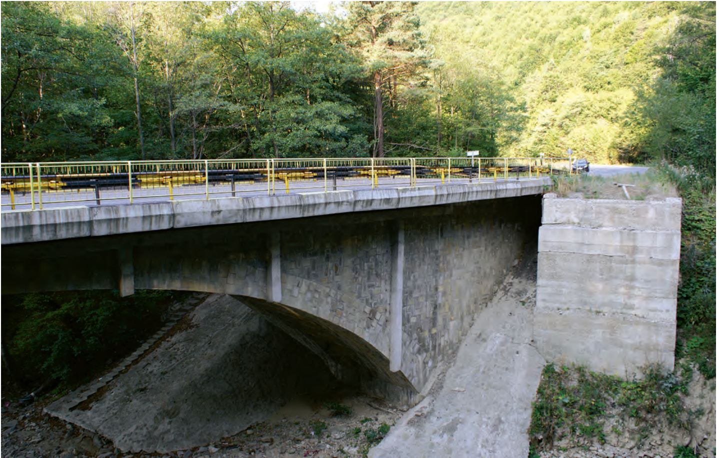
Fig. 204 - Podul peste râul Oituz, la Poiana Sărată. Elevația amonte a podului consolidat (Foto, S. FLOREA, 2012)
