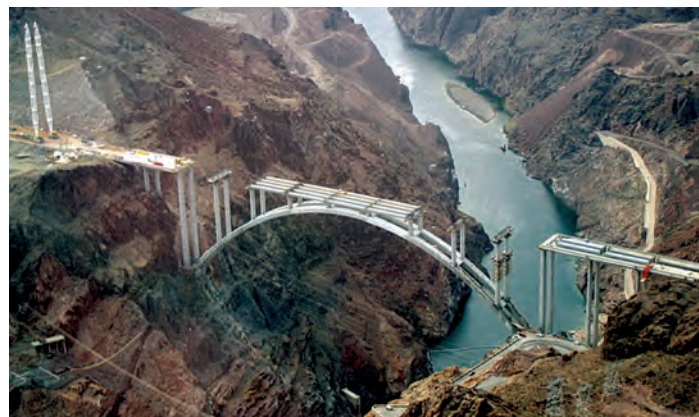
Fig. 5a - Podul construit peste fluviul Colorado în stadiul de instalare a elementelor prefabricate
