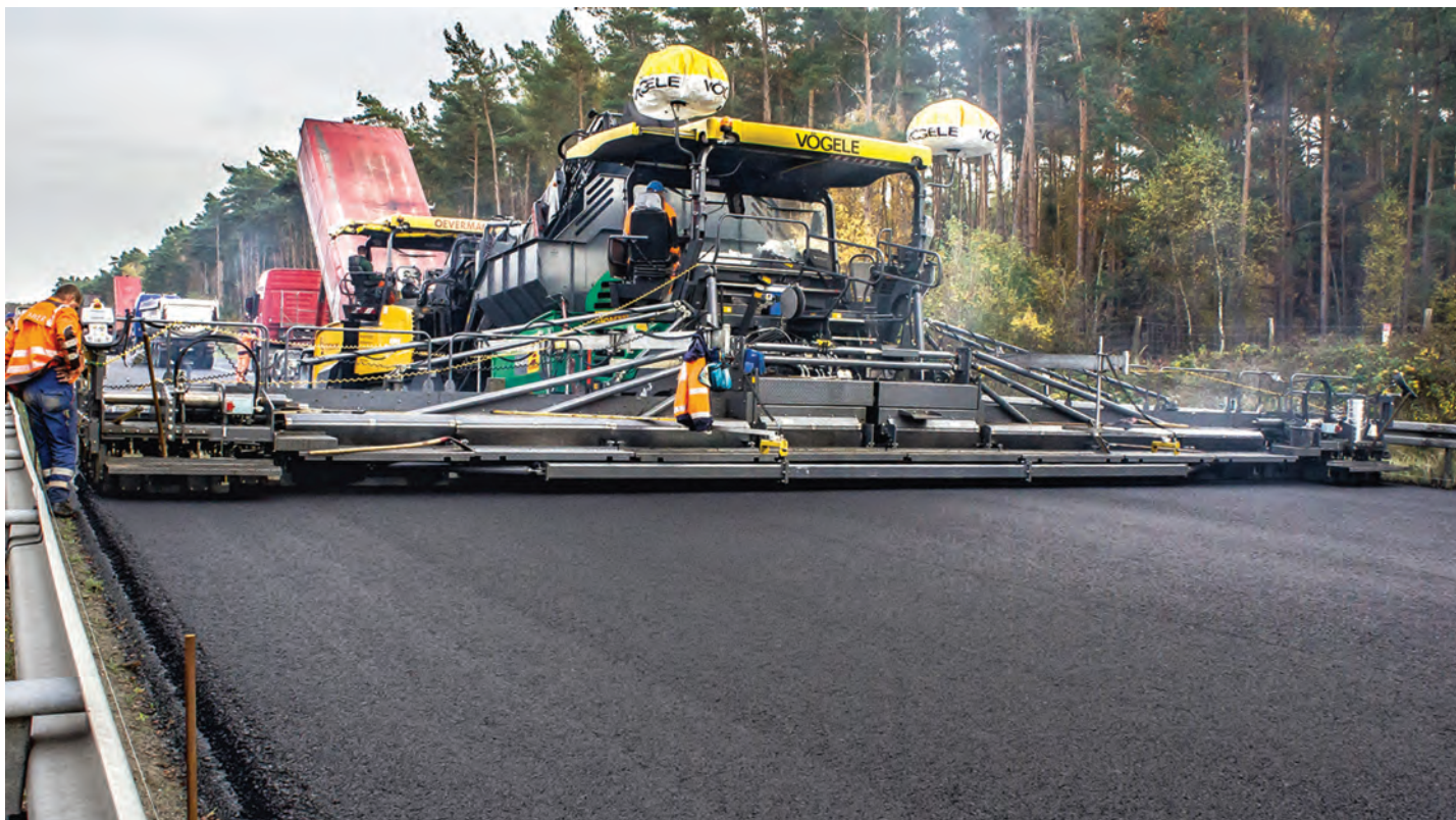
VÖGELE echipat cu grindă fixă SB300, în versiunea TP1, a realizat o asfaltare omogenă de înaltă calitate pe întreaga lățime de 15,5 m
