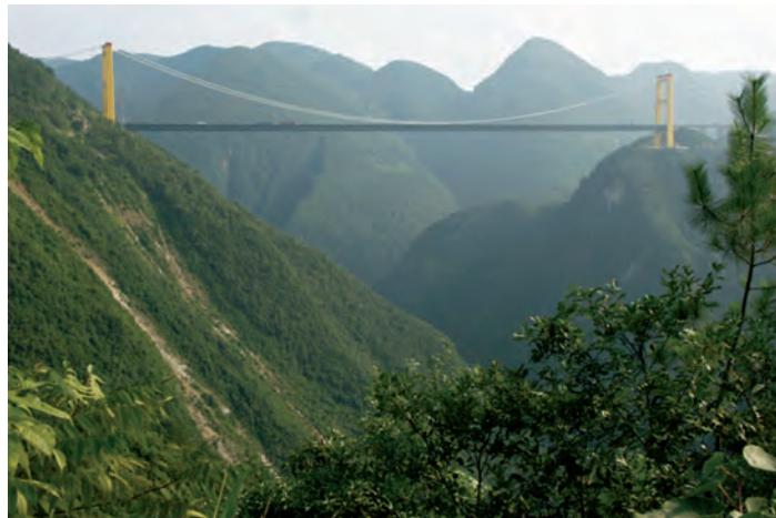
Fig. 3b - Siduhe River Bridge, podul construit în China la cea mai înaltă altitudine, 494 m peste Siduhe
