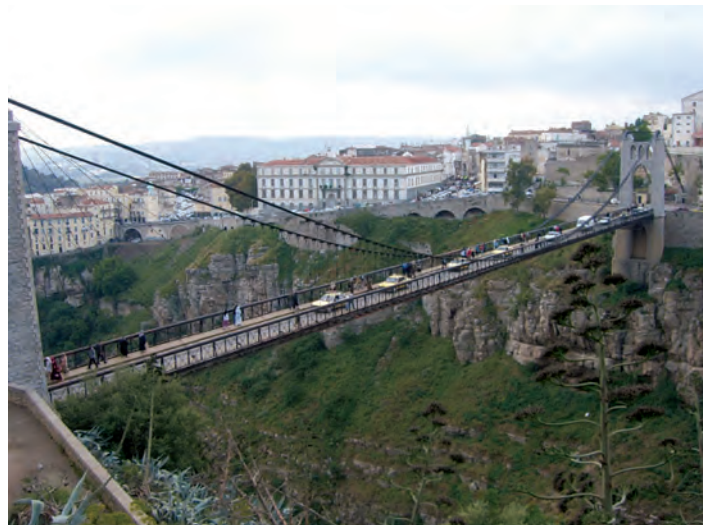
Fig. 7 - Imagine a podului suspendat Sidi M’Cid, construit în Constantine, Algeria. Podul este susținut de cele două cabluri cu eforturi variabile, care trec peste turnurile de capăt, dar și de cablurile staționare cu eforturi constante, ancorate în cele două turnuri. Cablurile staționare se văd clar în extremitatea din stânga imaginii
