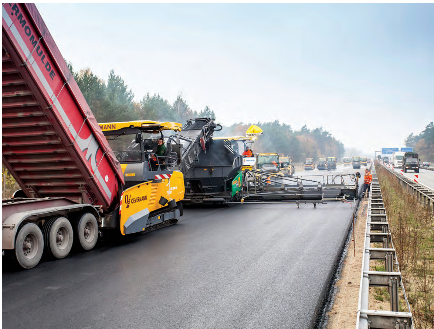
Pe autostrada „Inelul Berlinului”, o grindă cu grad înalt de compactare a fost utilizată pentru prima oară să asfalteze pe o lățime de 15,5 m. În imagine: un alimentator VÖGELE MT3000-2i Offset, împreună cu un finisor SUPER 3000-2 echipat cu grindă fixă SB 300 -TP1
