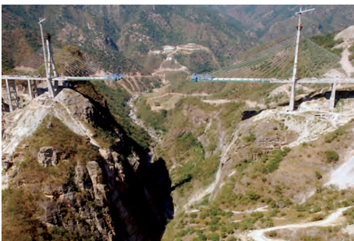
Fig. 4a - Podul Baluarte în timpul execuției tablierului între piloni cu ajutorul cablurilor staționare instalate și tensionate succesiv pe măsura întăririi betonului din capetele celor două console
