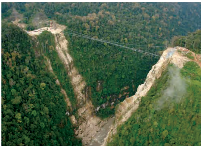
Fig. 6a - Imaginea canionului și a legăturilor dintre versanți înainte de a se construi al doilea ancoraj definitiv
