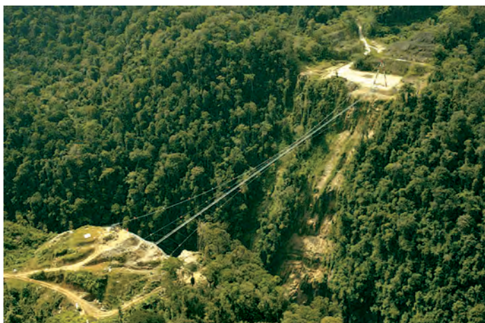
Fig. 6 - Fotografie din elicopter a tablierului, a cablajului și a ancorajului de pe versantul nordic al canionului
