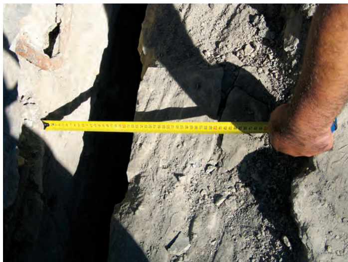
Fig. 199 - Podul peste râul Oituz, la Poiana Sărată Valorile deplasărilor timpanelor în zona cheii erau cuprinse între 22-30 cm (Foto , S. FLOREA, 2005)
