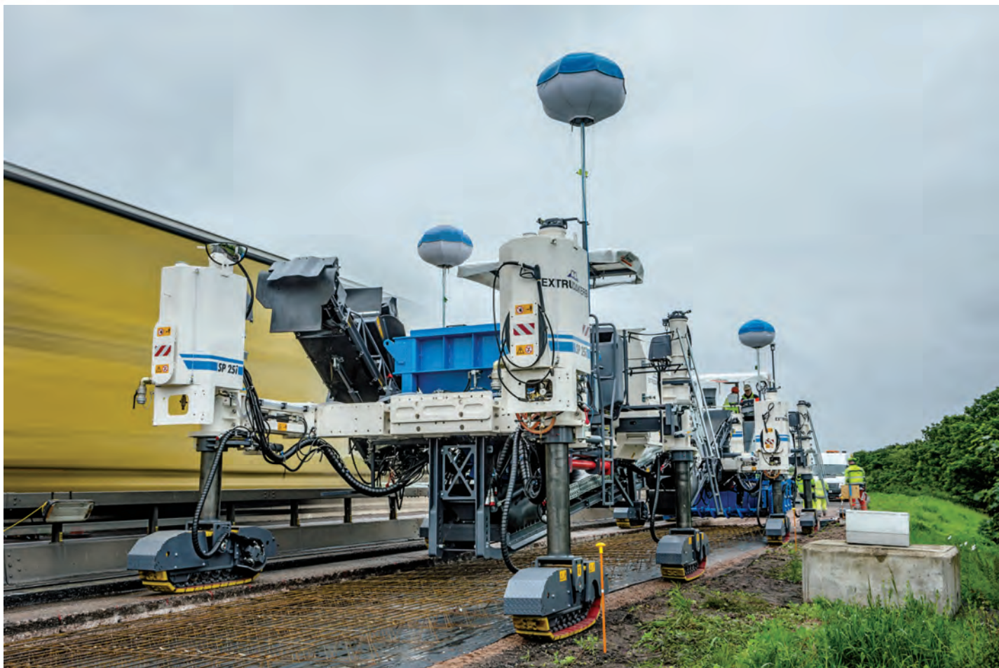
Finisor de beton Wirtgen SP25i, împreună cu alimentatorul lateral ISF 25i, au fost folosite la Autostrada M6, lângă Cannock
