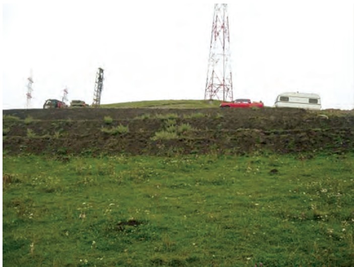
Figura 5 – P.III. Vedere aval de drum către stâlpul LEA
