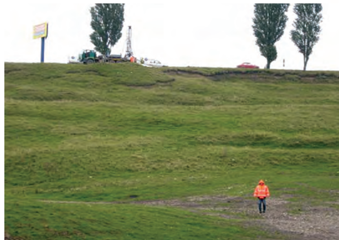
Figura 3 – P.II. Vedere amonte de drum către D.N. 2
