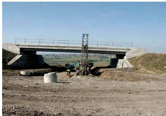
Figura 4 – P.II. Vedere amonte de drum către podul OB
