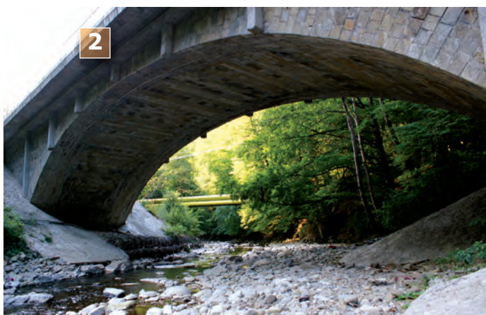
Fig. 201 - Podul peste râul Oituz, la Poiana Sărată 1. Secțiunea longitudinală (Desen, S. FLOREA); 2. Elevația amonte a bolții consolidate (Foto, S. FLOREA, 2002).
