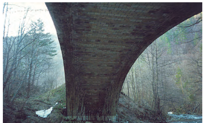
Fig. 192 - Podul peste râul Oituz, la Poiana Sărată. Începuturile fenomenului de voalare generală a timpanelor bolții podului. (Foto, S. FLOREA, 2002)
