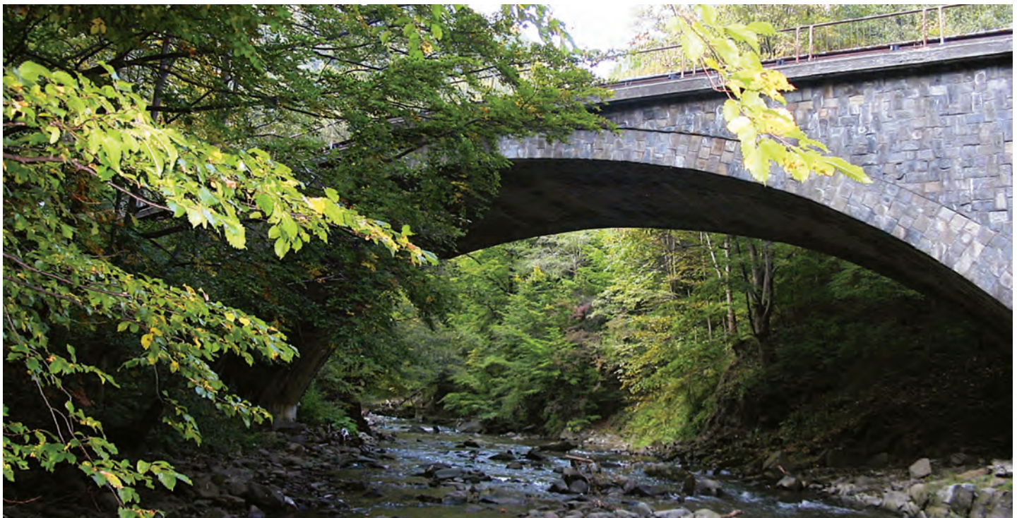
Fig. 191 - Podul peste râul Oituz, la Poiana Sărată. Elevația aval, văzută de pe malul drept al râului (Foto, S. FLOREA, 2003)
