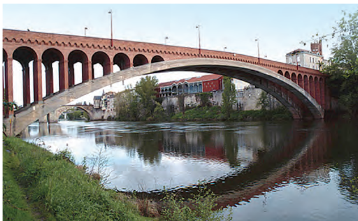
Fig. 10 Primul arc de beton armat construit de Eugene Freyssinet la Villeneuve-sur-Lot
