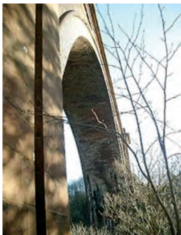
Fig. 9a Bolta centrală de 55 m a viaductului, construită din bolțari de hard-stone
