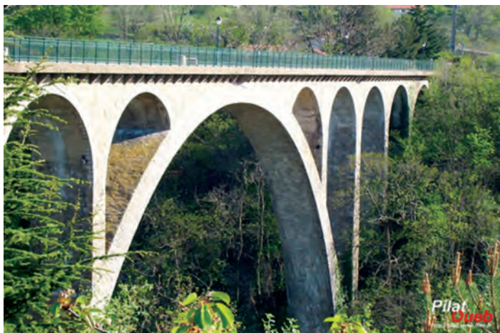
Fig. 6a Viaductul reamenajat pentru siguranța pietonilor
