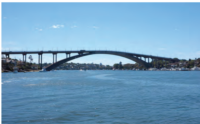
Fig.12a Gladesville Bridge, susținând tablierul înainte de a se aglomera circulația, dar și după aceea
