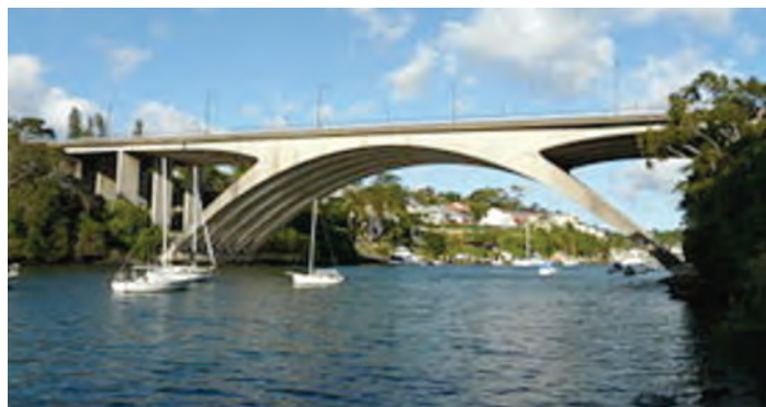
Fig. 12c „Fig Tree Bridge”
