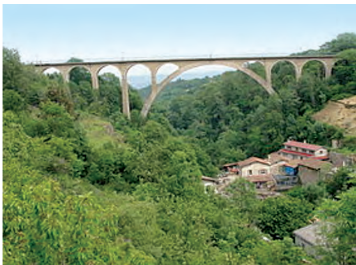
Fig. 6 Viaductul Pelussin, văzut de la distanță
