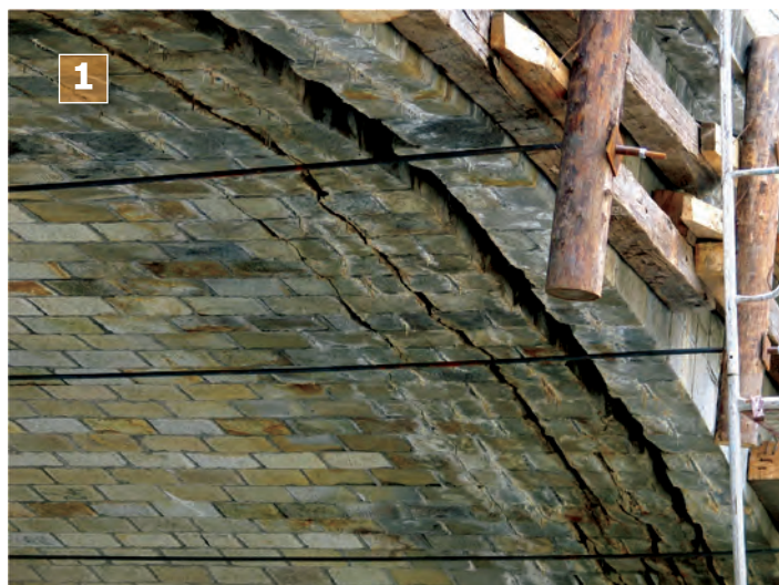
Fig. 196 - Podul peste râul Oituz, la Poiana Sărată. Detaliu cu măsurile provizorii pentru a evita prăbușirea timpanelor: 1. Detaliu cu tiranții provizorii din secțiunea transversală. Intradosul boltii, în momentul în care s-au găsit sursele financiare pentru reabilitare (Foto, S. FLOREA, 2005); 2. Secțiune transversală, cu releveul crăpăturilor în ceasul 12, în momentul elaborării proiectului de consolidare (Desen, S. FLOREA, 2005)
