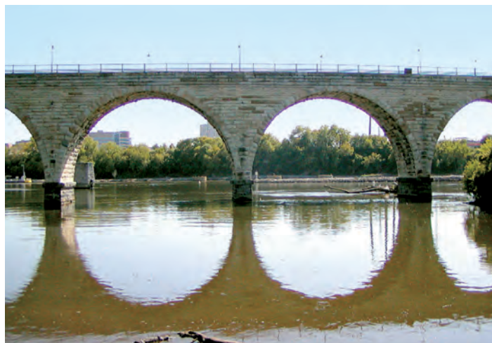
Fig. 8a Imagine a unei părți din zidăria bolților de piatră ale podului, care a suferit certe intervenții „chirurgicale” și după ce a depășit venerabila vârstă de 111 ani
