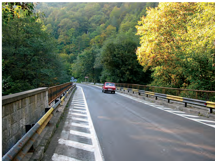
Fig. 194 - Podul peste râul Oituz la Poiana Sărată. Restricția impusă pentru circulația rutieră de a circula pe axul drumului, prin semnalizarea orizontală (Foto, S. Florea, 2002)
