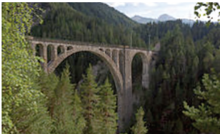
Fig. 2a Viaductul Wiesener sau, datorită subarcelor, un alter ego al acestuia, în așteptarea sezonului de toamnă-iarnă
