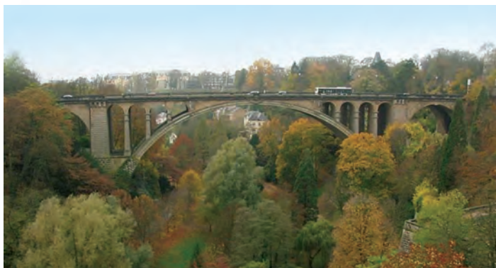
Fig. 4a Podul Adolphe sub circulație, cu cele opt subarce de fațadă și cele două bolți de capăt, în compania unei vegetații luxuriante, la scurt timp după inaugurare
