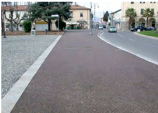
Figura 8 - Covor asfaltic realizat cu Resina LT
