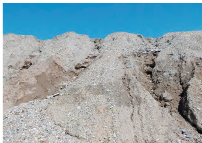
Figura 4 - Eroziunea taluzului rambleului
