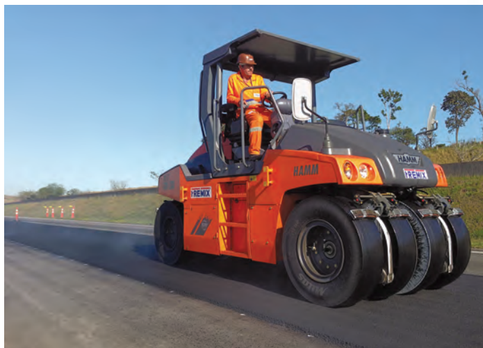
Cilindru compactor pe pneuri Hamm GRW 280 execută compactarea finală a stratului de uzură
