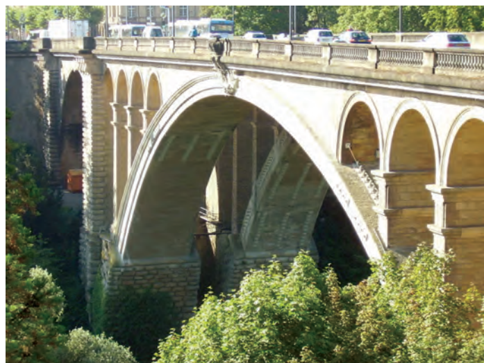
Fig. 4 The New Bridge, principalul și cel mai circulat pod din capitala Luxemburgului
