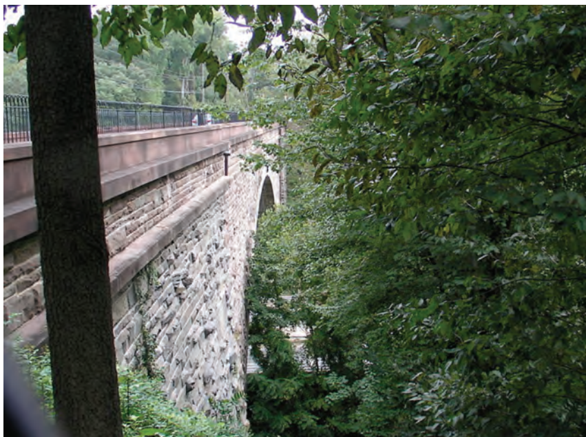
Fig. 1b Timpanele de gresie maschează cele nouă arce interioare ale structurii
