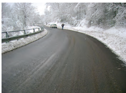
Figura 10 - Utilizarea Winterpav în stratul de uzură (loc. Verghereto, Italia)
