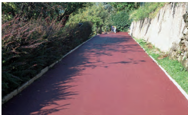
Figura 5 - Covor asfaltic realizat cu produsul
