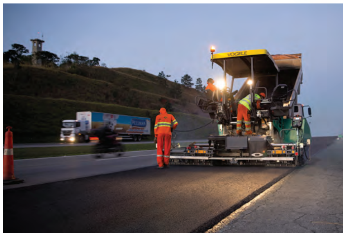
Finisorul Vögele SUPER 1300-3i, utilaj compact, cu o capacitate de așternere de max. 350t/h și o lățime de așternere de max. 5 m
