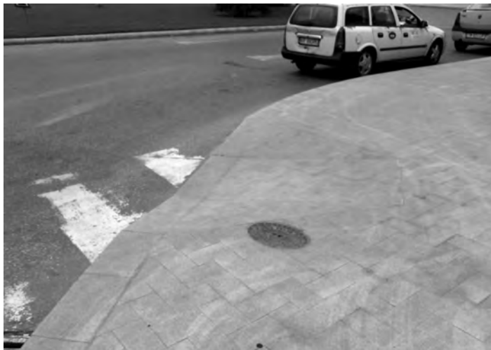
Figura 5. Coborârea de pe trotuar prin rampă. Sursa: Autorii
