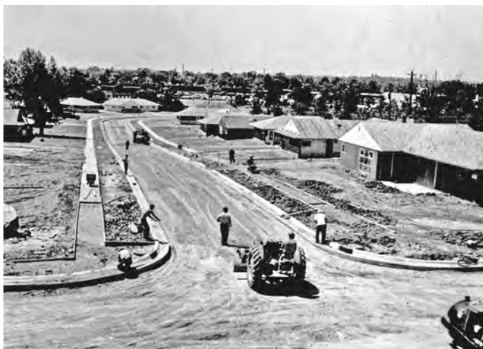
Montarea bordurilor la început de secol
