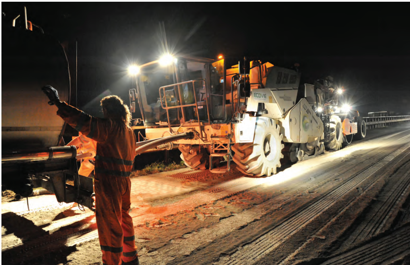
Cu cele șase faruri proiectoare pe cabină, cele două faruri laterale stânga/dreapta, două faruri de curbă în spate și alte două proiectoare liber poziționabile, reciclatorul WR 250 lucrează cu performanță maximă, chiar și după lăsarea întunericului
