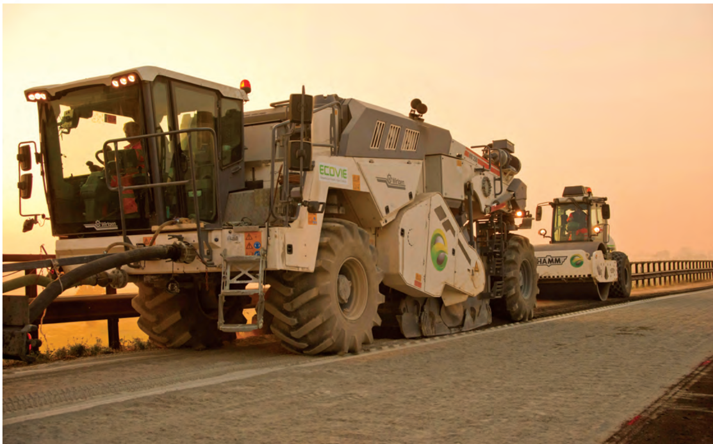
Stratul reciclat de către WR 250 este imediat compactat de către un cilindru compactor vibrator de terasamente Hamm H 20i
