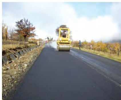
Figura 5. Aspectul sectorului experimental realizat
