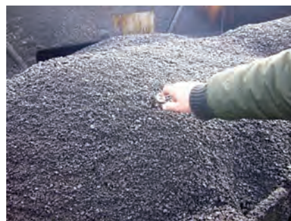
Figura 3. Aspectul mixturii asfaltice la punerea în operă și măsurarea temperaturii înainte de așternerea și compactarea mixturii asfaltice.
