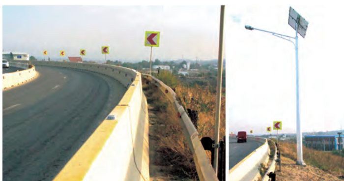
Fig. nr. 4 și 5 - Butoni luminoși pe partea superioară a parapetului și stâlp iluminare
