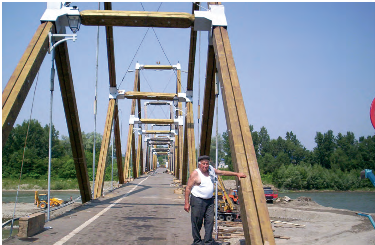
Fig. 184 - Podul de lemn peste râul Tisa, la Sighetu Marmăției. Contrafișele înlocuite în deschiderile 1 și 2. Maistrul Iuliu GAL. (Foto, A. Tiberiu, 2008)
