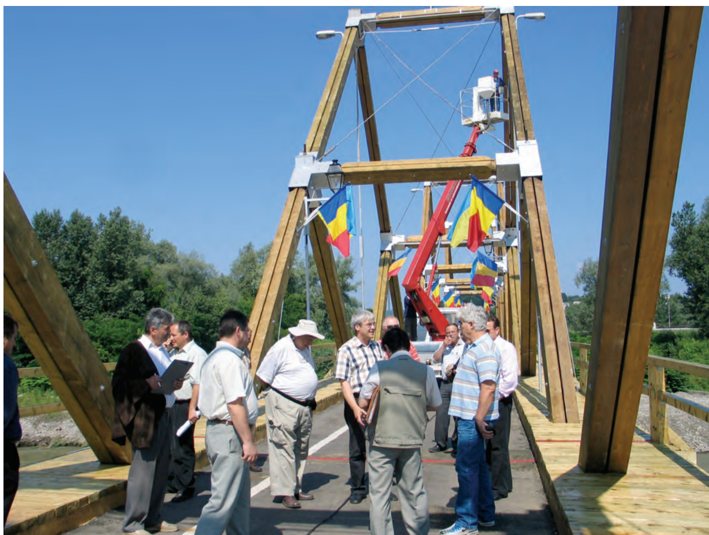
Fig. 188 - Podul de lemn peste râul Tisa, la Sighetu Marmăției. Carosabilul podului de lemn peste râul Tisa, după refacerea contrafîșelor, în 2008. (Foto, B. Marian, 2008)
