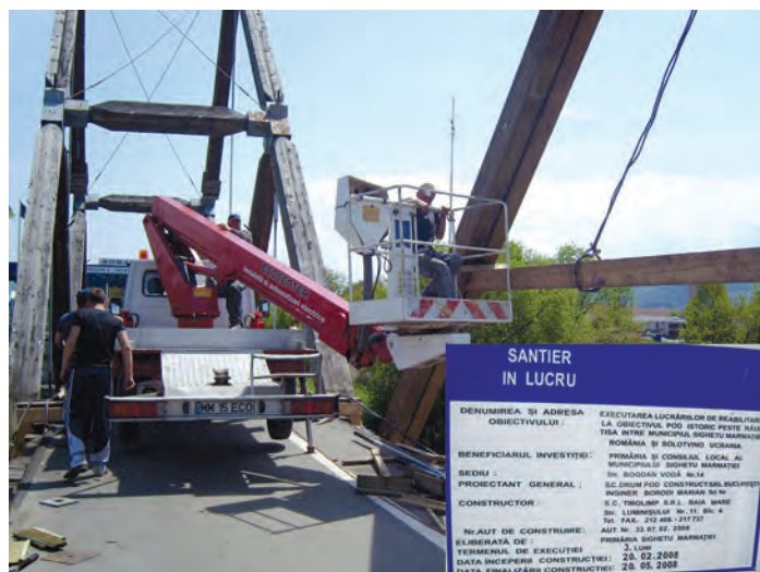
Fig. 185 - Podul de lemn peste râul Tisa, la Sighetu Marmăției. Fază de lucru la înlocuirea contrafișelor din deschiderea 2. (Foto, A. Tiberiu, 2008)
