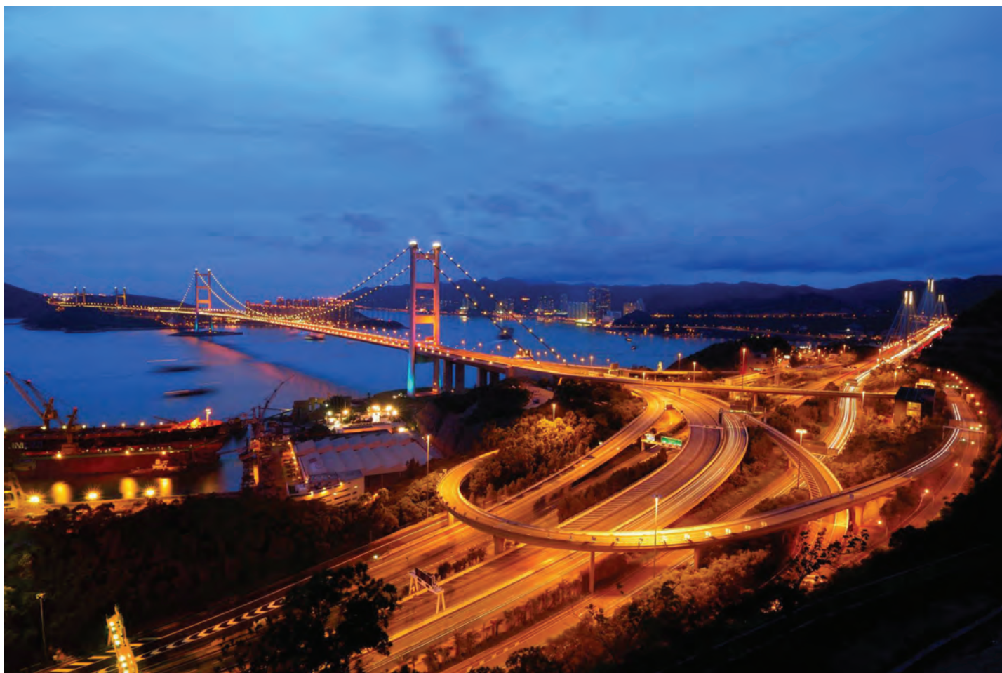
Fig. 21 - Tsing Ma Bridge având în prim plan deschiderea de ancoraj Tsing Yi și accesul aferent susținut de piloți
