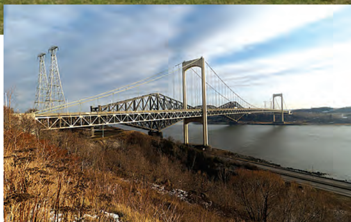
Fig. 5 - Podul suspendat Pierre-Laporte privit din vest, în aval de acesta fiind podul din oțel cu zăbrele Quebec Bridge
