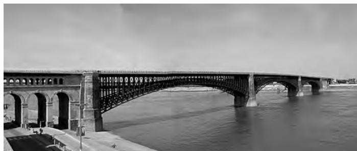
Fig. 11 - Vedere a podului EADS privit din aval, de pe cheul portului St. Louis Missouri. Se remarcă accesul la pod dinspre St. Louis City, cu trei deschideri boltite din piatră, având pile înalte care susțin atât circulația rutieră, de la extradossalul podului, dar și calea de rulare a celor două noi linii de metrou, care au înlocuit circulația feroviară inițială
