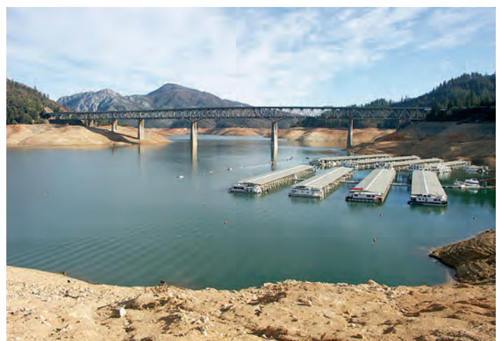
Fig. 9 - Vedere de ansamblu a structurii PIT BRIDGE și organizarea de șantier lacustră, în curs de reamplasare
