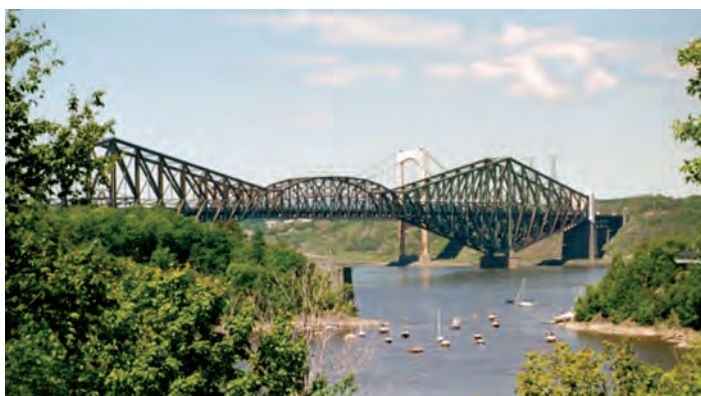
Fig. 4 - Elevația podului Quebec, dintr-un unghi mai bun, din care se vede mai bine unul din pilonii podului suspendat
