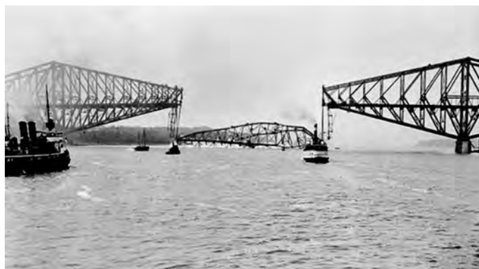
Fig. 1 - Imagine obținută după a doua prăbușire a deschiderii centrale a podului Quebec
