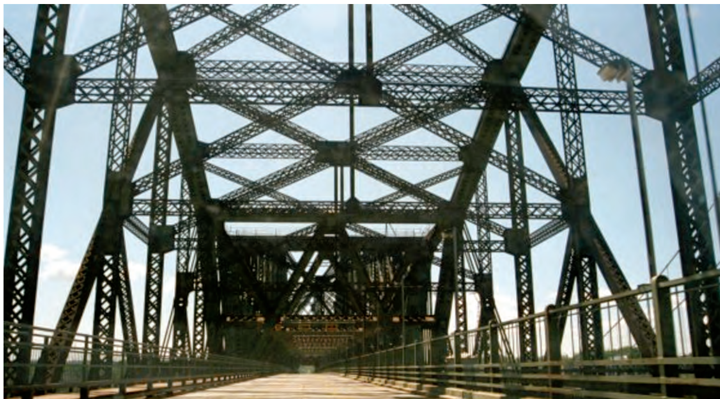
Fig. 2 - Vedere în lungul podului Quebec din interiorul tablierelor suprastructurii. În stânga este trotuarul pietonal, în dreapta, linia CF, iar zona centrală a tablierelor a fost rezervată circulației rutiere de pe ruta 175
