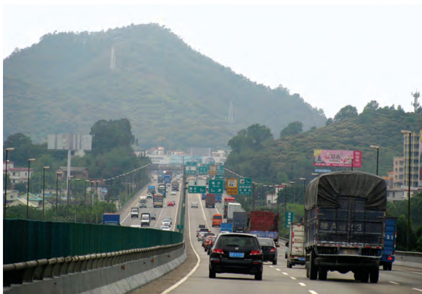
China și-a început construcția de drumuri expres abia după ce a construit cele mai importante autostrăzi: Drumul expres Dongguan-Foshan
