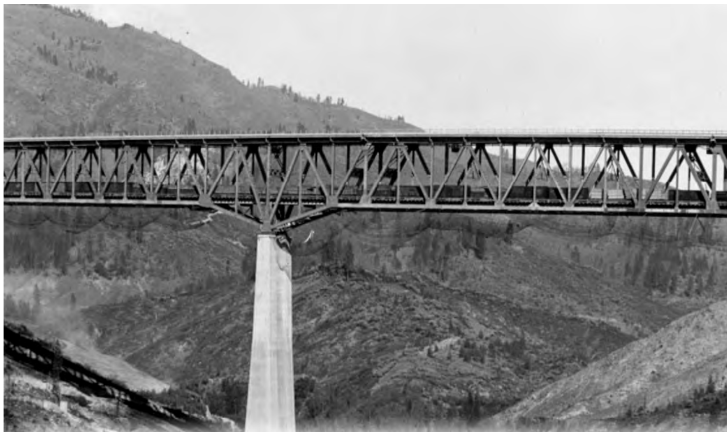
Fig. 7 - Detaliu de interconectare a pilei din estul deschiderii principale cu tablierul structurii Pit Bridge, sub solicitarea unui convoi de cale ferată
