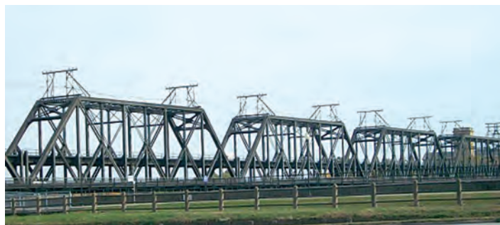
Fig. 13 - Imagine a podului Arsenal în care se vede la semi-înălțime elevația tablierului de cale ferată precum și circulația rutieră de pe platelajul susținut de talpa inferioară a structurii
