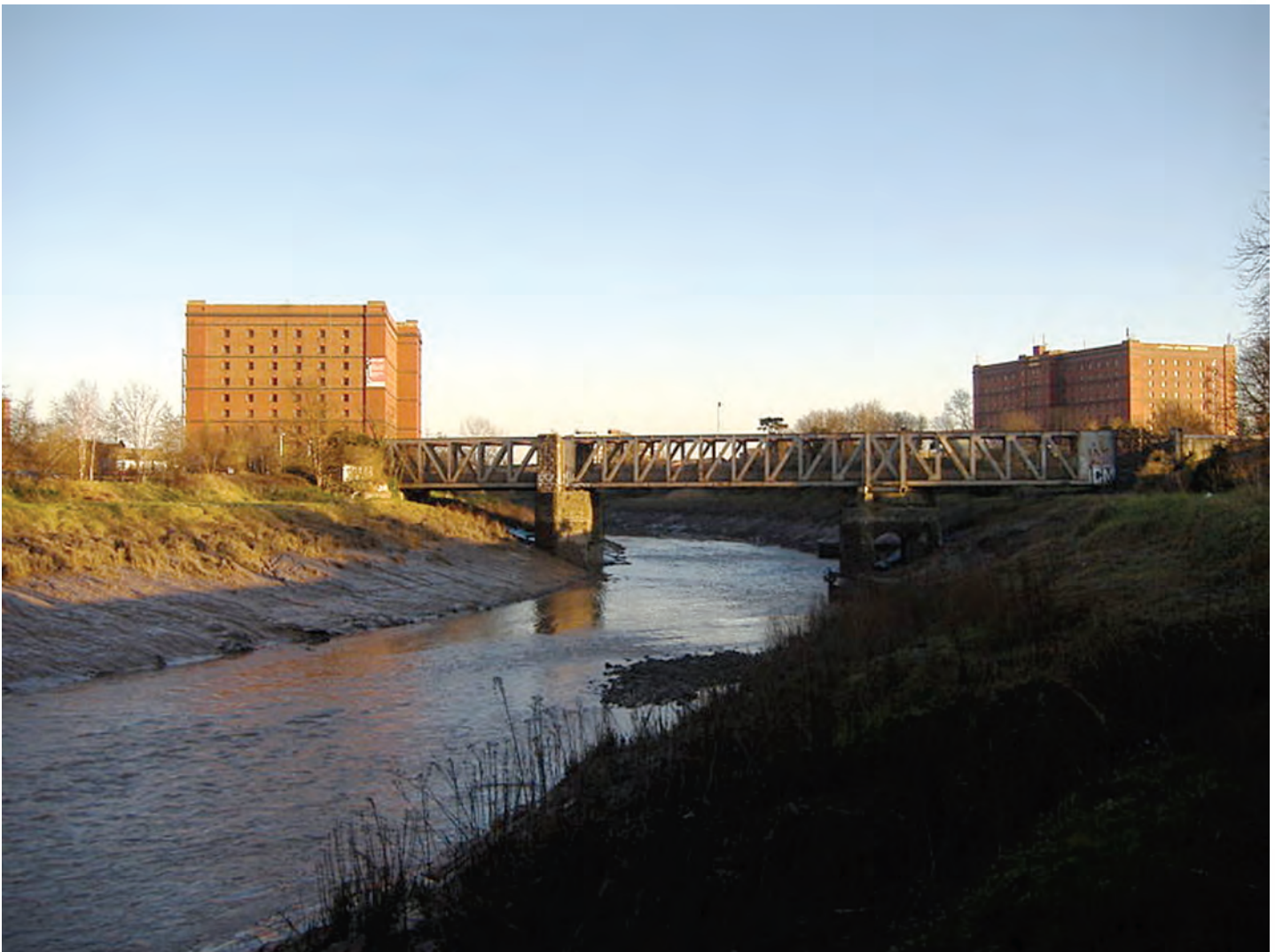
Fig. 25 - Podul Ashton Swing Bridge, văzut din lateral, traversează Avon River, la periferia orașului Bristol
