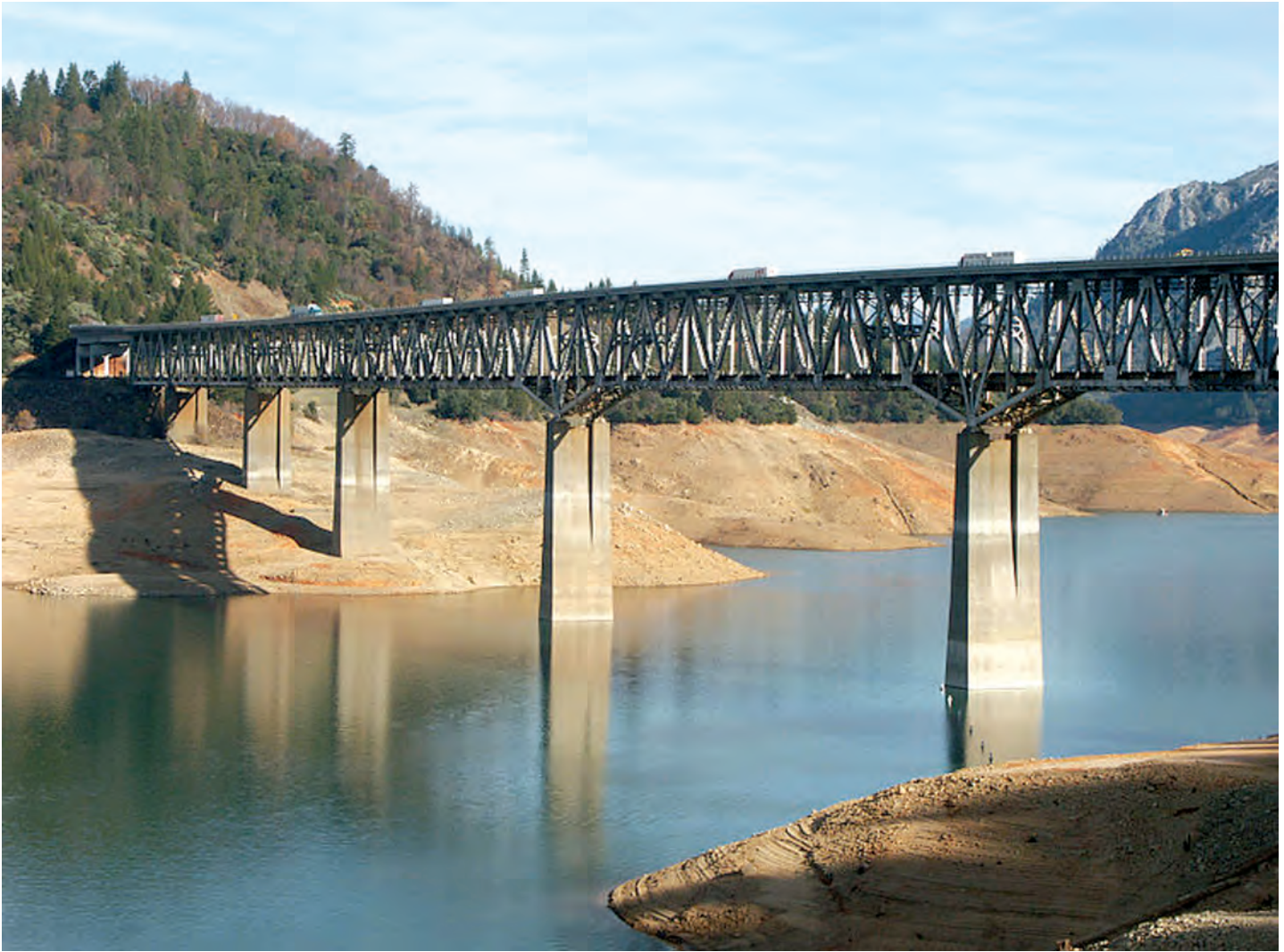
Fig. 8 - Podul Pit sub circulația rutieră curentă
