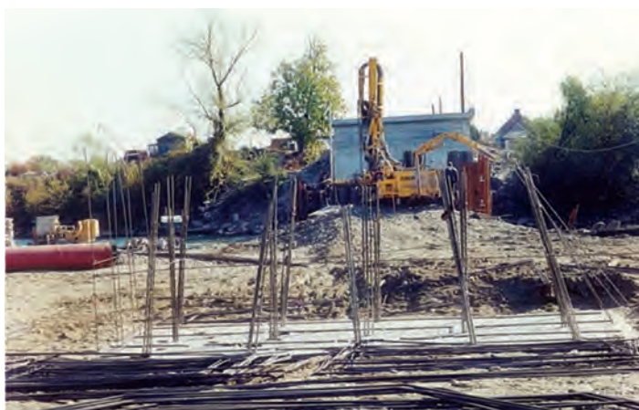
Fig. 180 - Podul de lemn peste râul Tisa, la Sighetu Marmăției. Fundația pilei P 01 . În planul doi, instalația pentru execuția minipiloților (Foto, P. ROMAN, 2001)
