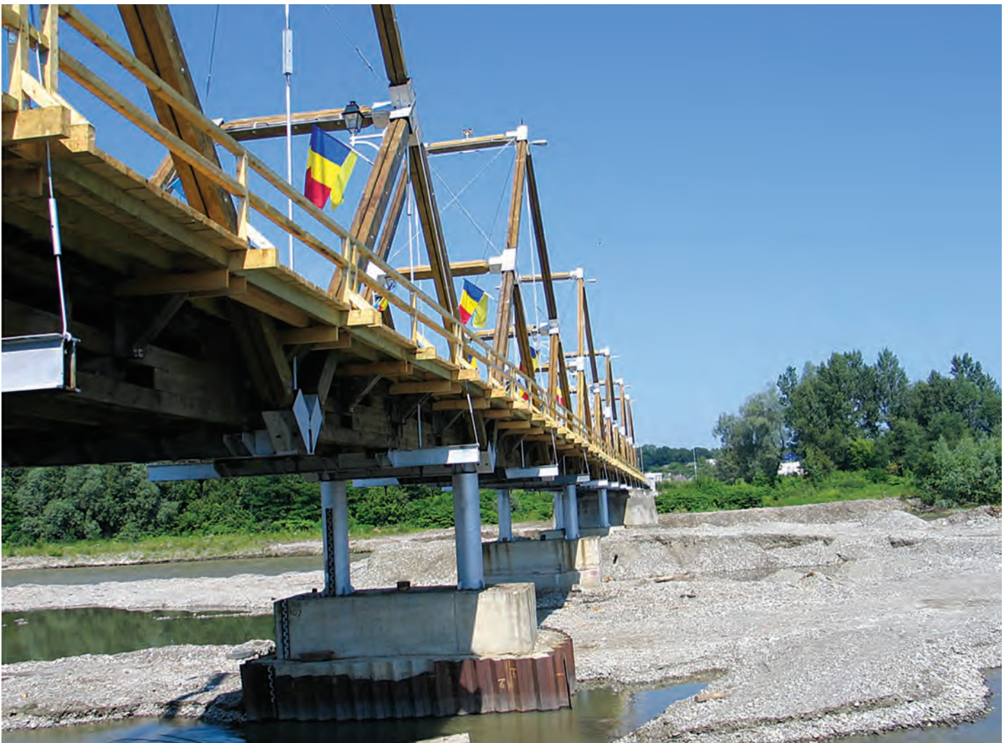
Fig. 178 - Podul de lemn peste râul Tisa, la Sighetu Marmăției. Elevația amonte, văzută în lungul podului, de pe malul stâng al râului Tisa (Foto, S. FLOREA, 2008)
