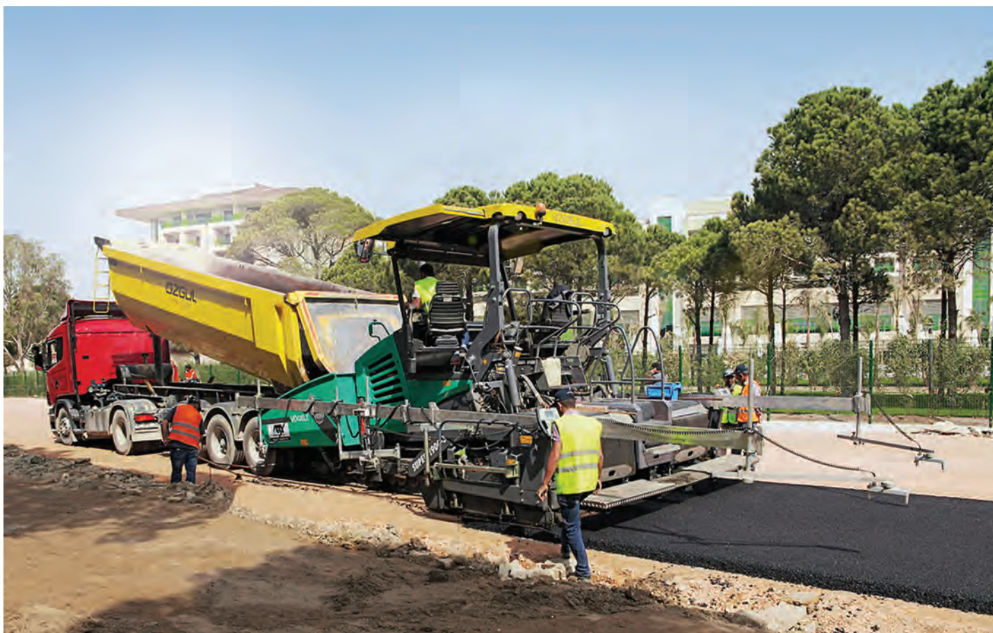
Noul "PaveDock Assistant" elimină neînțelegerile inerente între șoferul basculantei și operatorul finisorului, în timpul transferului mixturii asfaltice din basculantă către buncărul finisorului
