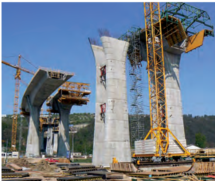
Fig. 3 – Execuția podurilor în consolă
