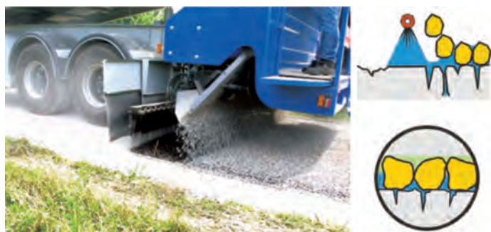
Figura 3 - Realizarea tratamentului cu utilaj tip „Chipsealer” prin repartizarea suprapusă a liantului și criblurii
