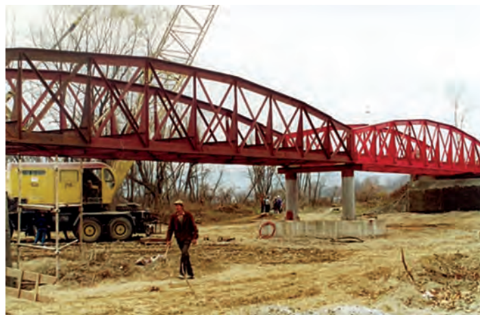
Fig. 175 - Podul de lemn peste râul Tisa, la Sighetu Marmăției. Tablierele metalice de cale ferată din amplasamentul liniei cf părăsire de la Cămara Sighet, refolosite pentru noul pod rutier peste râul Tisa. (Foto, P. ROMAN, 2001)
