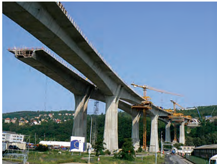
Fig. 1 – Vedere generală din timpul execuției
