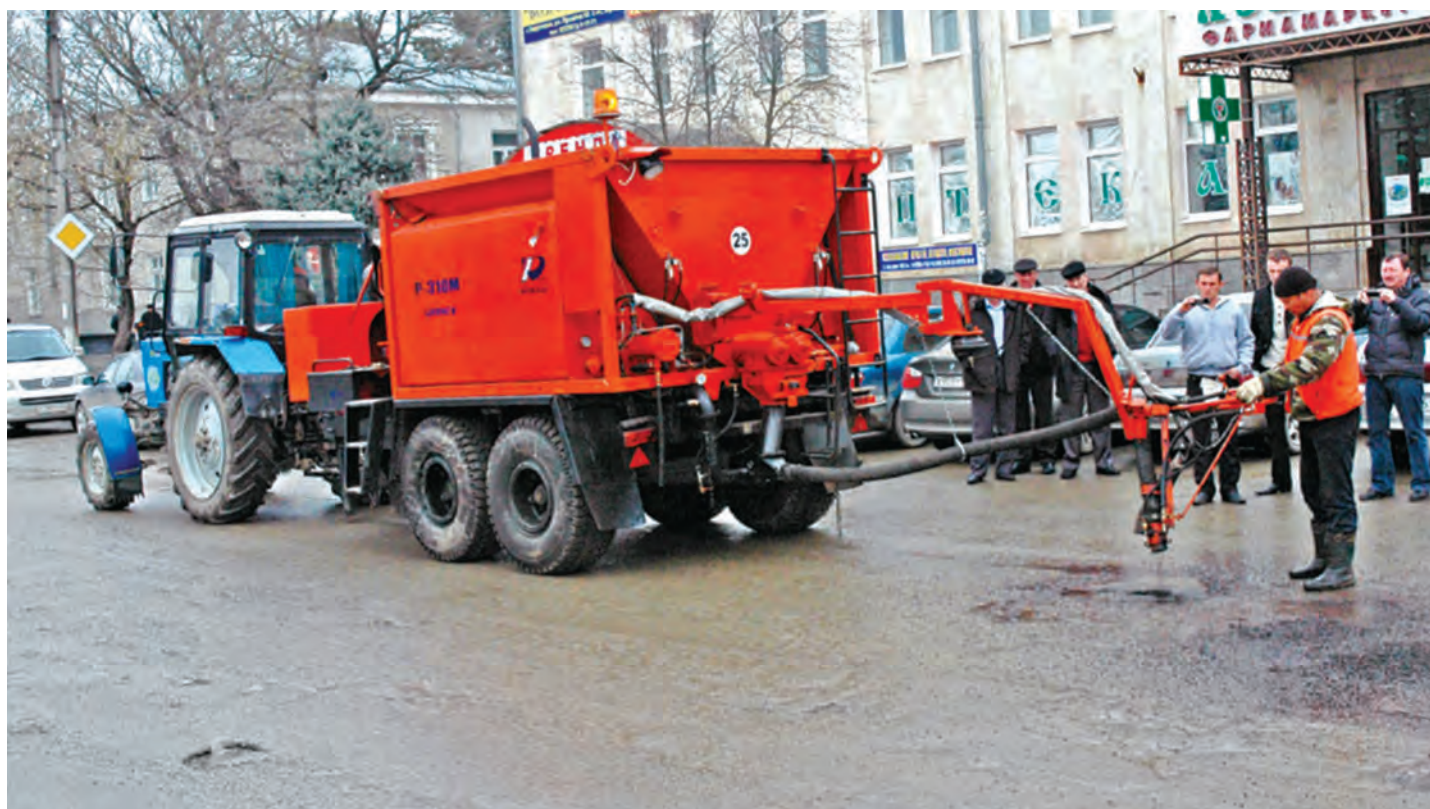
Figura 1 - Utilajul R-310M pentru reparația defectelor prin torcretare
