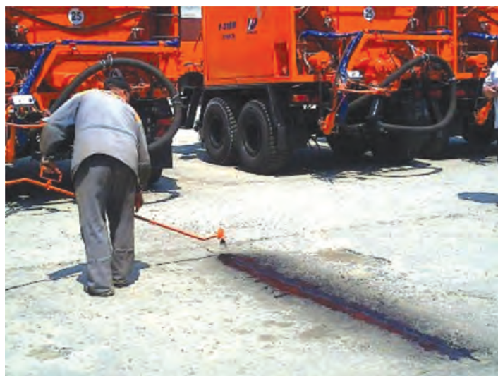
Figura 2 - Reparația prin torcretare: a) Colmatarea crăpăturii; b) Plombarea gropii în straturi succesive
