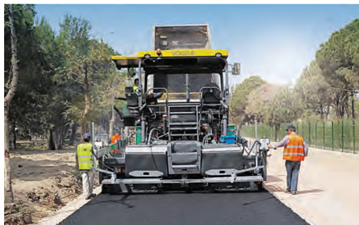
Execuție de calitate: grinda extensibilă cu tamper și vibratori
