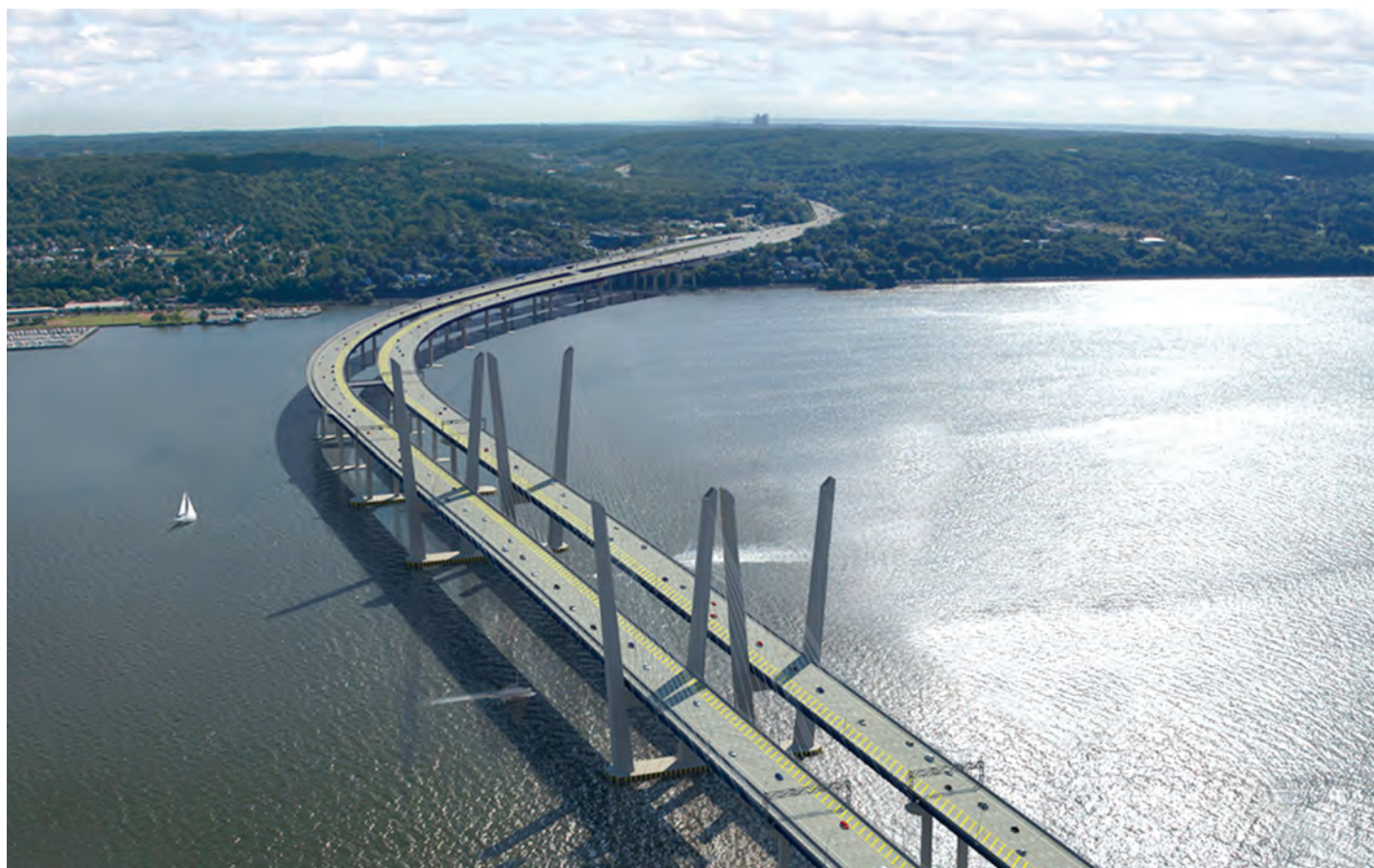
Fig. 5.5 - Vedere de ansamblu a noului Tappan Zee Bridge
