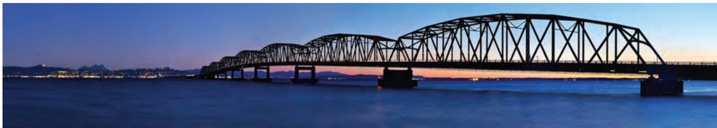
Fig. 11.2 - Deschiderile podului din vecinătatea statului Washington, de pe malul drept al fluviului Columbia, văzute în lumina crepusculară a soarelui, care se retrage încet undeva, dincolo de Cascade Mountains.
