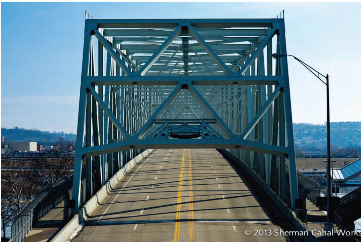
Fig. 7.2 - Vedere în lungul suprastructurii podului Taylor-South Gate
