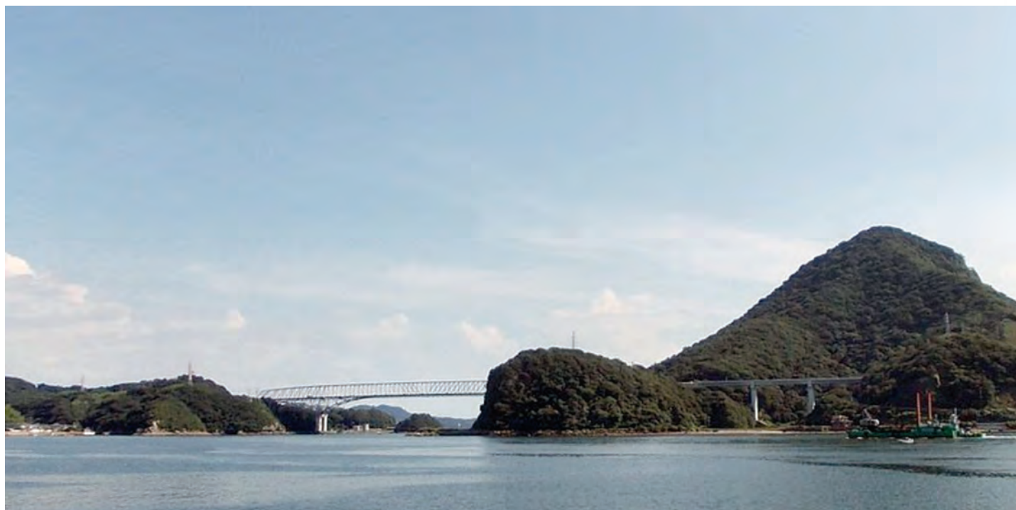
Fig. 8.3 - Imagine a muntelui cu două cocoase, acoperit de verdele tomnatic al pădurilor din jur care, împreună cu stâlpii de telecomunicații de pe culmi, supraveghează circulația rutieră de pe podul Tenmon, lipsit de monorai
