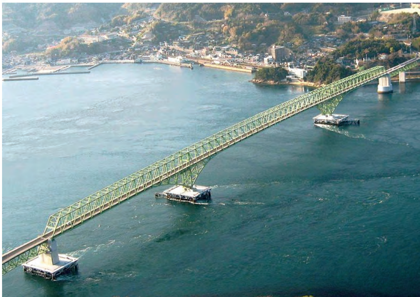
Fig. 9.1 - Oshima Truss Bridge, având tablierul principal cu trei deschideri cale jos
