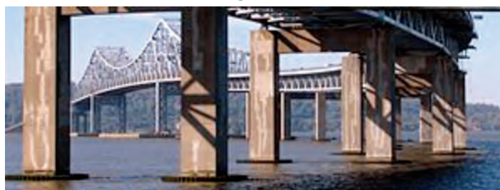
5.1 - Primul Tappan Zee Bridge fotografiat din Nord-Vest
