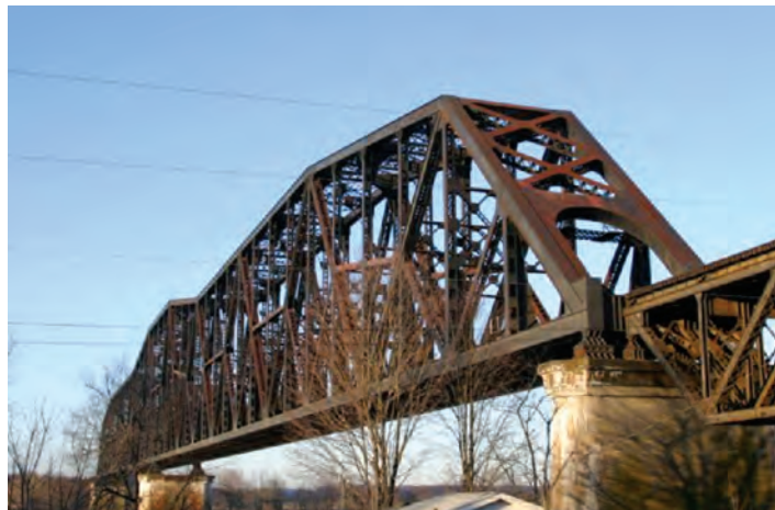
Fig.1.2. Imagine de toamnă târzie în care se văd cele două deschideri principale având calea la talpa inferioară. Pe pila din dreapta se disting reazemele tablierului central și ale deschiderii de racordare cu viaductul de acces din Ohio.
