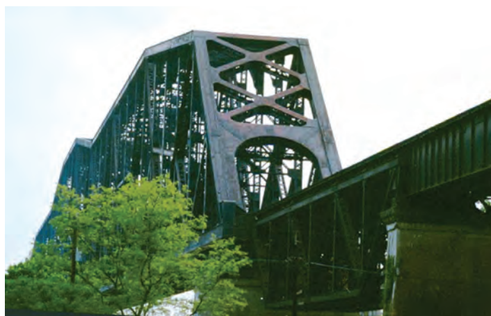
Fig.1.3. Imagine în peisaj de vară a celor două deschideri principale. În fotografie se vede și prima pilă a viaductului, care susține grinzi cu inimă plină având calea la talpa de sus. De asemenea, se vede destul de bine deschiderea de racordare, având calea la talpa superioară care realizează trecerea de la tablierul central la prima deschidere a viaductului din statul vecin.
