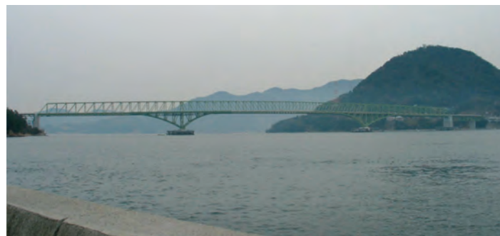
Fig. 9.3 - Vedere din lateral a podului Oshima Truss Bridge
