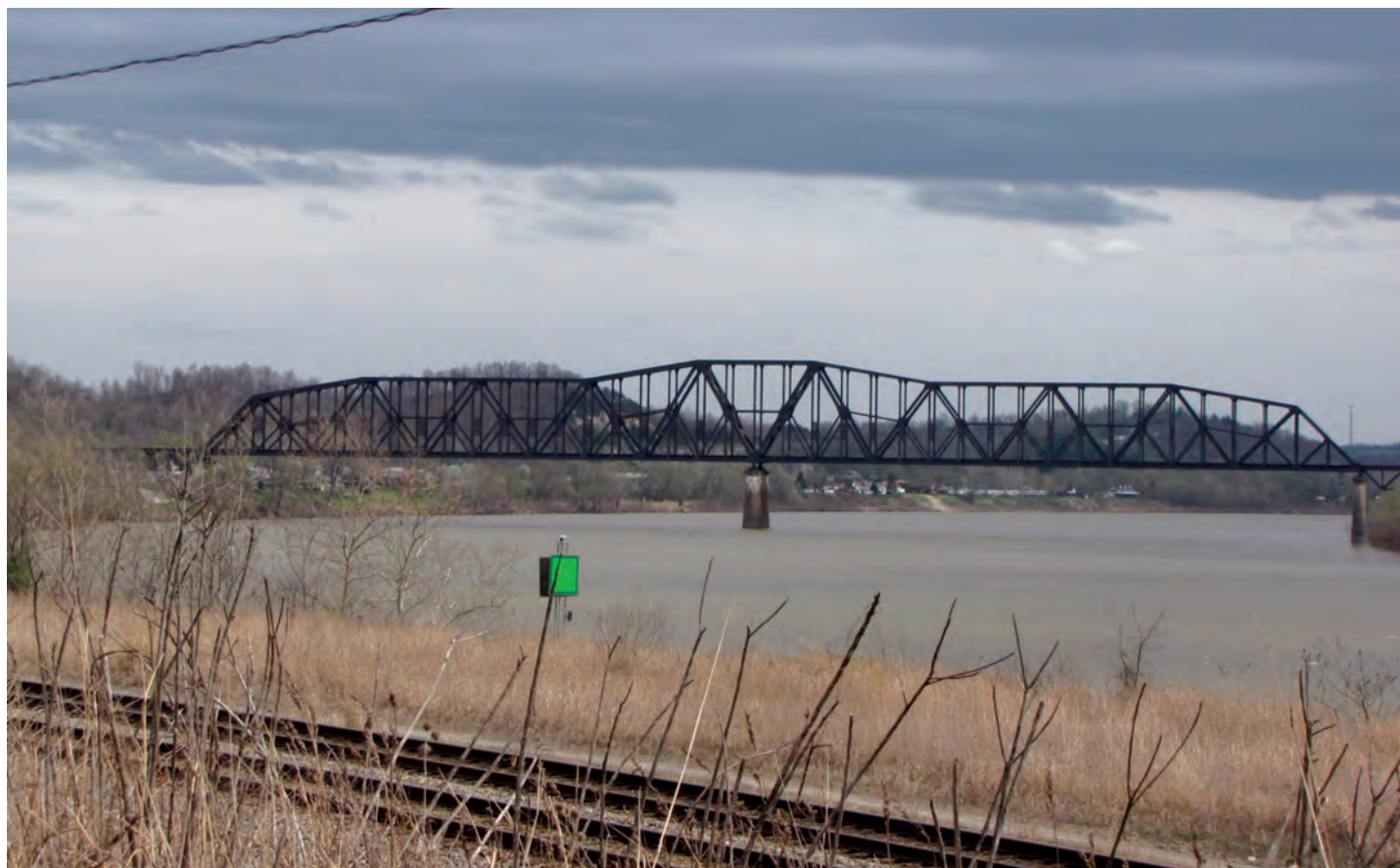
Fig. 1.1 Pila centrală încadrată de cele două deschideri simetrice, sub cerul care prevestește prima ninsoare. În stânga tablierului central se întrezăresc deschiderile viaductului de acces din Kentucky.
