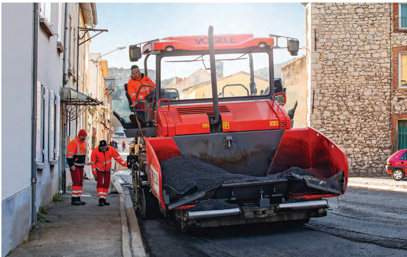
Super flexibilitate: lățimea grinzii poate varia continuu prin comandă de la un buton rotativ comandă, care ia în considerare cele mai strânse curbe ale drumului sau bordurile.
