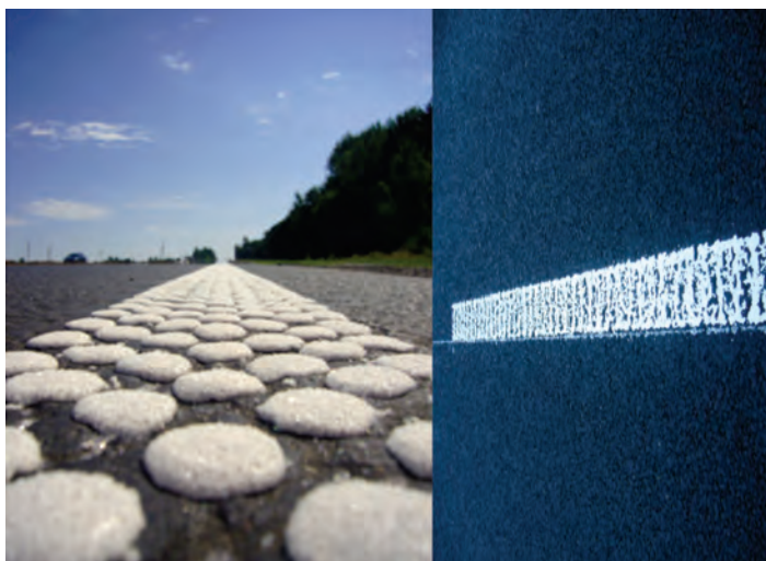
Figura 1 - Marcaj texturat regulat (stânga) și stocastic (dreapta) cu rășină activată la rece
