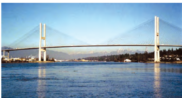
Figura 10.2 - Vedere laterală a podului Alex Fraser sub circulație
