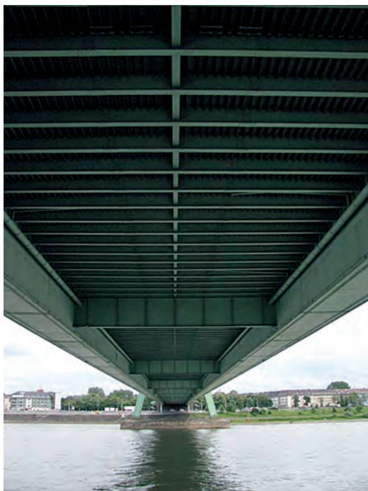
Figura 6.2 - Perspectivă de la nivelul Rinului a intradosului tablierului podului Severin. Se văd și cuzineții de racordare a fundației cu stâlpii oblici care alcătuiesc pilonul podului.
