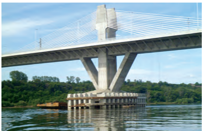
Figura 9.2 - Una din pilele podului Calafat-Vidin
