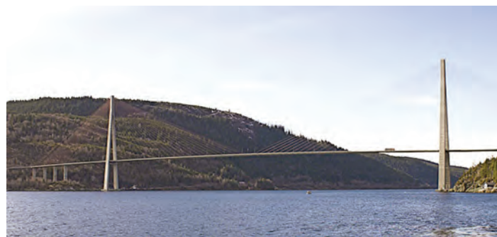
Figura 11.2 - Deschiderea laterală din sudul podului este susținută de cablajul lateral al pilonului aferent și, prin conlucrare, de cele patru coloane (forate ?) solicitate la întindere
