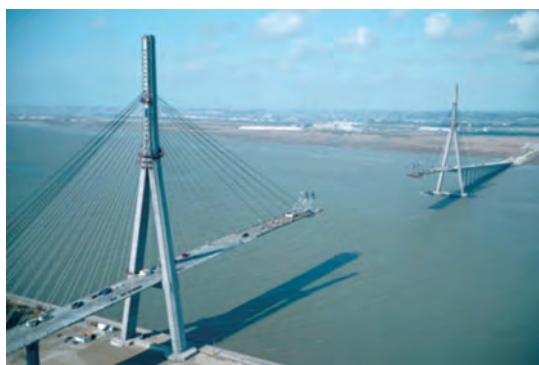
Figura 14.2 - Construcția tronsoanelor din deschiderea centrală a podului
