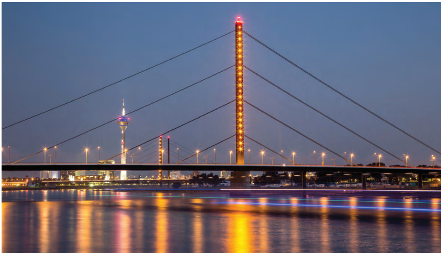
Figura 5.2 - Podul Oberkasseler cu un singur pilon plus opt hobane
