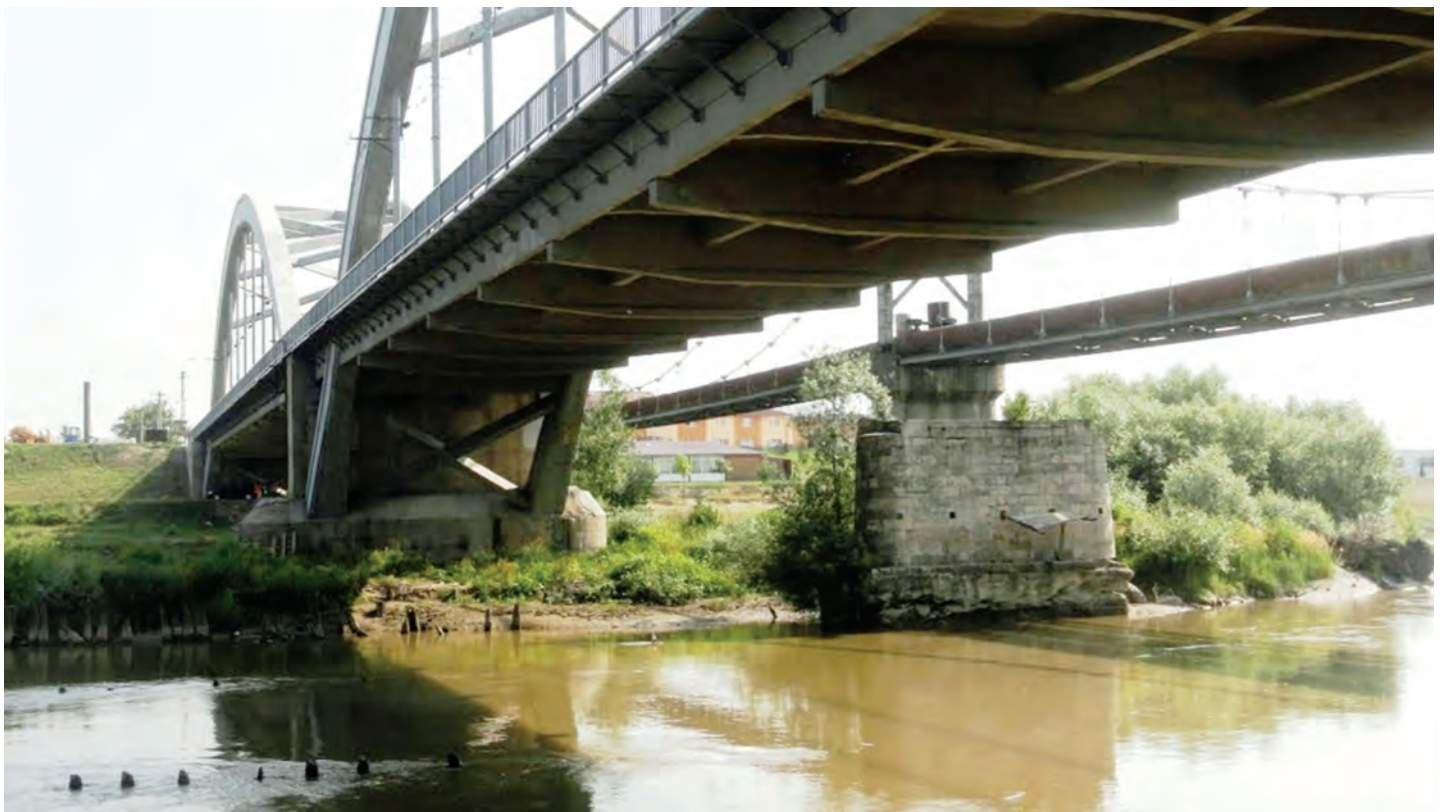
Fig. 150 - D.N. 1 Sebeș - Alba Iulia, km 375 + 769, pod peste râul Mureș, la Partoș. (Foto S. FLOREA, 2013)
