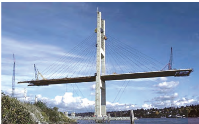
Figura 10.1 - Pilă a podului cu execuția în consolă a tablierului
