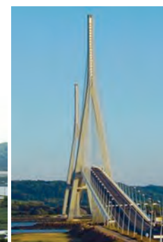
Figura 14.4 Rampă de acces la deschiderea principală
