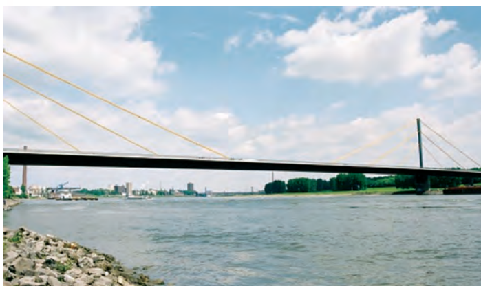
Figura 7 - Deschiderea principală a podului Duisburg-Neuenkamp după punerea lui în circulație
