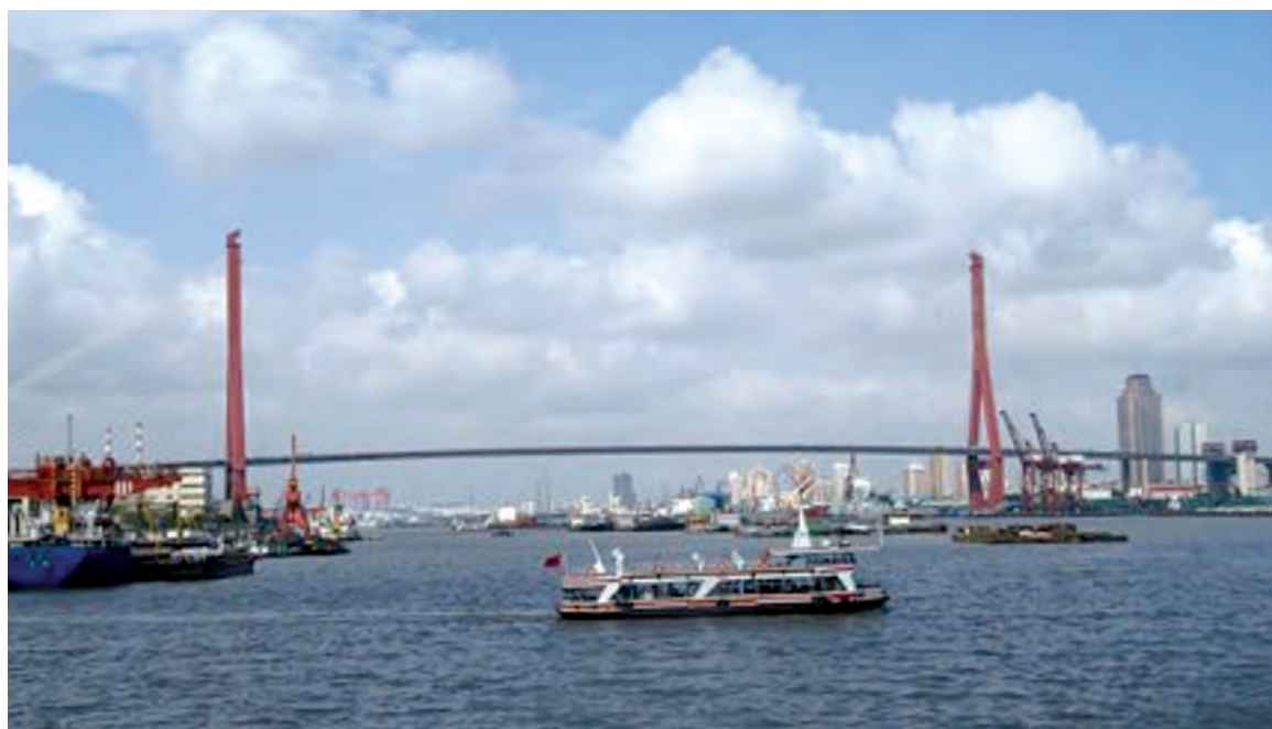
Figura 12.1 - Deschiderea centrală a podului Yangpu și navigația pe fluviul Hangpu
