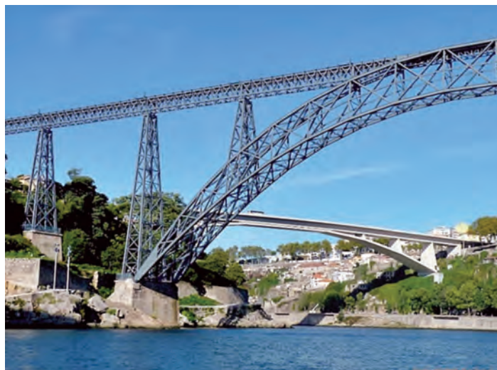
Fig. 5b - Arcul metalic cu zăbrele Maria Pia, aflat în exploatare după mai mult de 100 de ani sub circulație. Elegantul pod din beton armat Don Infante Henrique, mult mai tânăr, se vede în planul secund al imaginii
