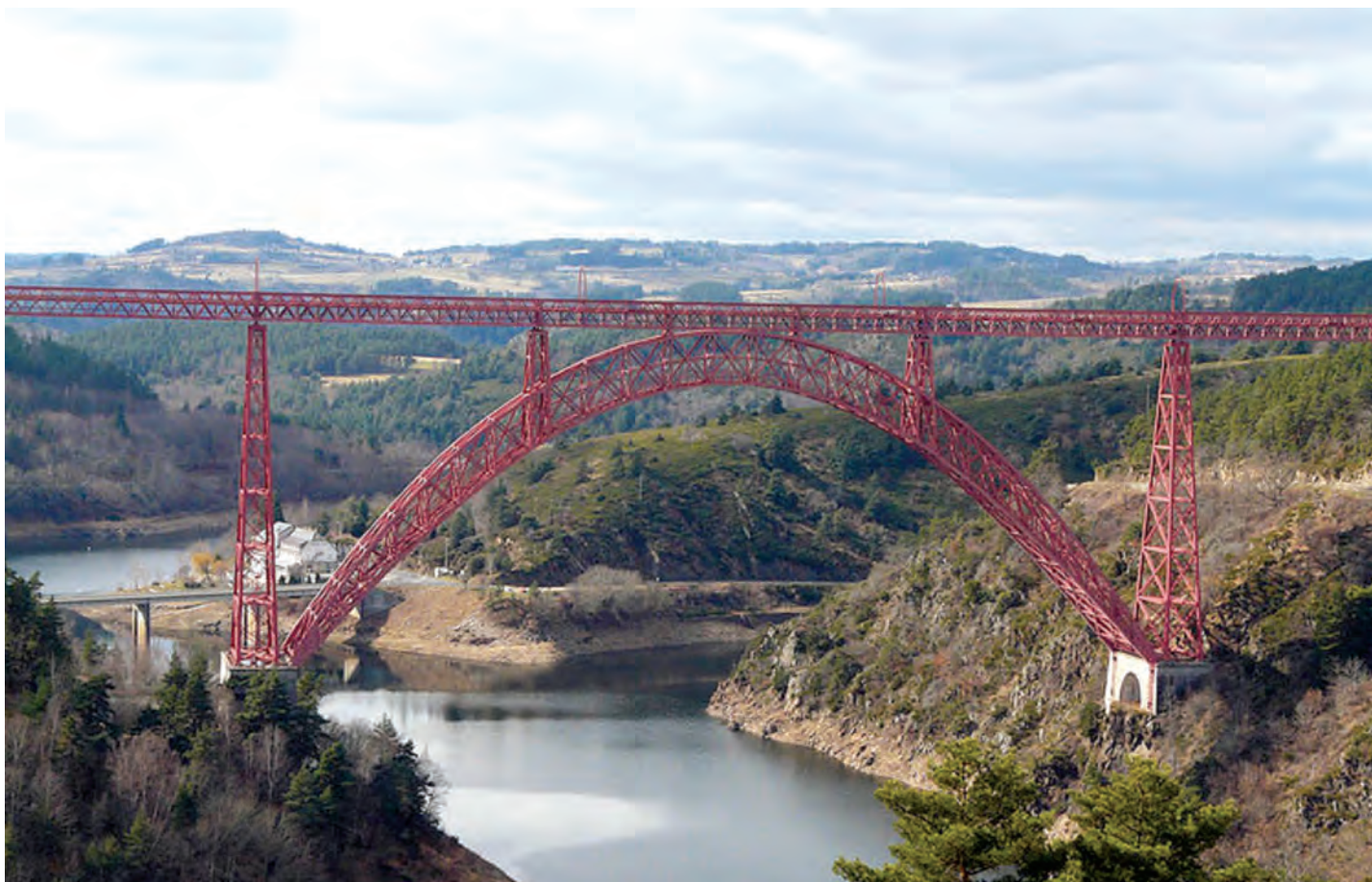
Fig. 6b - Viaductul Garabit și suprastructura sa având platelaje suprapuse deasupra arcului și pilonilor
