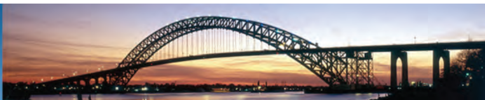
Fig. 10b - Aici se menționează că podul dintre Staten Island, NY și Bayonne, NJ este parcurs anual de peste 7.000.000 vehicule
