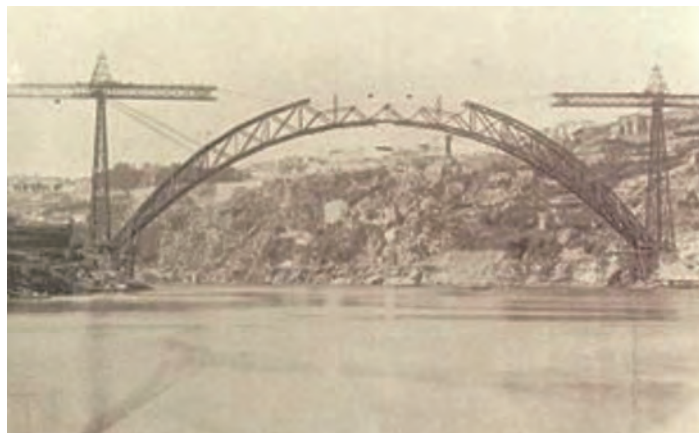
Fig. 5a - Podul Maria Pia în faza de completare a închiderii arcului la extrados prin montajul barelor lipsă
