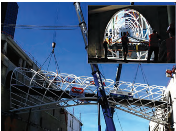
Imagine din timpul execuției: fixarea podului pe cele patru reazeme montate în prealabil
