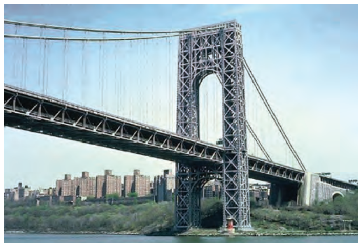
Fig. 12 - Din anul 1962, George Washington Bridge are două platelaje pe care trec anual mai mult de 100 milioane de autovehicule
