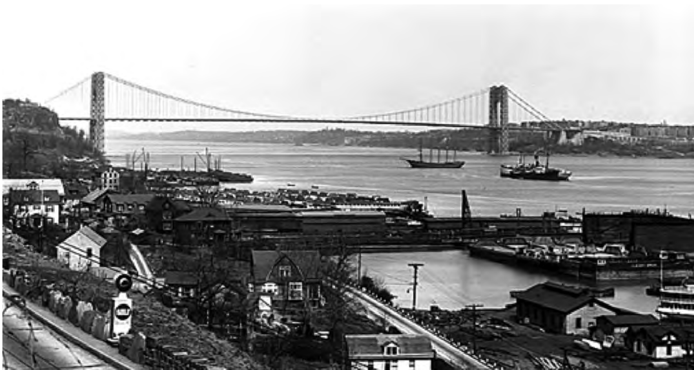
Fig. 10 - George Washington Bridge, în anul inaugurării. În prim plan, Palisade - New Jersey
