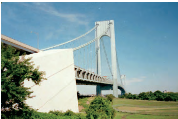
Fig. 16 - Vederea ancorajului sudic din Richmond County, Staten Island
