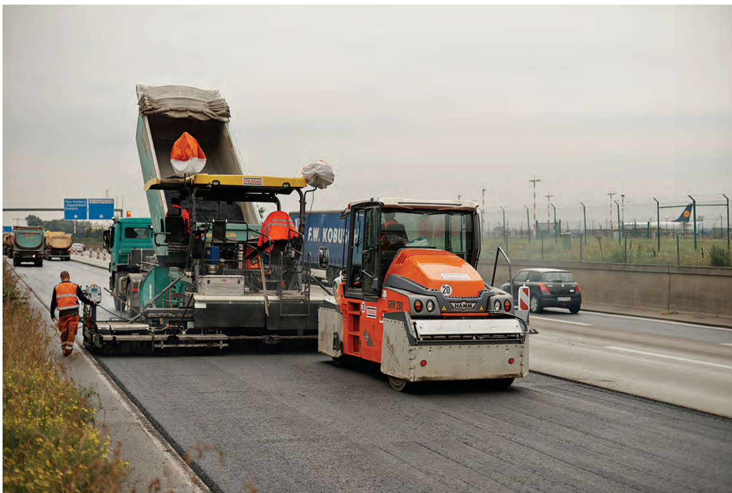
Compactorul pe pneuri GRW280 și finisorul Super 1900-2, o echipă experimentată
