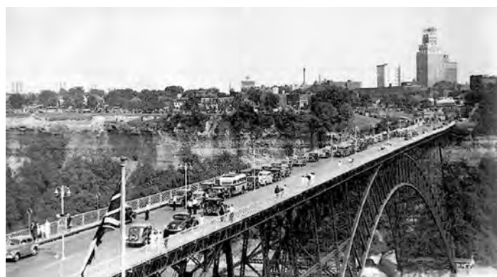
Figura 20 - Honeymoon Bridge solicitat de mașinile turiștilor veniți la Niagara Falls. Fotografia a fost făcută în 1937, un an înainte ca podul să se prăbușească sub presiunea ghețurilor
