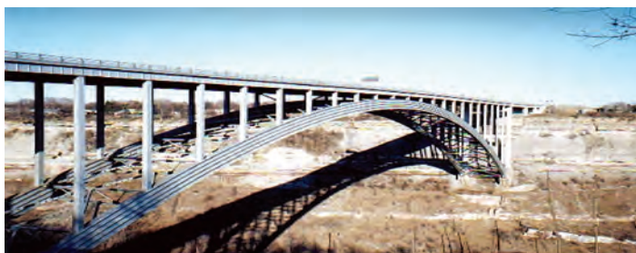
Figura 9 - Actualul Lewiston-Queenston Arch Bridge, pod metalic, cu două arce cu inimă plină rigidizate longitudinal
