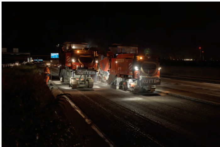
Nouă freze de 2,0 m și trei freze de 1,0 m au decapat cca. 14.000 t asphalt și stabilizat într-o noapte
