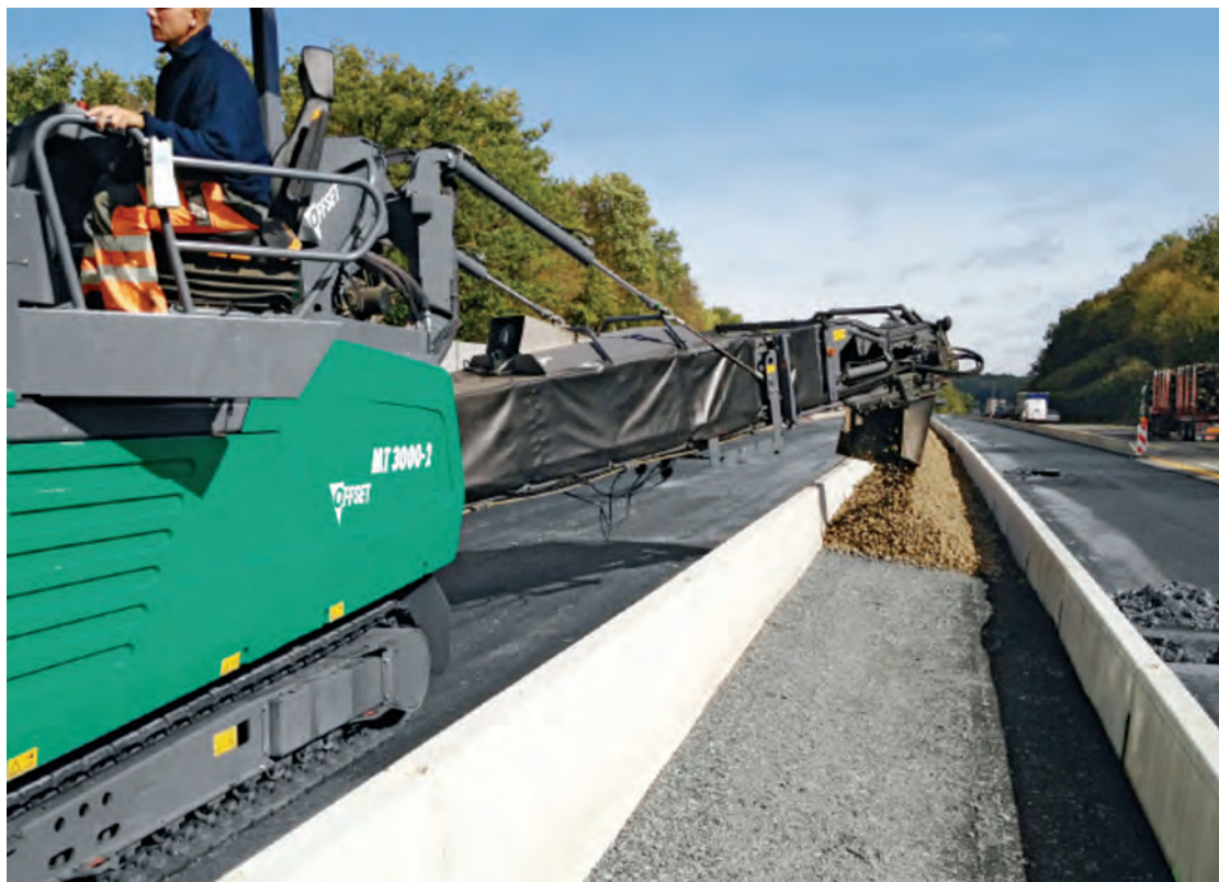
Utilizarea benzii pivotante pentru repartizarea în spații înguste, inaccesibile în alt mod
