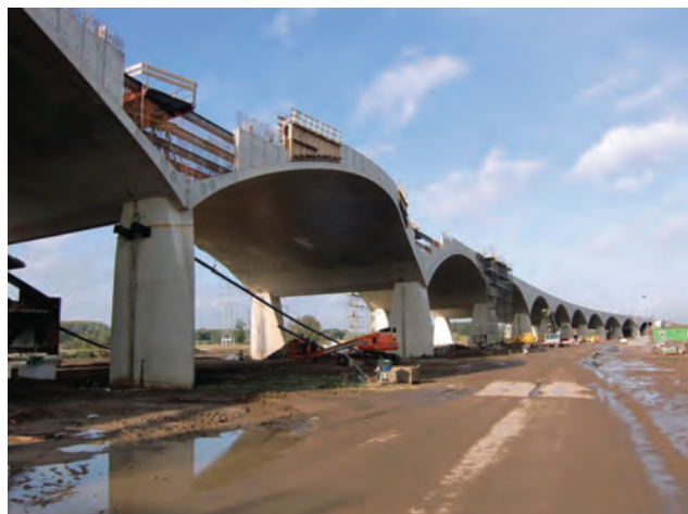
Imagini din timpul execuției podului
