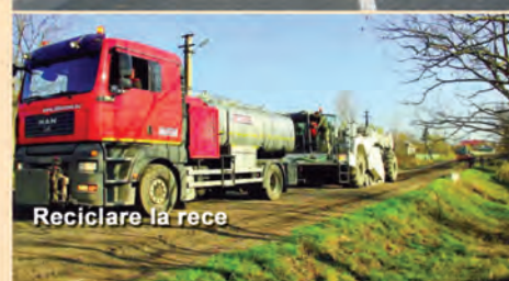
Execuție tratamente bituminoase
