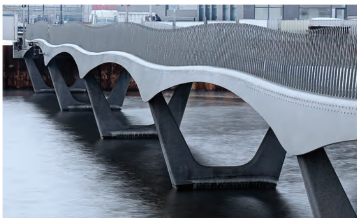
Vedere generală a podului Vluchthaven
