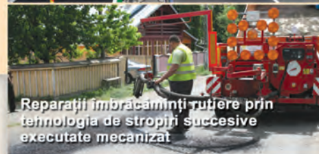
Execuție straturi bituminoase foarte subțiri la rece
