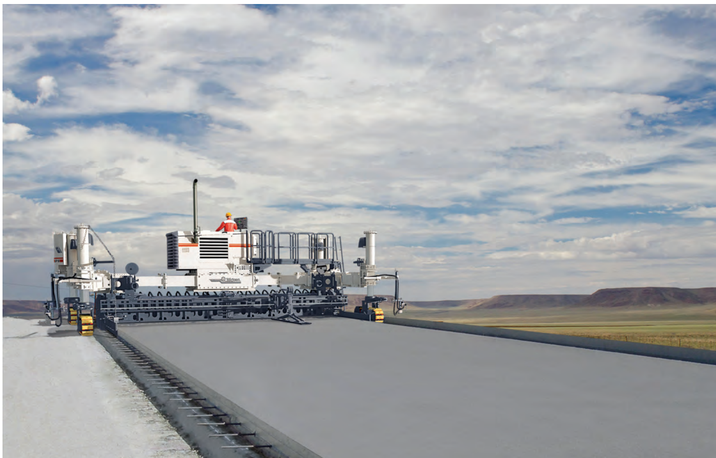
La solicitarea clientului, SP 84/SP 84i poate turna beton și cu grosimi mai mari decât grosimea standard de 400 mm.
