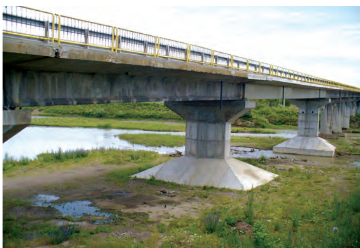
Podul de la Dornești (D.N. 17A) reparat în urma inundațiilor din 2010. Suprastructura din beton a fost înlocuită cu suprastructură metalică
