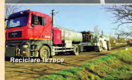
Execuție tratamente bituminpase
