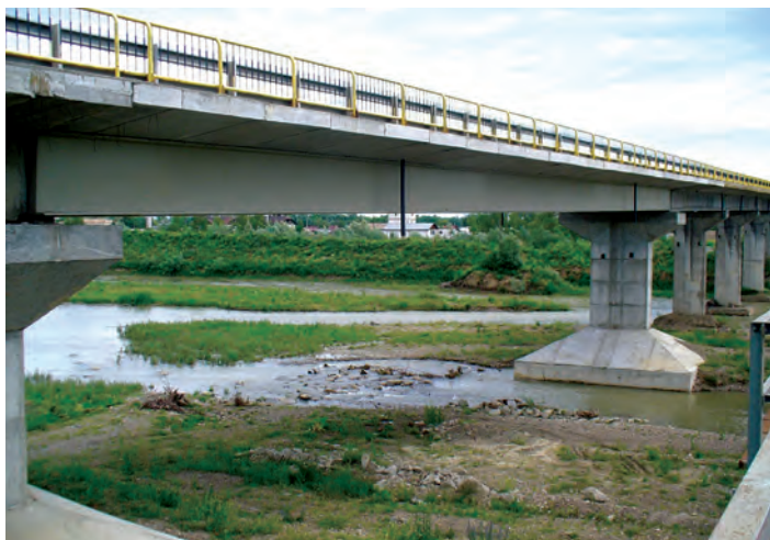
Podul de la Dornești (D.N. 17A) reparat în urma inundațiilor din 2010. Suprastructura din beton a fost înlocuită cu suprastructură metalică
