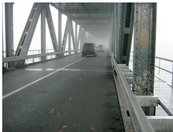
Calea de rulare a Podului Cosmești, cu noile rosturi de îmbinare
