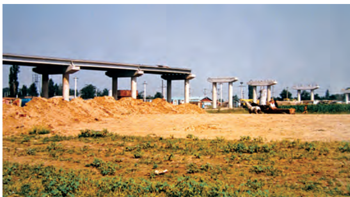
Faze de execuție – viaduct București – pile și suprastructuri montate
