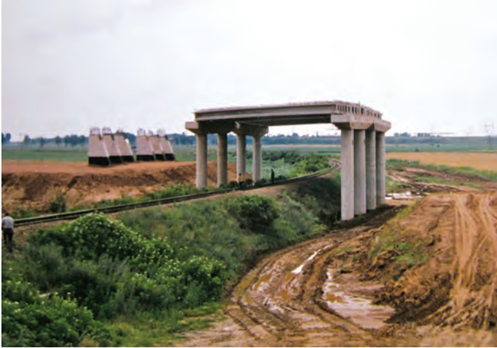
Faze de execuție – culeele sunt de tip „încate în terasamente”
