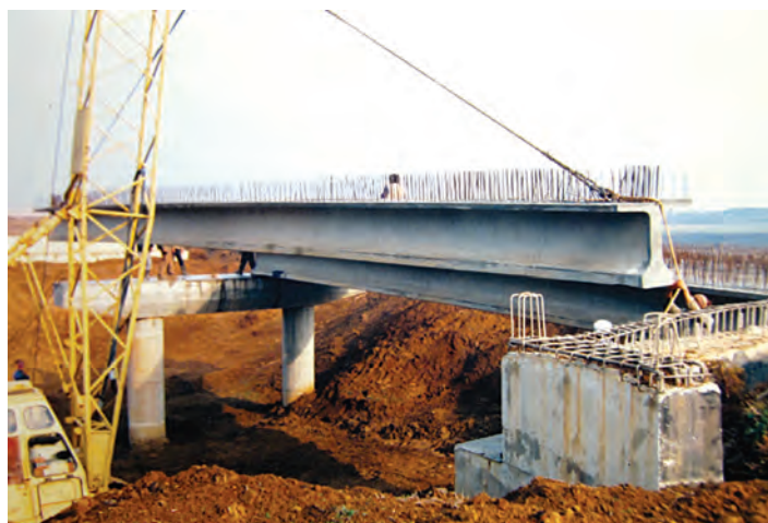
Montarea unei grinzi precomprimate
