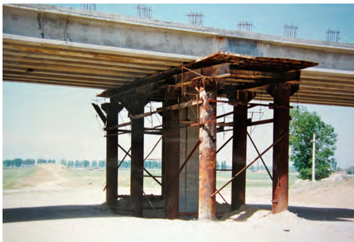
Rezemarea grinzilor în vederea betonării nodului de cadru
