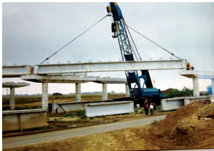
Montarea unei grinzi precomprimate cu macaraua
