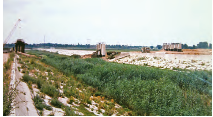
Fază de execuție – culee și pile
