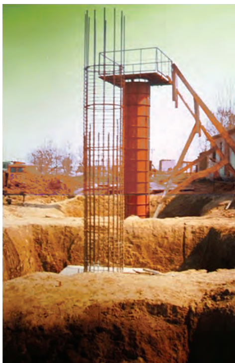
Armarea și cofrarea stâlpilor de pilă
