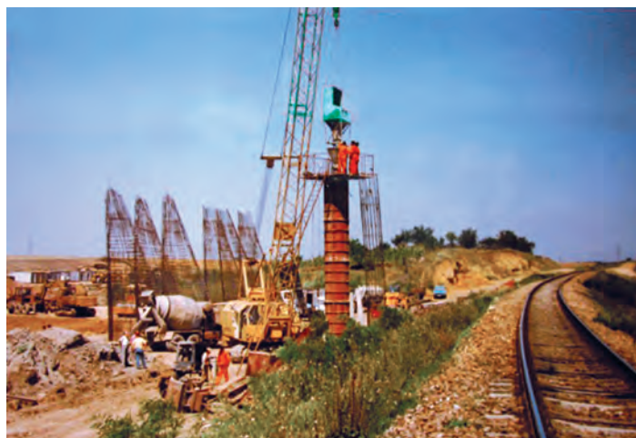
Betonarea stâlpilor de la pile
