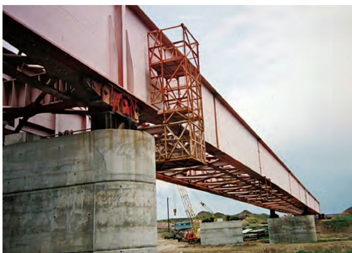
Tablierul lansat complet
