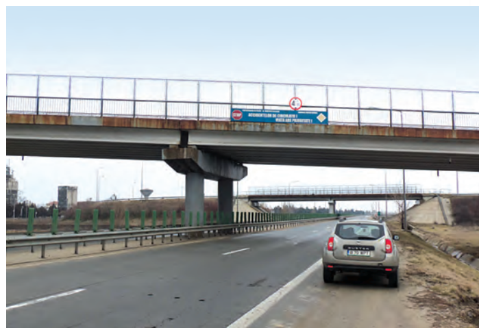
Vedere dinspre București a viaductului, în zona traversării autostrăzii
