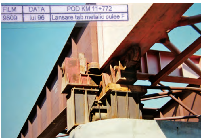
Ciocul de lansare și dispozitivul cu role pentru ghidarea tablierului în aliniament
