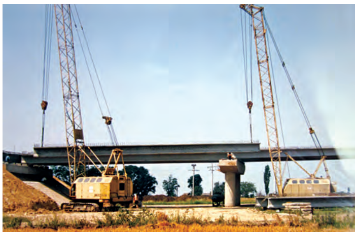
Montarea unei grinzi în deschidere
