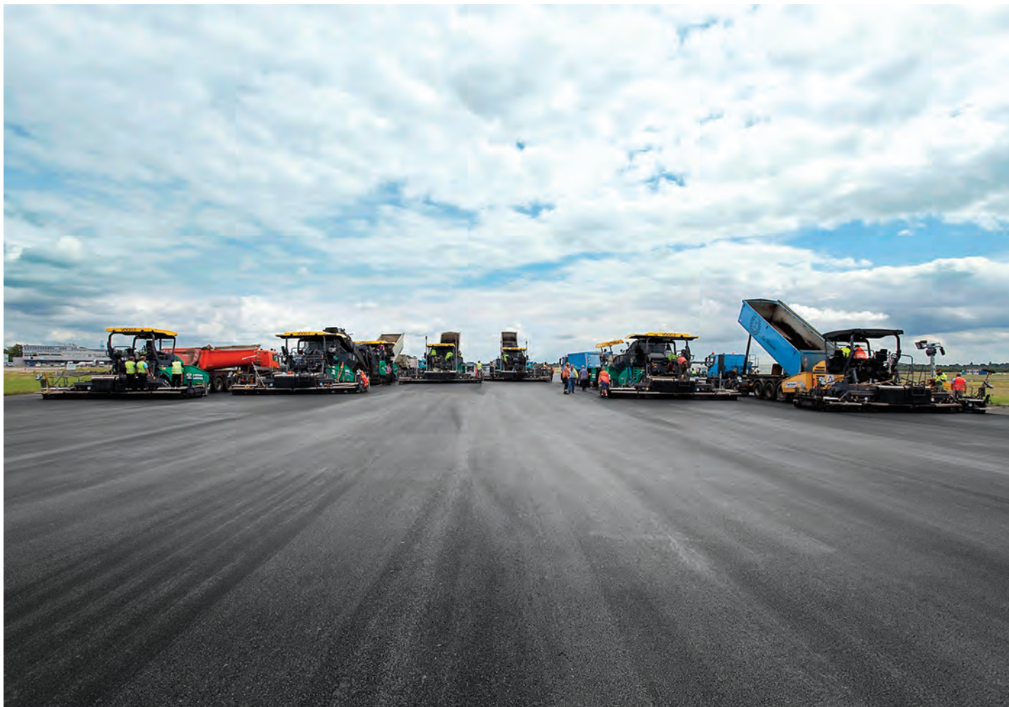
Reabilitarea îmbrăcămintei asfaltice din Aeroportul din Bremen: calitate superioară aproape instantaneu, datorită tehnologiei VÖGELE
