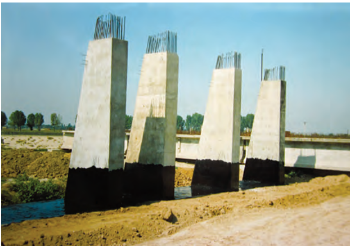
Fază de execuție – culee încate
