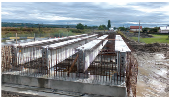
Grinzi prefabricate din beton precomprimat, cu armătură postîntinsă la Podul Gârleni
