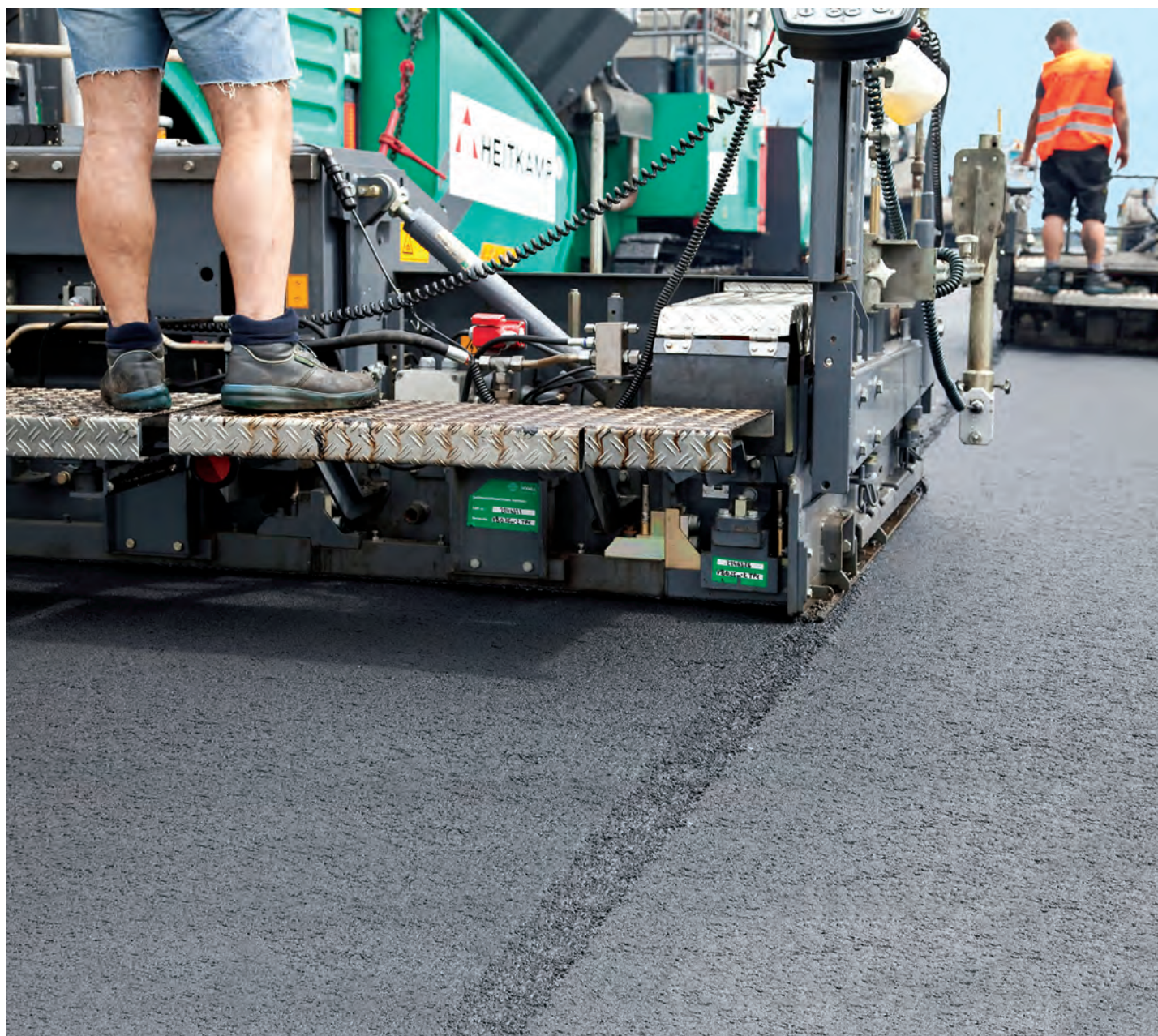
Turnare „la cald” pentru îmbinarea optimă a benzilor adiacente
