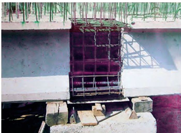
Armarea rostului dintre două tronsoane prefabricate
