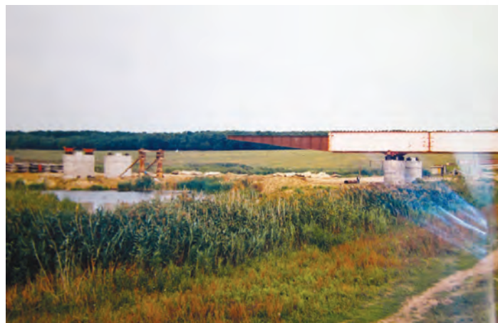
Lansarea grinzii metalice în deschidere – faza a 2-a
