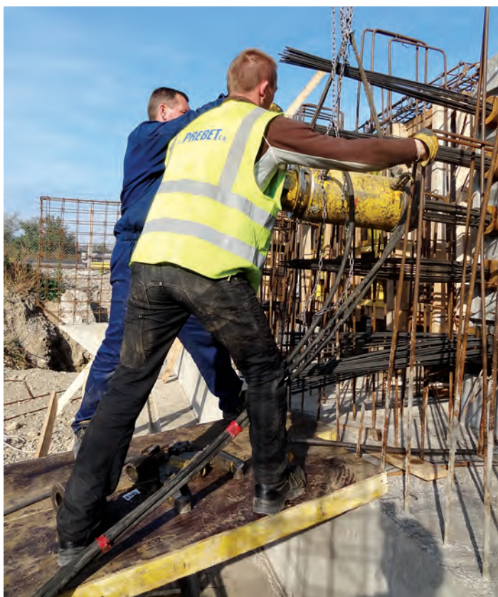
Armarea elevației culeelor la Podul Gârleni
