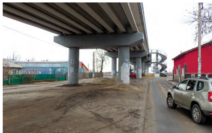
Vedere de jos, parțială, a viaductului Fundulea
