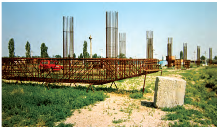
Faze de execuție – armarea unor stâlpi de pile
