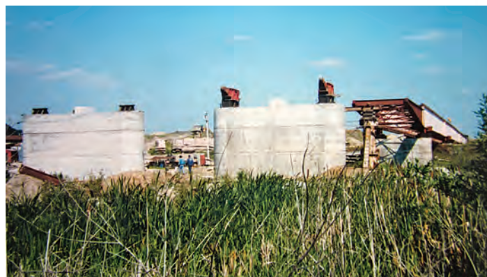
Lansarea grinzii metalice în deschidere – faza 1
