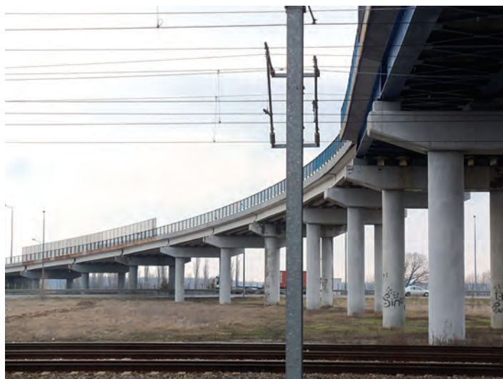
Vedere de jos a viaductului București
