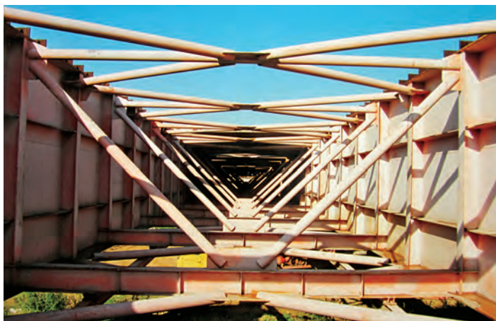
Vedere de detaliu a tablierului metalic
