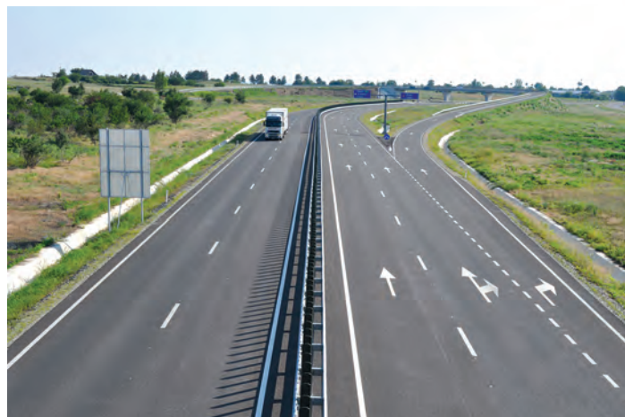
D.N. 56, km 81+150. Infrastructura de acces la Podul peste Dunăre, de la Calafat - Vidin
