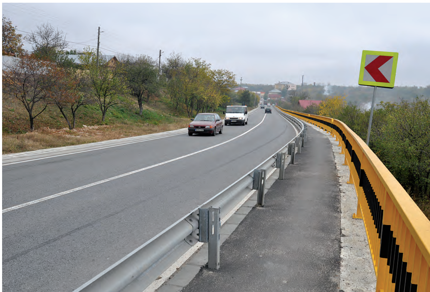
Lucrări de consolidare pe D.N. 6, la km 204+841
