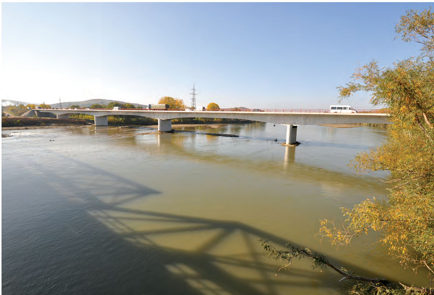
Pod peste râul Jiu, la km 3+100, pe D.N. 56, Craiova - Calafat
