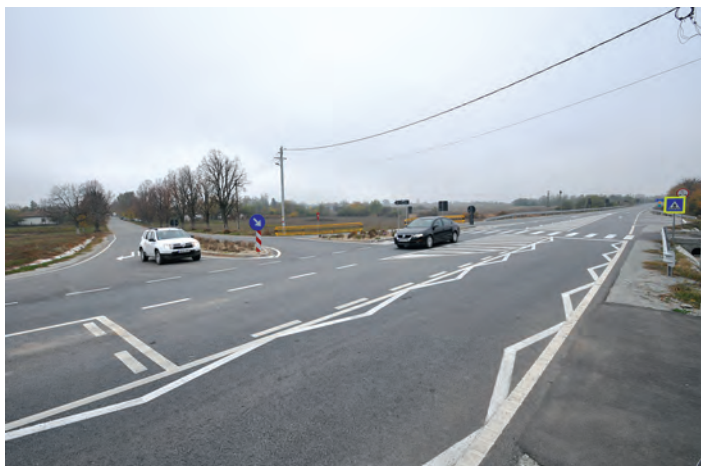
D.N. 6, Alexandria - Craiova. Intersecție cu D.C. 47, Dioști, km 186+980
