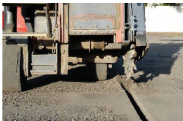
Fig. 5 - Roata laterală de frezare pentru șlițuri
