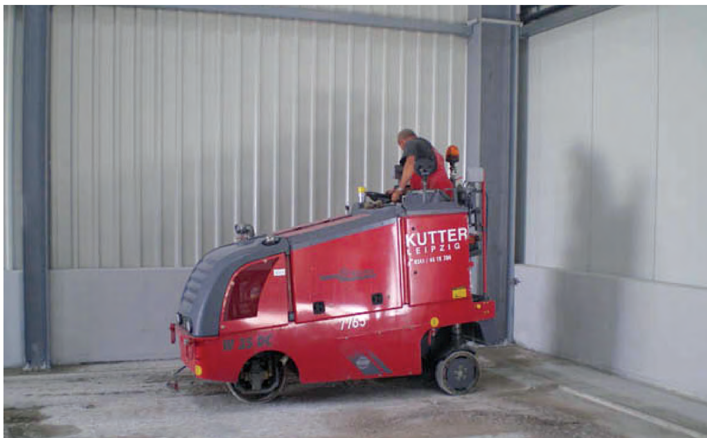
Fig. 4 - Până în ultimul colț: Învelișul din această hală a fost îndepărtat în doar o singură zi cu o microfreză
