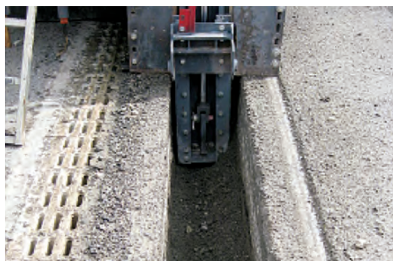
Fig. 3 - Profil frezat (lățime 35 cm, adâncime 55 cm) pentru pozarea de conducte, lângă un profil rigolă cu grătar metalic
