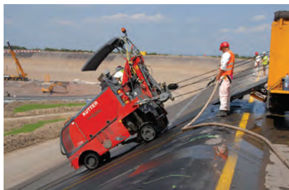
Fig. 2 - Nivelarea suprafețelor sau realizarea de profiluri sunt posibile și în pantă, la baraje
