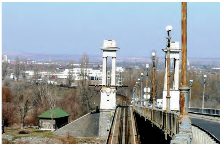
Fig. 143 - Elevația culeii C01 de pe malul românesc, văzută de pe carosabilul viaductului rutier (Foto. S. FLOREA, 2011)
