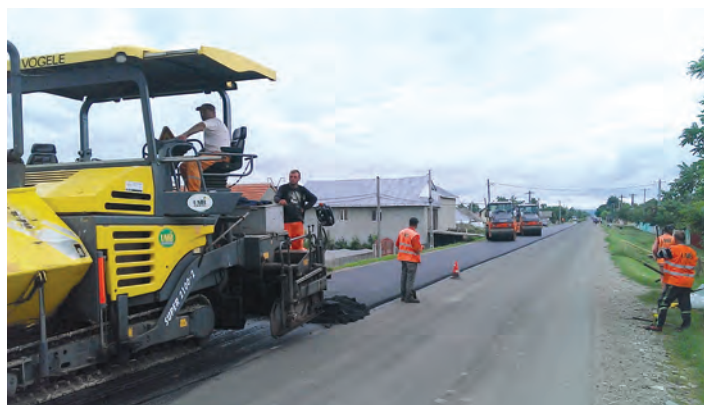
Turnare strat de uzură pe D.N. 24, Crasna - Iași, la Văleni
