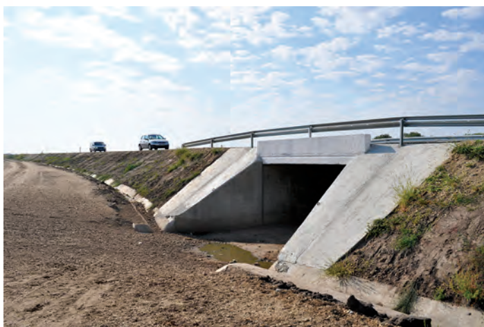
Podeț cu deschidere de 5,0 m, pentru subtraversare de către animale și utilaje
