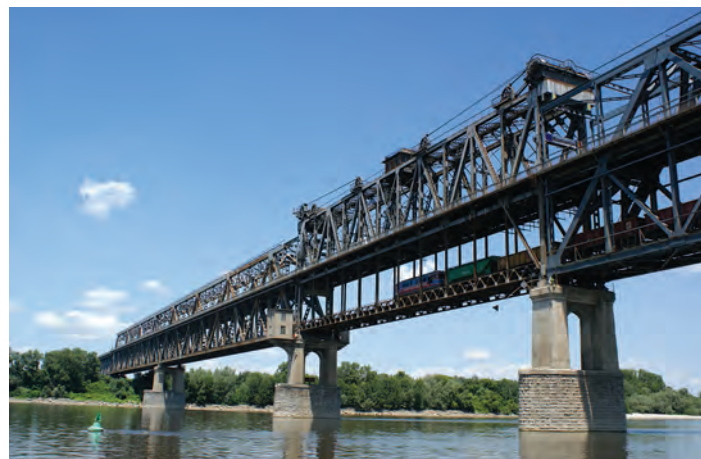
Fig. 144 - Elevația amonte a podului, deschiderile principale și deschiderea mobilă din ax, cu obiectivul orientat către malul românesc. Detalii ale elevațiilor la pilele P 17 , P 18 și P 19 (Foto, S. FLOREA, 2011)
