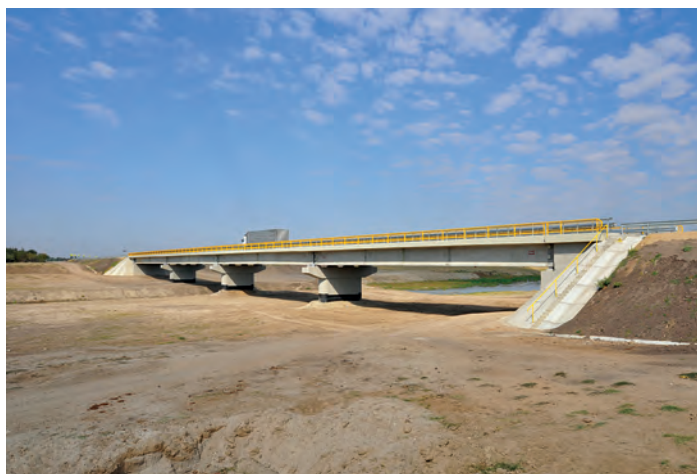
Pod peste râul Vedea, km 10+060
