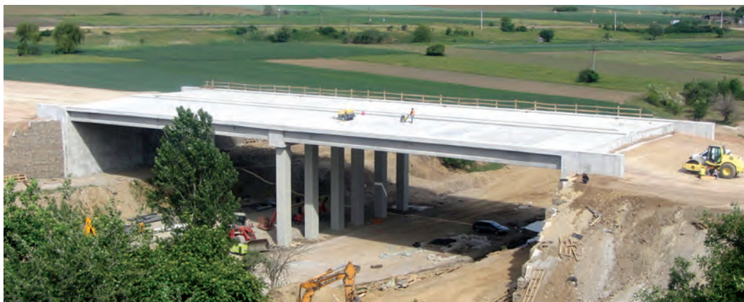
Figura 10 – Pod de autostradă - structură executată
