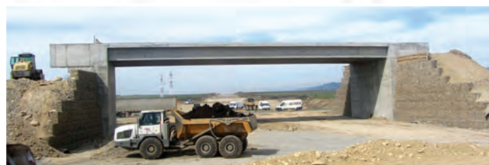
Figura 8 – Pasaj pe drum național și județean - structură executată
