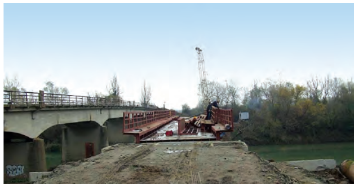
Foto 7 – Pod provizoriu – tabliere de inventar, montate
