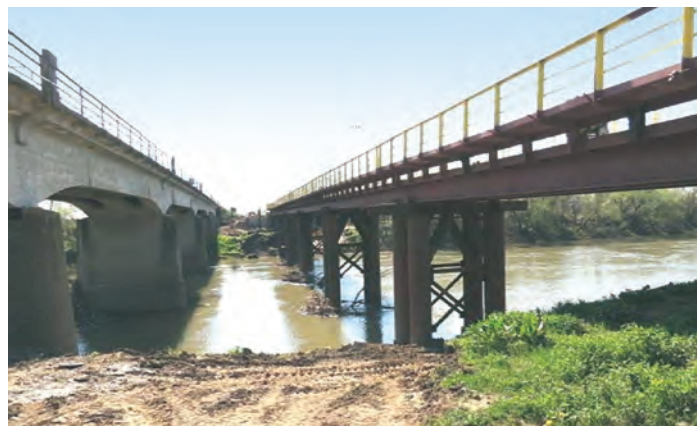
Foto 8 – Pod provizoriu – în așteptarea traficului
