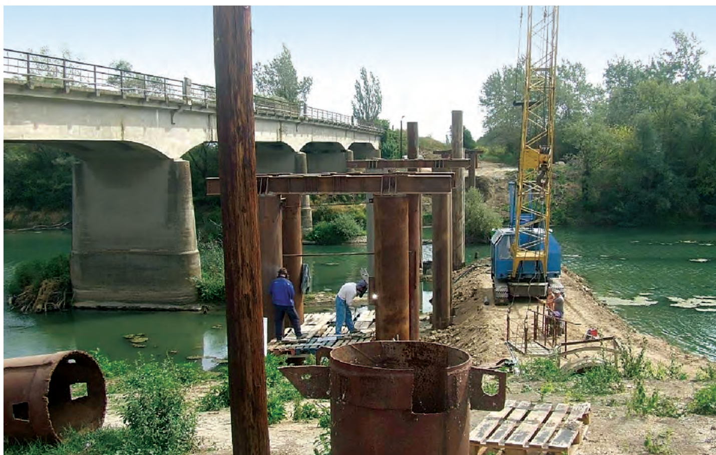
Foto 6 – Pod provizoriu – palei în execuție
