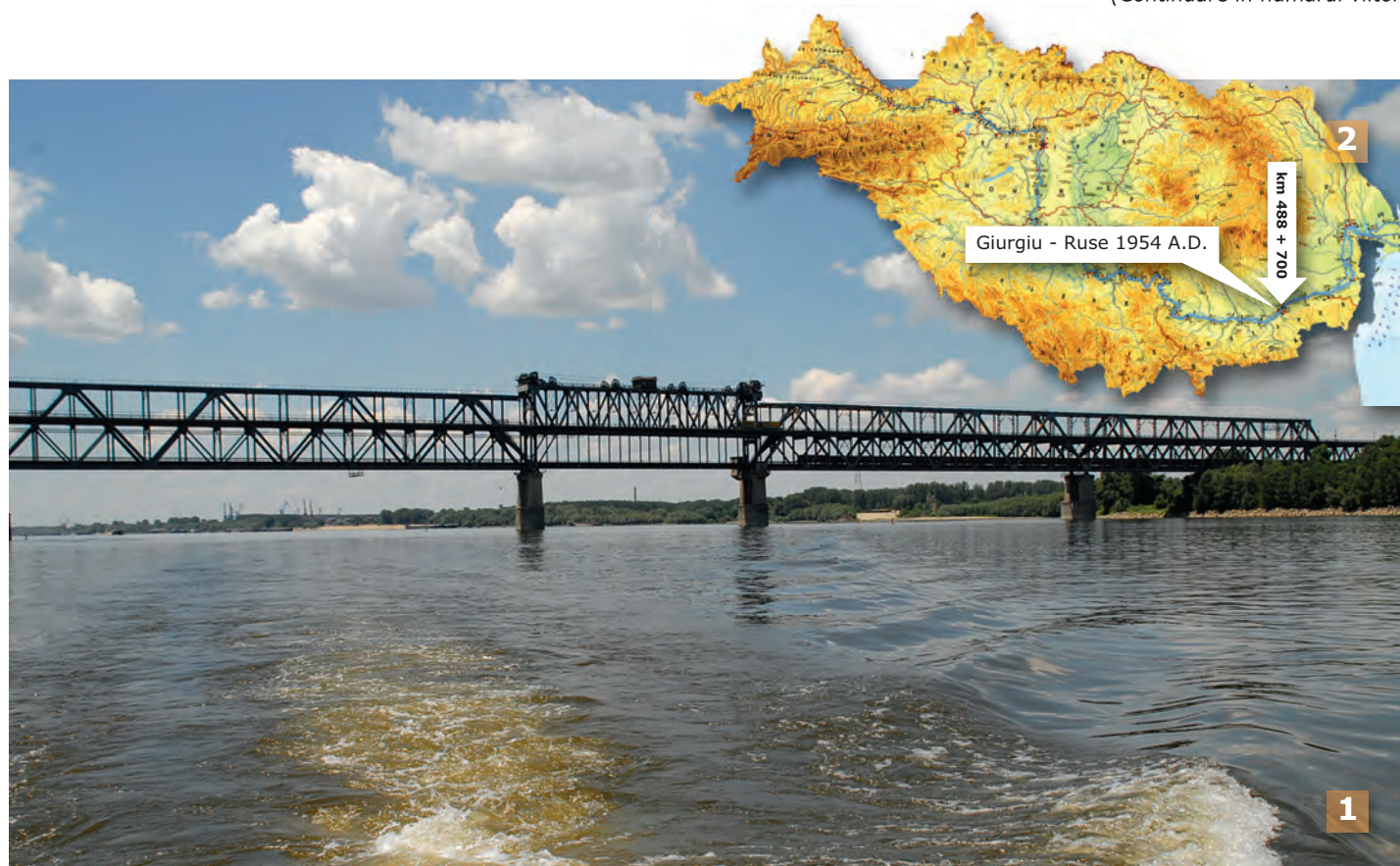
Fig. 139 - 1. Elevația amonte a Podului Giurgiu - Ruse. (Foto S. FLOREA, 2011); 2. Bazinul Dunării cu poziția kilometrică a șenalului navigabil al fluviului Dunărea, în dreptul Podului Giurgiu-Ruse
