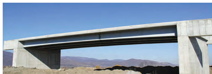
Figura 15 Pasajul pe DN 7 peste autostradă la km 8+755
