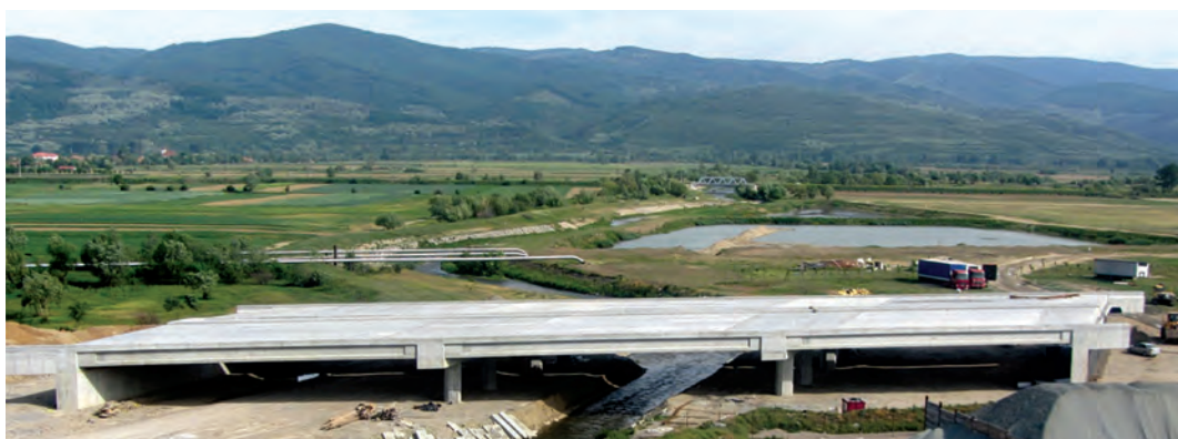
Figura 11 – Viaduct pe autostradă, km 9+405, peste râul Cugir (2013)
