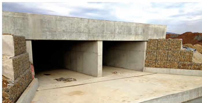
Figura 4 - Pod casetat executat
