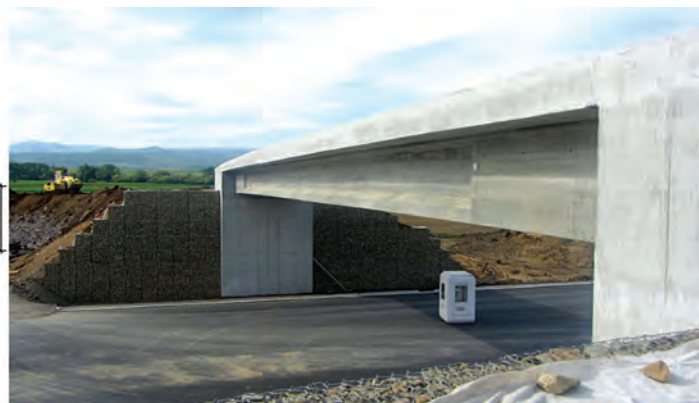
Figura 6 – Pasaj pe drum agricol - secțiune transversală prin și structură executată
