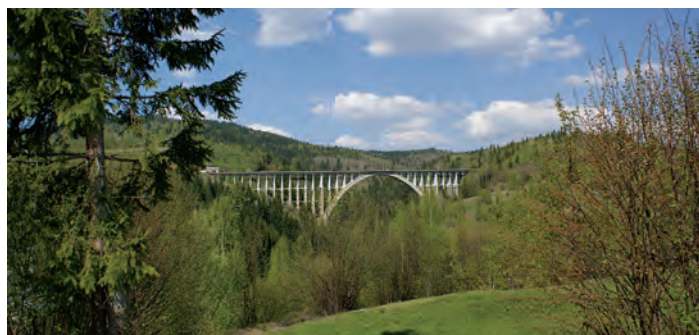
Fig. 133 - 1. Viaductul Caracău - detaliu, văzut de pe versantul nord-vestic al dealului Racș (Foto, S. FLOREA, 2012) 2. Cintrul și eșafodajul de lemn executate în anii 1945-1946
