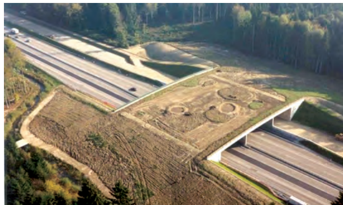
Fig. 3 Ecoduct în construcție, cu lățime 50 m, peste autostrada existentă și linia C.F., Neu-Ischlag, Cantonul Bern, Elveția.
