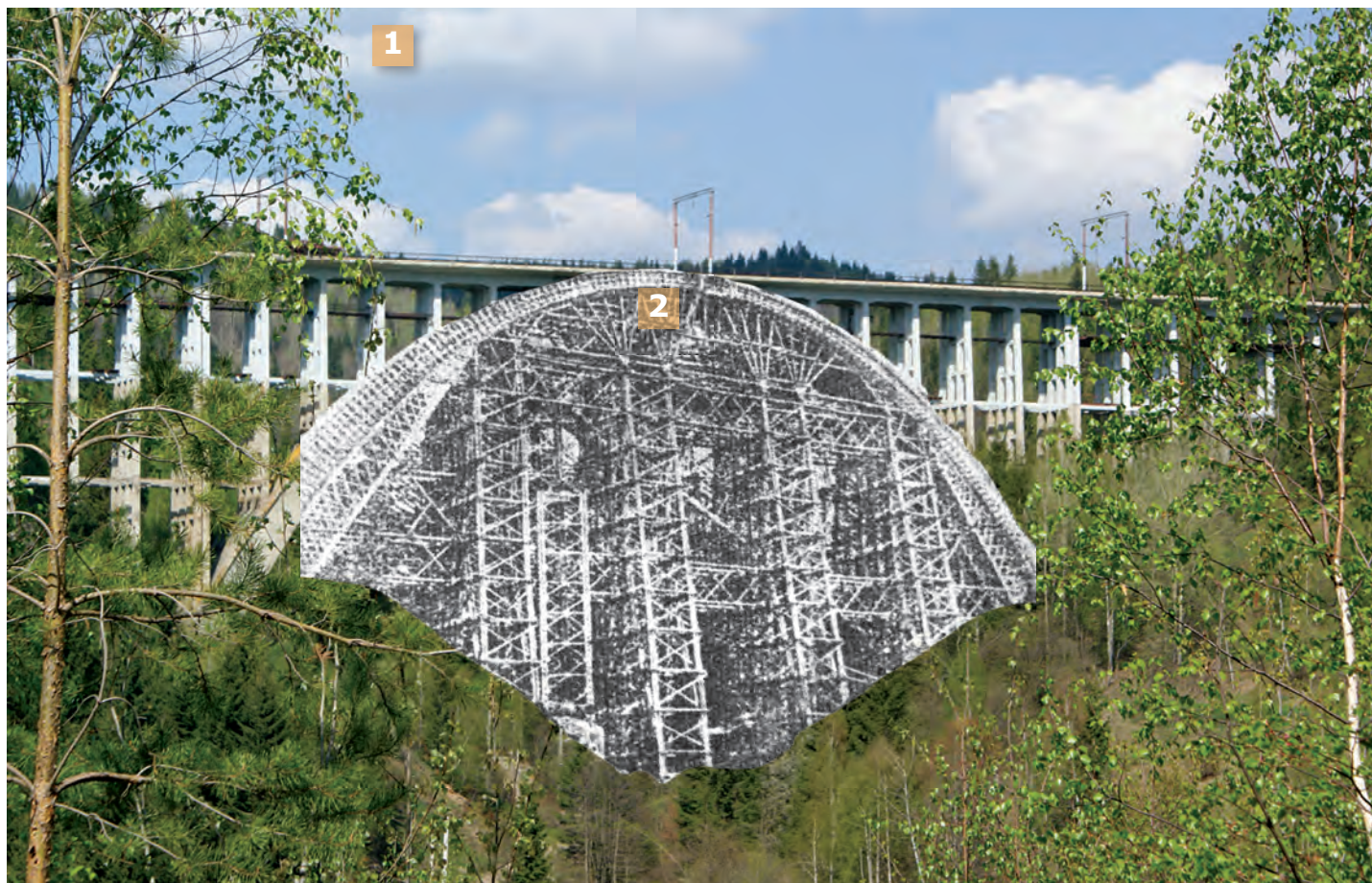
Fig. 132 - Grația căprioarei. Elevația aval a Viaductului Caracău, văzută de pe versantul nord-vestic al Dealului Racș (Foto, S. FLOREA, 2012)
