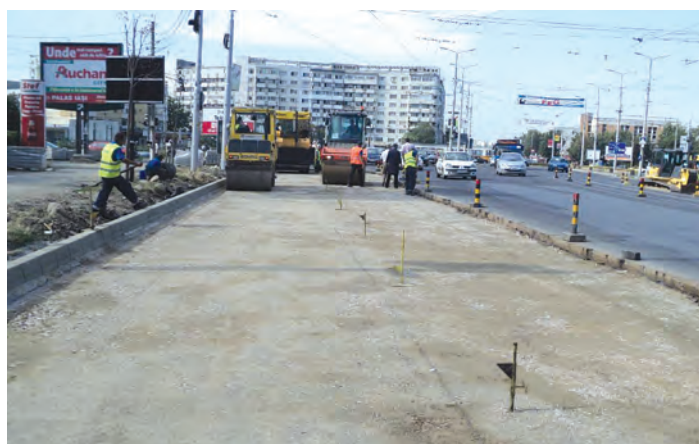
Lucrări în zona Podu Roș Iași
