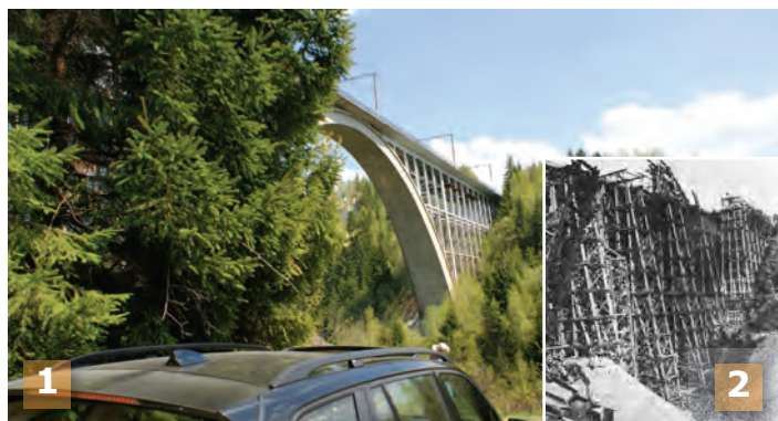
Fig. 128 - Paralele (2012-1945) - 1. Elevația aval a viaductului Caracău, văzută de pe versantul sud-estic al vârfului Livezi (Foto, S. FLOREA, 2012); 2. Imaginea cu paleele de lemn ale podului provizoriu în construcție, în anul 1945
