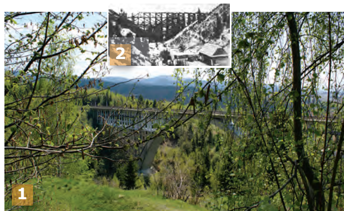
Fig. 127 - 1. Elevația amonte a viaductului Caracău, văzută de pe versantul sud-estic al vârfului Livezi (Foto, S. FLOREA, 2012); 2. Imaginea cu podul provizoriu în construcție în anul 1945
