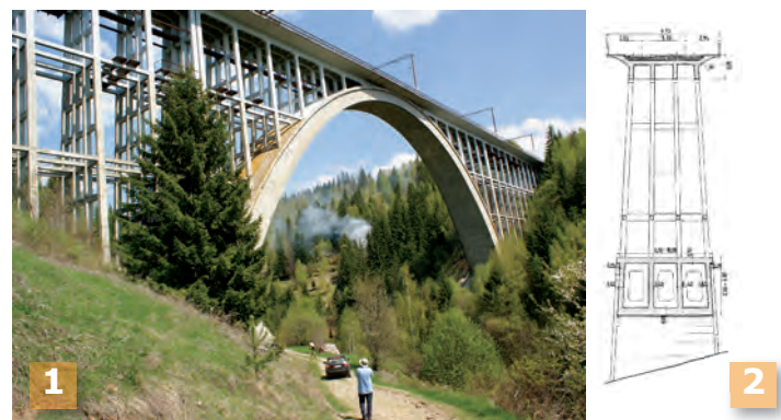
Fig. 130 - 1. Elevația aval a Viaductului Caracău. Un îndrăgostit pasionat pentru această lucrare, ing. Vlad PELIN, culege imagini din multiple unghiuri. (Foto, S. FLOREA, 2012); 2. Secțiune transversală (Desen, Nicu POPESCU)
