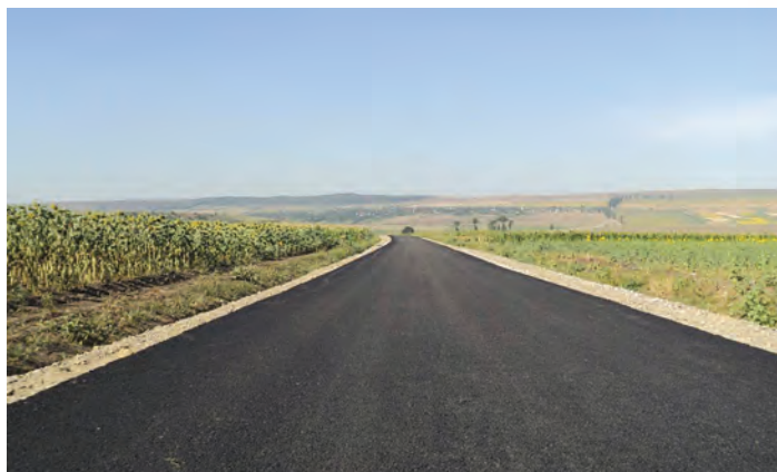
Lucrare de reparații la infrastructura rurală din comuna Drăgușeni
