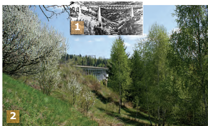
Fig. 123 - 1. Elevația aval a viaductului construit în 1897, dinamitat în 1916 de trupele în retragere ale Regatului Ungar; 2. Elevația aval a viaductului Caracău, văzută de pe versantul Sud-Estic al vârfului Livezi. (Foto, S. FLOREA, 2012)
