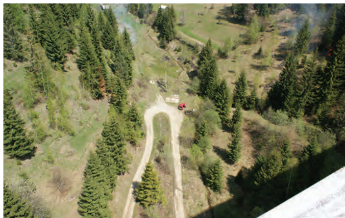
Fig. 120 - Valea Caracăului, amonte de viaduct, văzută de pe viaduct (Foto, S. FLOREA, 2012)
