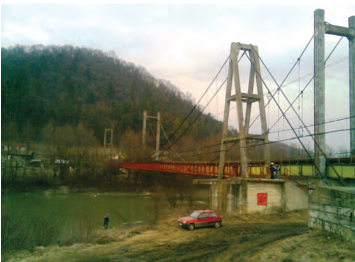
Pasarela pietonală peste râul Someșul Mare, la Beclean
