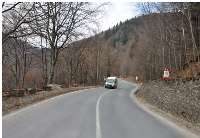
Zid de sprijin din piatră pe D.N. 10 (km 94+900)
