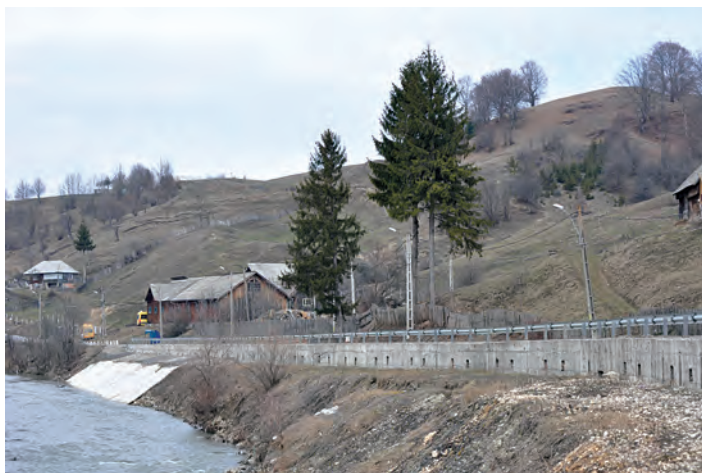
Consolidare mal pe D.N. 10, km 100+850
