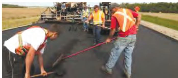
Lucrări de reabilitare a D.J. 121, în zona localității Covasna
