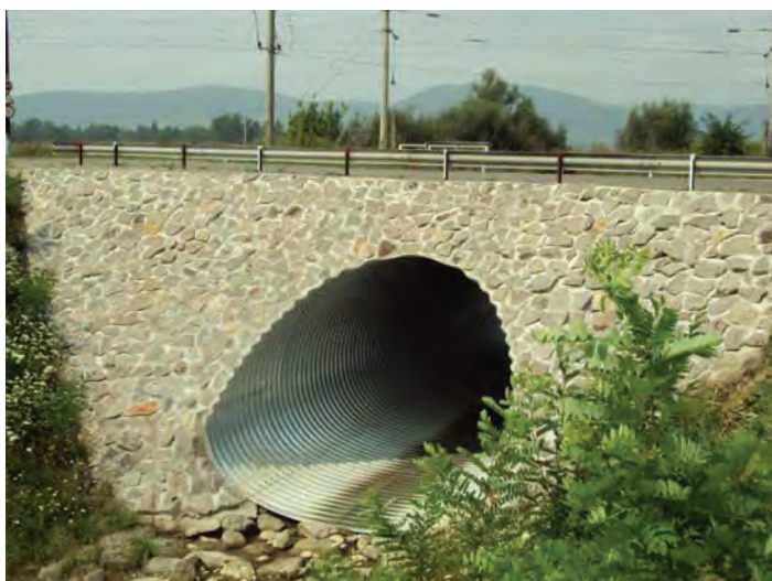
Tub din tablă ondulată la podețul de pe D.C. 29, la Bodoc
