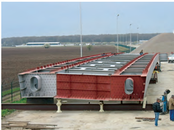
Fig. 14 Vedere generală tablier metalic preasamblat
