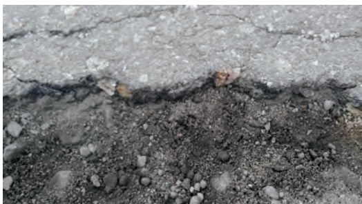
Fig. 8 – Aspectul stratului stabilizat sub îmbrăcămintea asfaltică
