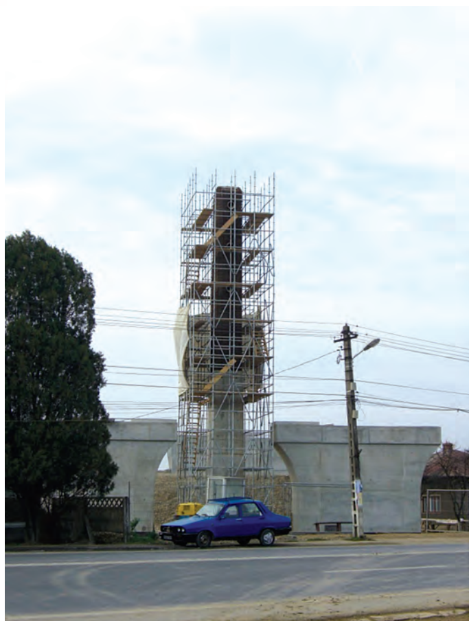
Fig. 8 Schelă pentru armarea și betonarea corpului superior al stâlpului de pilon
