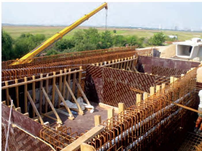
Fig. 11 Detaliu cofraje și armare grinzi principale și antretoaze tablier din beton precomprimat
