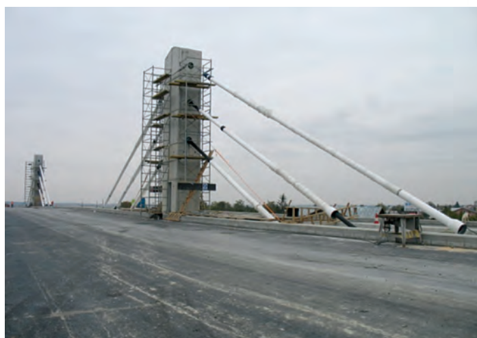
Fig. 19 Montarea hobanelor. Vedere laterală
