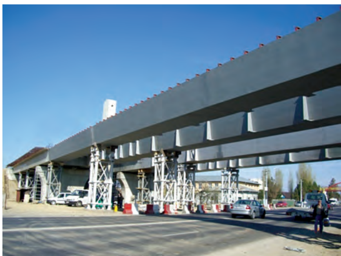
Fig. 15 Vedere laterală grinzi principale tablier metalic după montarea în amplasament
