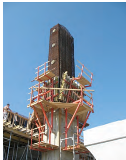
Fig. 9 Armare și cofrare corp superior stâlp de pilon
