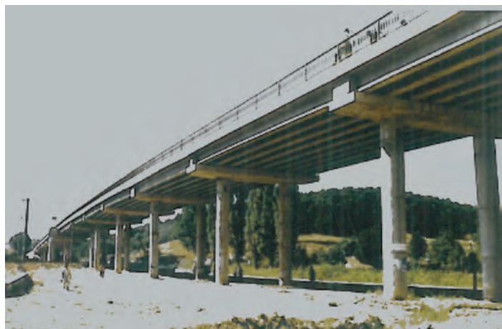
Fig. 3 Aspectul unei lucrări cu suprastructură din grinzi prefabricate precomprimate continuizate în soluția de structuri cadru. Vedere laterală
