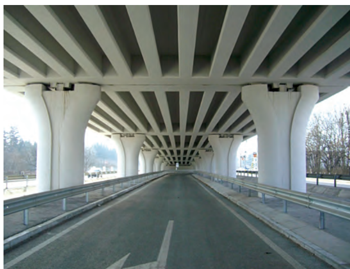
Fig. 2 Aspectul unei lucrări cu suprastructură din grinzi prefabricate precomprimate continuizate în soluția de structuri continue a) Vedere laterală b) Vedere intrados
