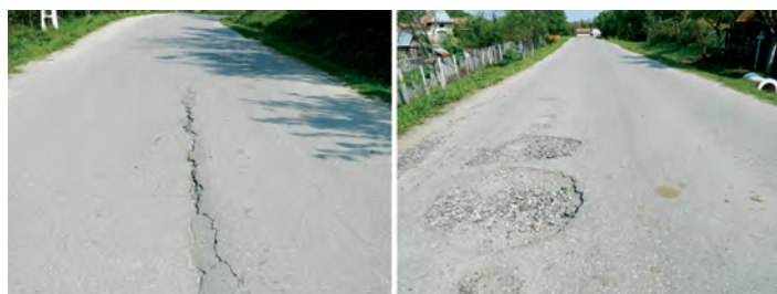
Fisuri longitudinale
