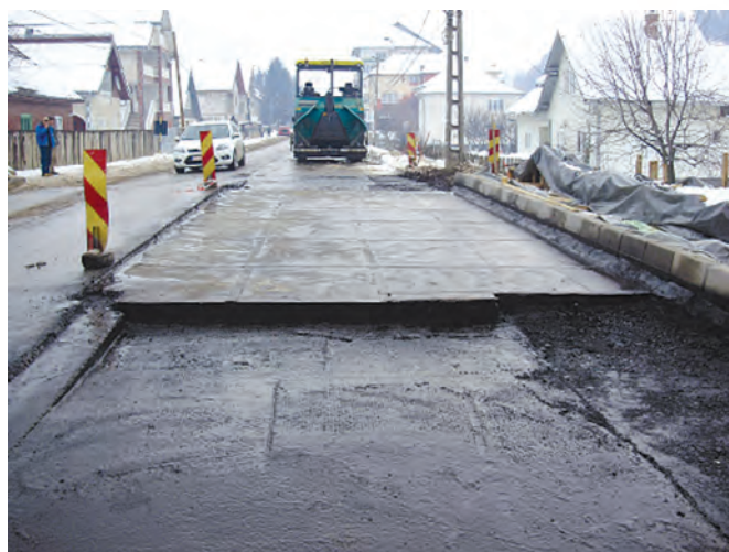
Lucrări executate la podul situat la km 142+700
