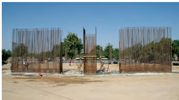
Fig. 4 Mustăți de armătură pentru elevații pilon și pile adiacente
