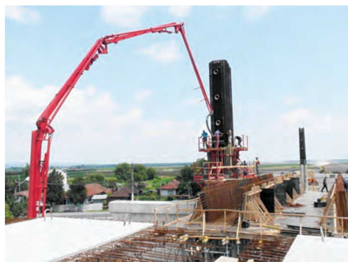
Fig. 10 Betonare corp superior stâlp de pilon
