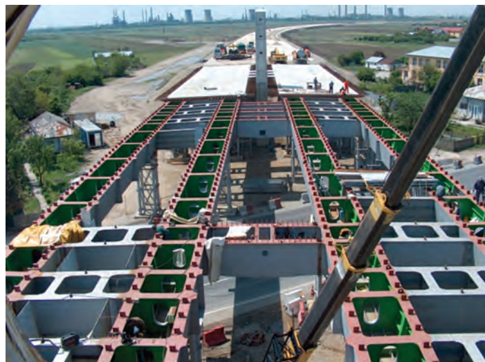
Fig. 16 Vedere tablier metalic după montarea antretoazelor
