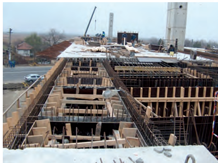
Fig. 13 Grinzi și antretoaze tablier din beton precomprimat pregătite pentru betonare
