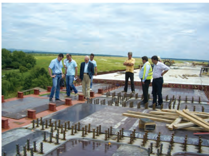
Fig. 18 Verificare și recepție conectori
