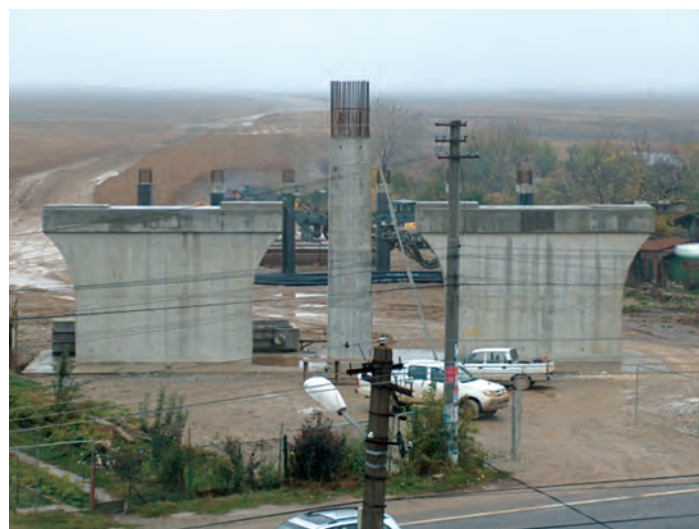
Fig. 6 Elevație corp inferior pilon și pile adiacente betonate și decofrare
