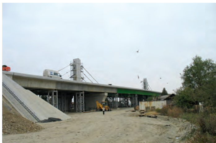
Fig. 20 Vedere pasaj după montarea hobanelor
