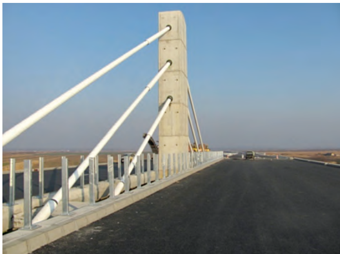
Fig. 21 Îmbrăcămintă asfaltică pe calea pasajului
