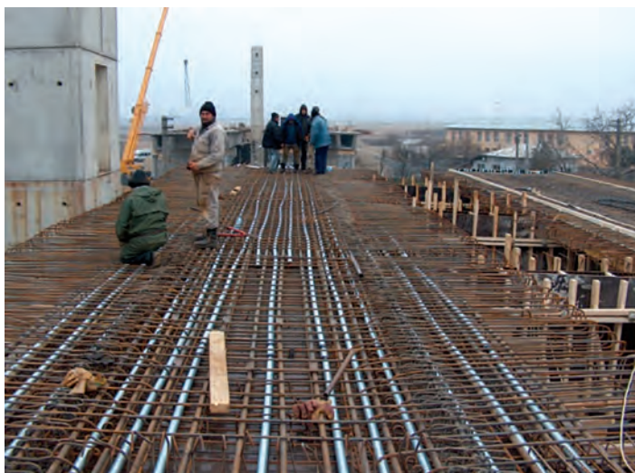
Fig. 12 Armare platelaj la tablierule din beton precomprimat
