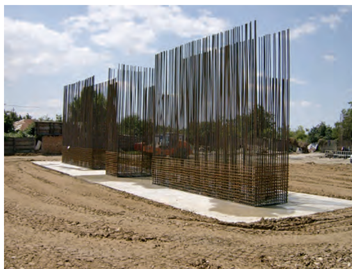
Fig. 2 Radier betonat fundație pilon și pile fundația comună a pilonului și a pilelor adiacente și mustăți de armatură pentru elevații
