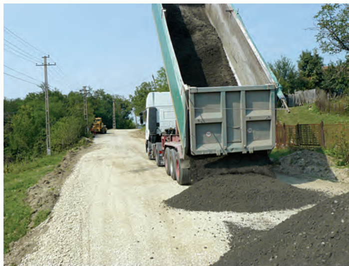
Fig. 3 – Răspândirea amestecului de agregate stabilizate cu cenușă
