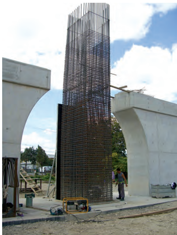
Fig. 5 Armare și cofrare stâlp pilon și pile adiacente betonate și decofrare
