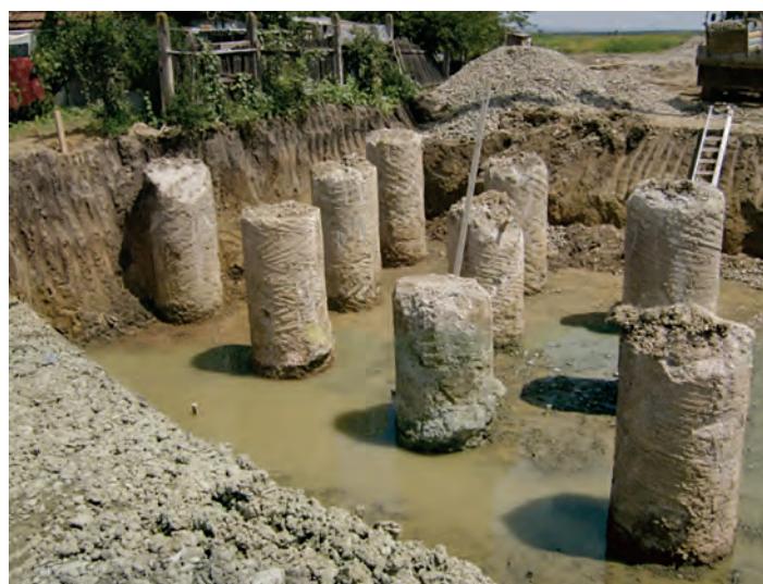
Fig. 1 Piloți foraji cu diametrul de 1,50 m în fundația comună a pilonului și a pilelor adiacente
