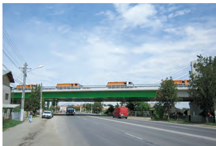
Fig. 23 Vedere laterală convoi de încercare
