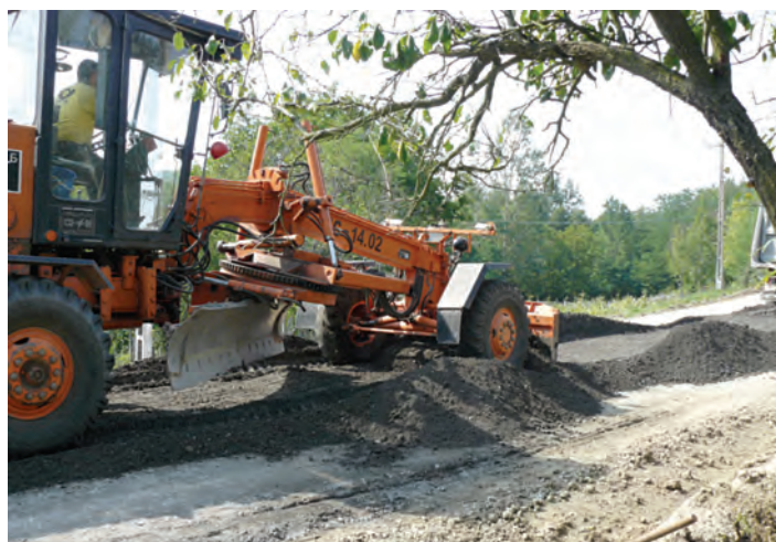
Fig. 4 – Așternerea stratului din agregate stabilizate cu cenușă
