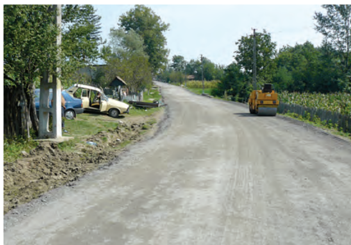
Fig. 5 – Compactarea stratului din agregate stabilizate cu cenușă
