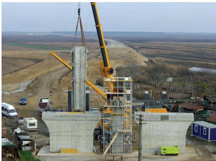
Fig. 7 Montare carcasă metalică pe corpul inferior al stâlpului de pilon
