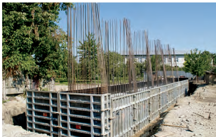
Fig. 3 Cofraj radier fundație culee și mustăți de armătură pentru stâlpii elevației
