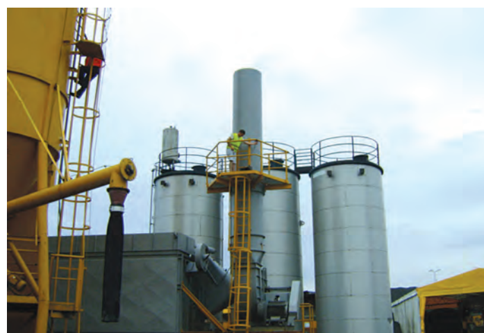
Prelevare probă de aer – emisii, de la stație de asfalt
