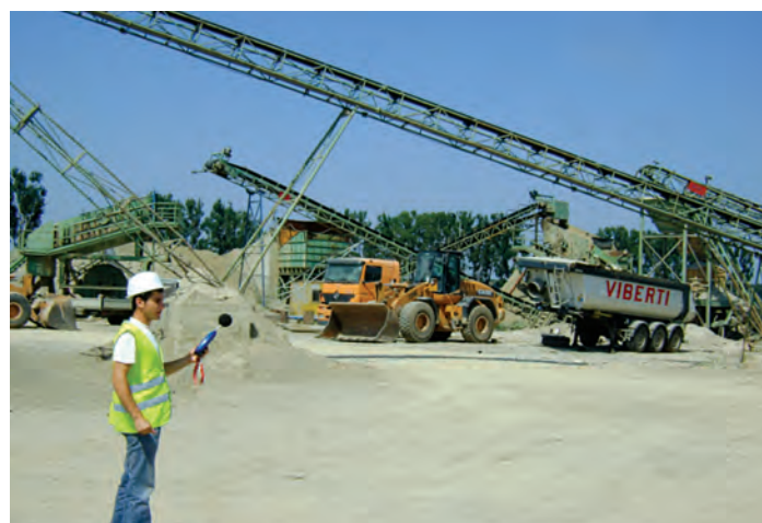
Măsurarea nivelului de zgomot, stație de concasare-sortare
