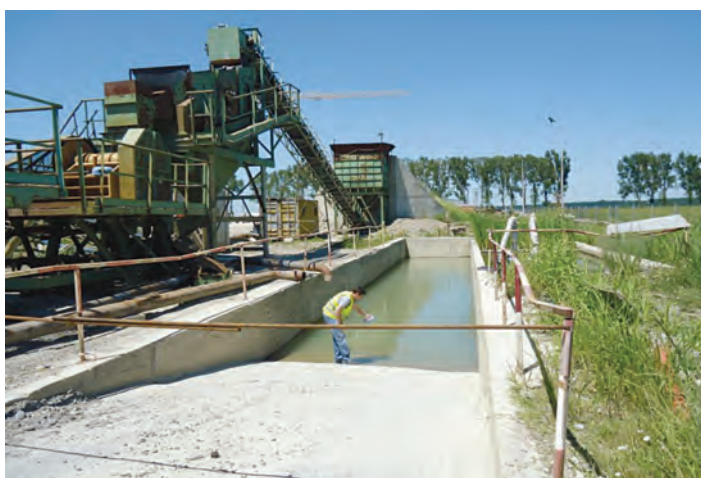
Prelevare probă de apă uzată din decantor, stație de concasare-sortare
