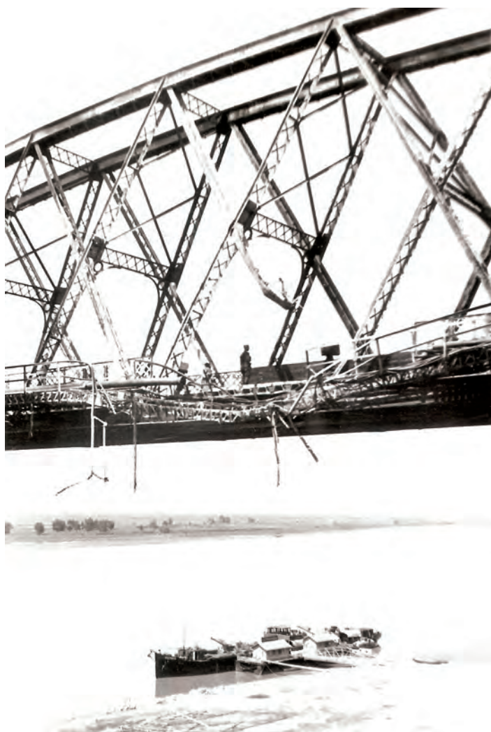
Fig. 117 - Distrugerii provocate la Podul Dunărea, în 10 august 1941
