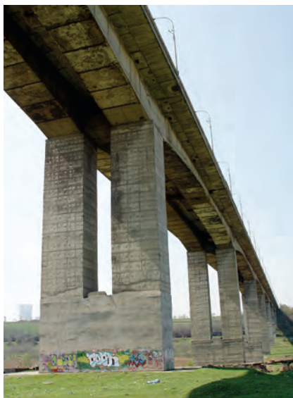
Municipiul Galați, Viaductul peste balta Cătușa
