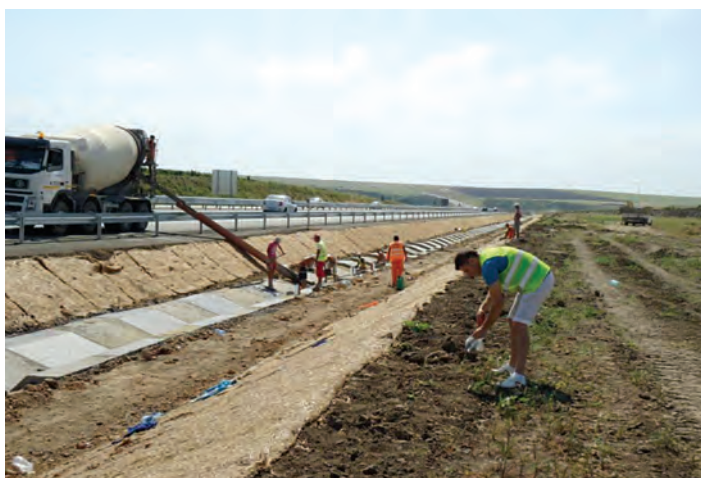
Prelevare probă de sol
