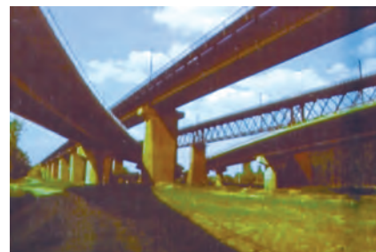
A2 Fetești - Cernavodă, km 15 + 714. Viaductele de acces la podul mixt peste Dunăre, la Cernavodă
