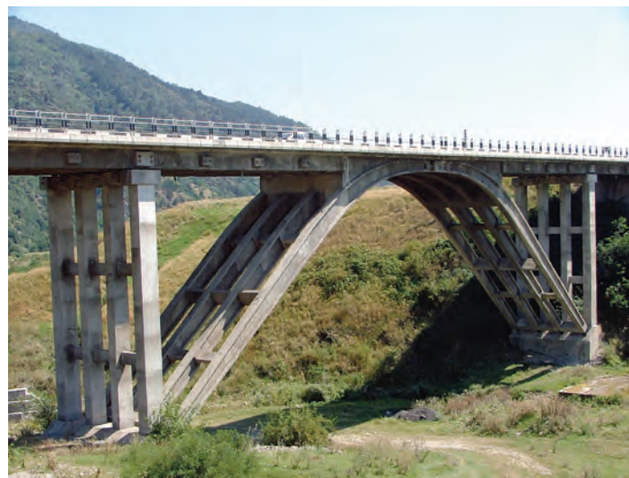
D.N. 66 Petroșani - Deva, km 172+330. Viaductul Ohaba de sub Piatră
