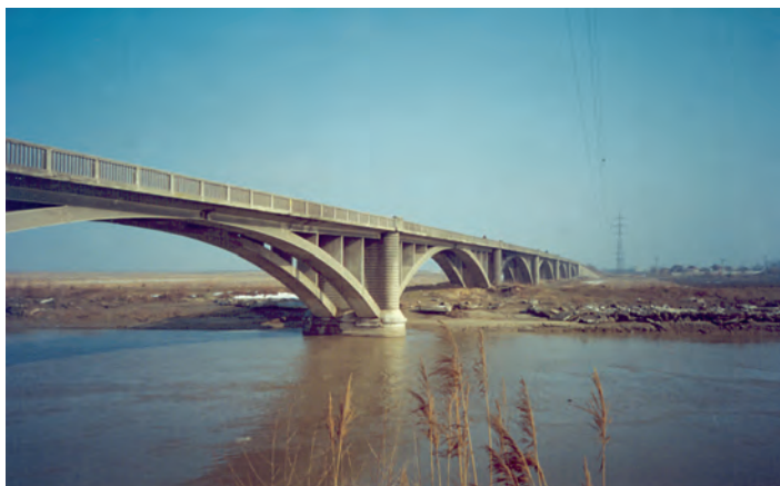
D.N. 2F Bacău - Vaslui, km 3+412. Pod peste Siret, la Holt
