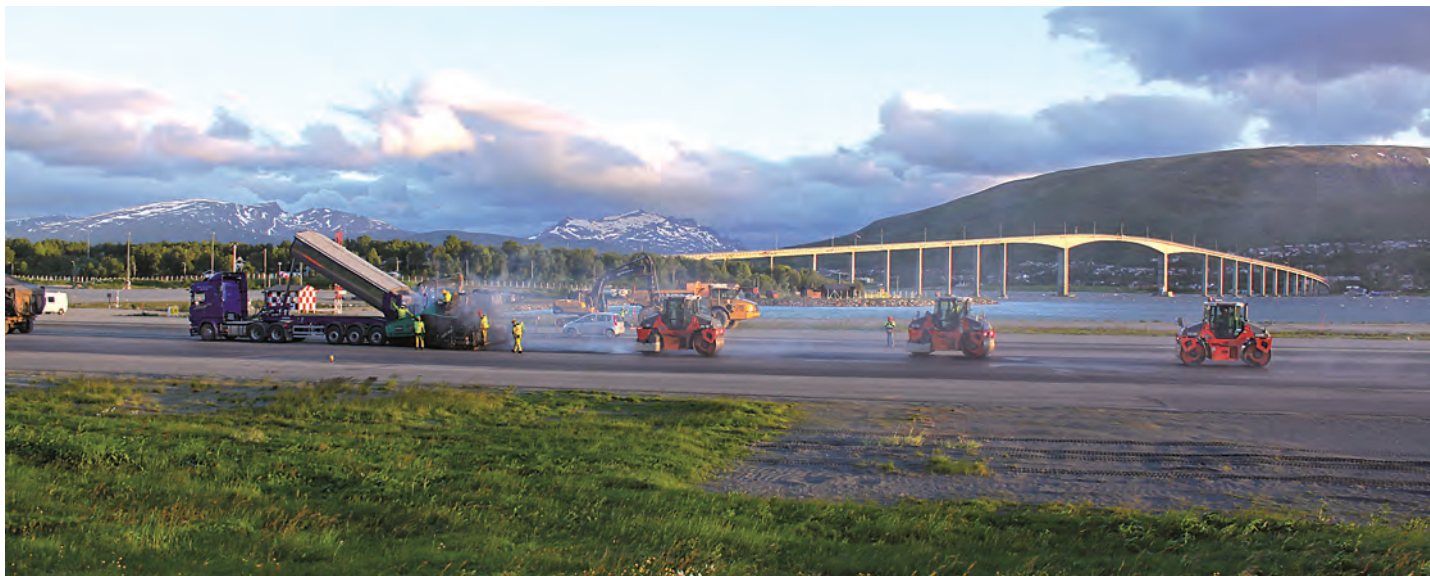
Este ora 01:30 noaptea, iar soarele este deja deasupra liniei orizontului. Pe fundal se observă podul peste Sandnessund. Asfaltul de pe acest pod a fost la rândul său compactat cu mulți ani în urmă cu ajutorul cilindrilor compactori cu oscilație.
