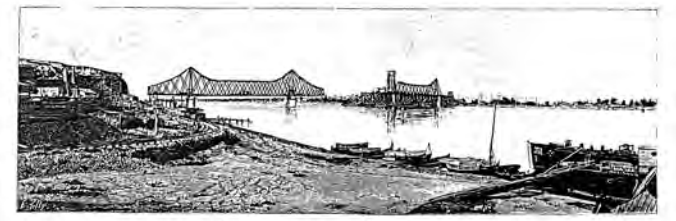
Le pont de Cernavoda pendant les travaux.
