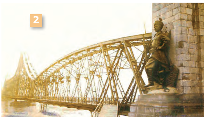
Fig. 108 - 1. Profilul în lung al căii ferate pe lățimea albiei majore a fluviului Dunărea; 2. Elevația amonte a deschiderii independente de la Podul Dunărea, cu dorobanțul de la Portalul culeii Cernavodă (Desen N. POPESCU)
