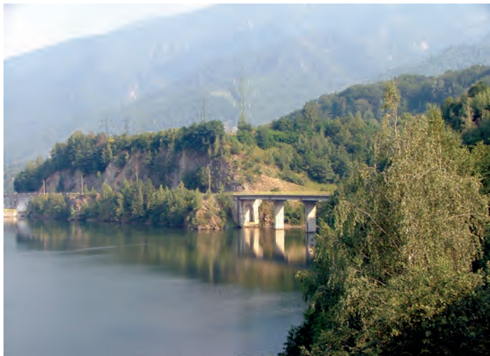
D.N. 7A Brezoi - Voineasa, km 25+417, Viaductul Bucureasa
