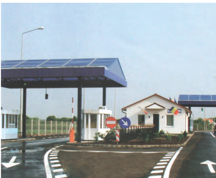
Punct de trecere a Frontierei - Vama Urziceni Durata execuției: 31 de zile
