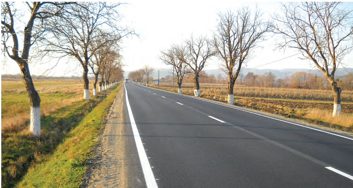
Covor asfaltic pe D.N. 1, între poz. km 576+500 – km 586+400
