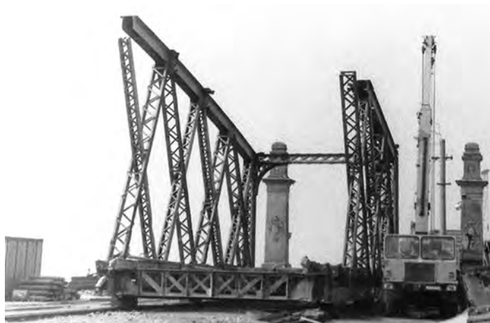
Fig. 099 - Dezmembrarea vechilor tabliere din oțel pudlat din deschiderile 1 și 5 (Foto Ion IONESCU)
