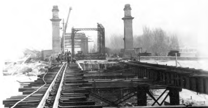
Fig. 098 - Eșafodajul și calea de lansare din deschiderea 1. Fotografie din colecția ing. Ion IONESCU
