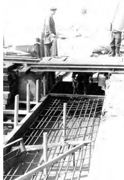
Fig. 101 - Armarea zonei de supraînălțare a culeei C05, culeea Slatina. Maistrul Ion C. STAN supraveghează operația de betonare. (Foto Ion IONESCU)
