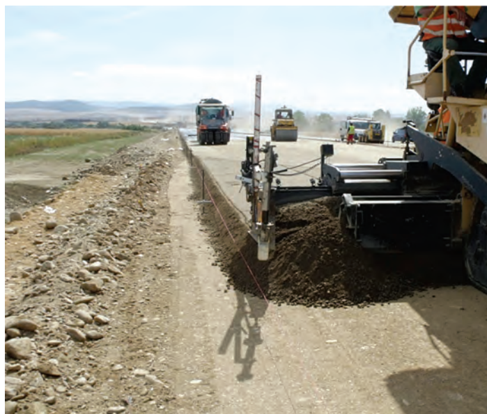
Foto A - Punerea în aplicare cu ajutorul finisorului
