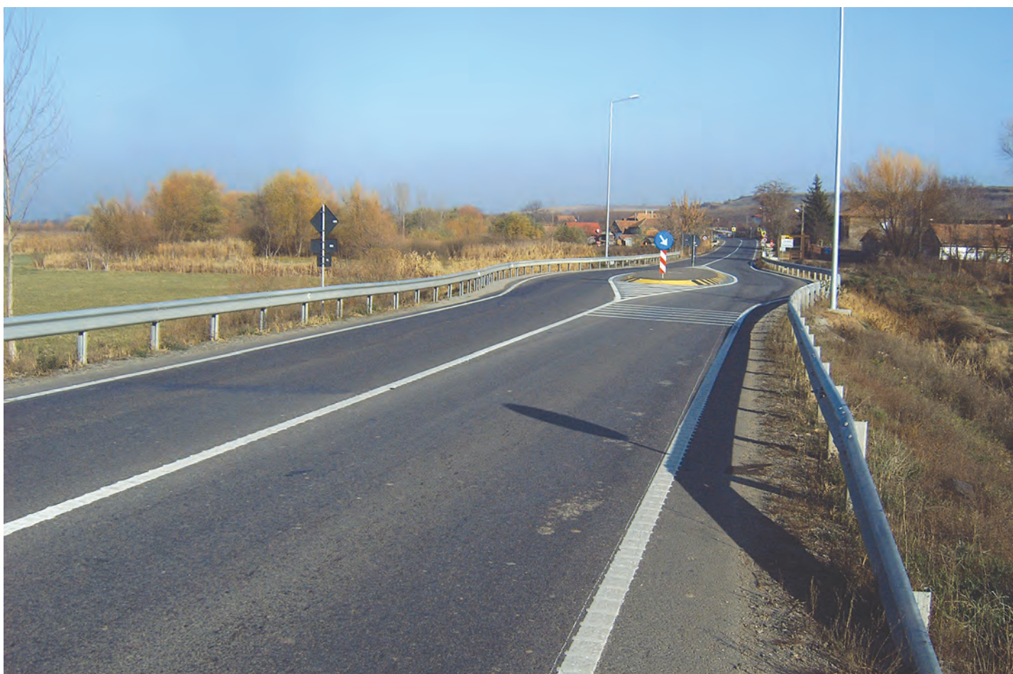
Reabilitare pe D.N.19, între poz. km 5+853 - km 76+000
