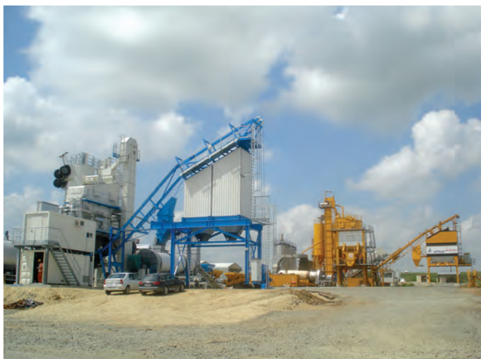
Foto 2. A2 Cernavodă - Constanța: stații de mixturi asfaltice de tip TBA200 și MBA2500, pe șantierul de la Murfatlar
