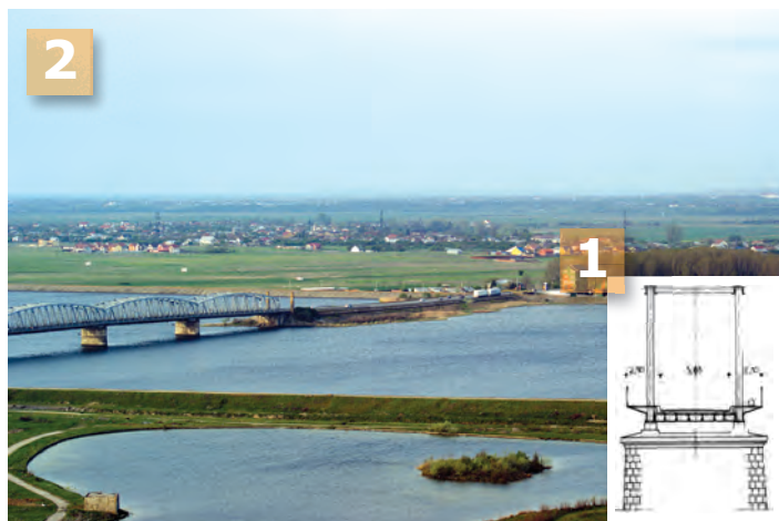
Fig. 086 - 1. Secțiunea transversală a podului inaugurat în 1891
