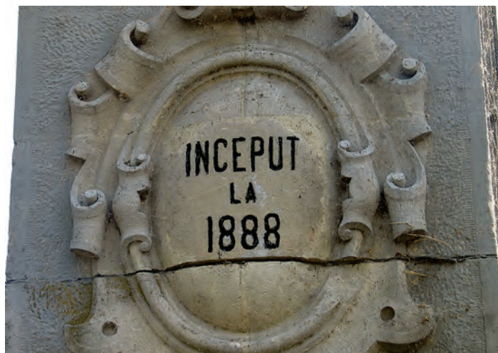
Fig. 083 - Portalul de ieșire, pilastrul din amonte, medalionul ornamental cu inscripționarea anului de începere a lucrărilor 1888
