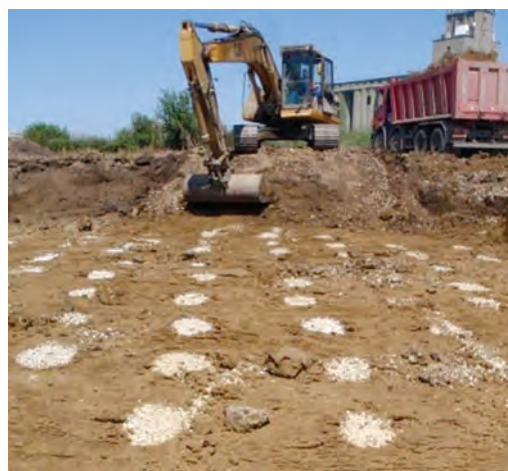
Figura 4 - Îmbunătățirea terenului cu coloane de balast - Lehliu Gară.
