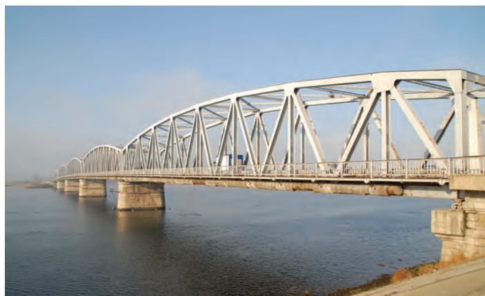
Fig. 089 - Podul văzut de pe malul stâng din aval (Foto E. JIPA, 2010)
