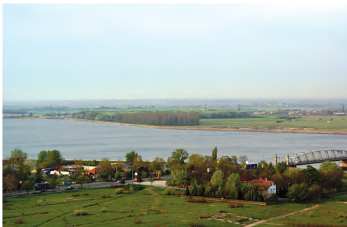
Fig. 093 - Detaliu cu elevația tablierului din deschiderea 5, văzută din amonte, de pe dealul Grădiștei, malul stâng al râului Olt. (Foto S. FLOREA, 2011)
