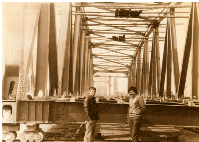
Fig. 096 - Ripare la poziție a unei grinzi principale din deschiderile centrale (Fotografie din colecția ing. Ion IONESCU)
