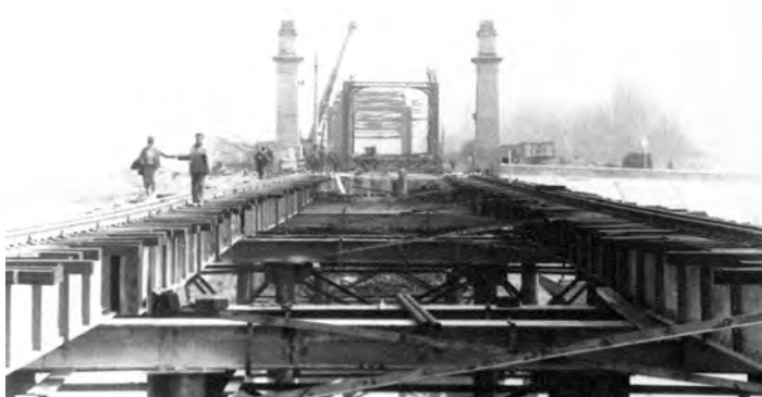
Fig. 094 - Eșafodajul din deschiderea 5 (Fotografie din colecția ing. Ion IONESCU)
