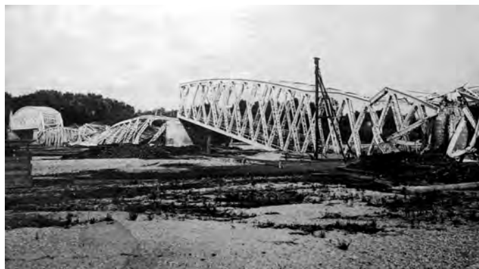
Fig. 087 - Tablierele din deschiderile 2, 3, 4 dinamitate de trupele române în 1916 Tablierele din deschiderile 1 și 5 au rămas pe poziție nefiind dinamitate.
