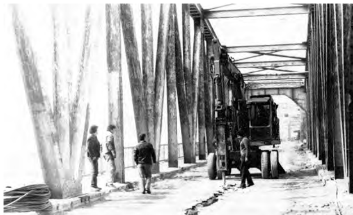
Fig. 095 - Demolarea straturilor căii și a plăcii de beton armat existente (Fotografie din colecția ing. Ion Ionescu)
