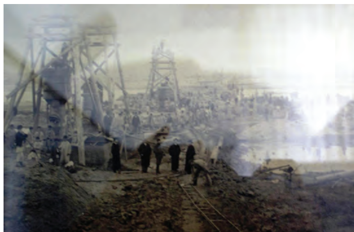
Fig. 077 - Imagine din timpul execuției podului de lemn, Colecția Muzeului de Istorie a județului Olt
