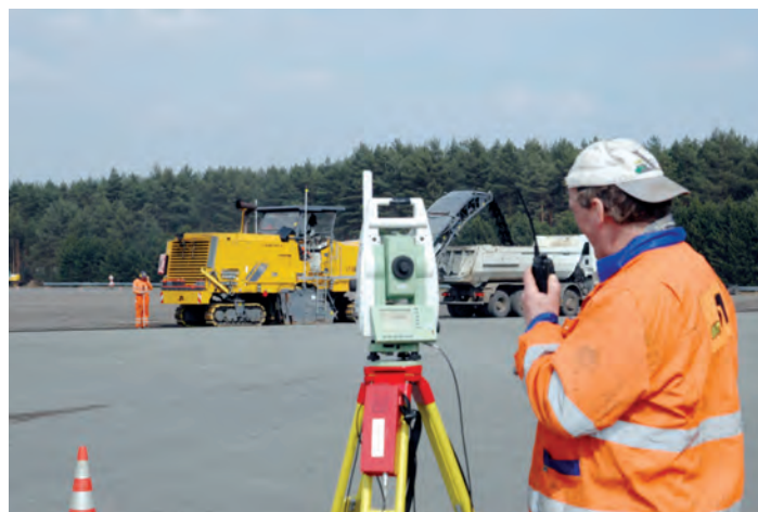
Fig. 4 Control de succes al calității: măsurătorile efectuate cu o stație totală suplimentară și cu o prismă situată în spatele mașinii pe suprafața frezată au indicat că sistemul oferă precizia cerută. Măsurătorile de control ale beneficiarului au confirmat de asemenea poziția corectă a suprafeței frezate, cu valori situate în limitele de toleranță.
