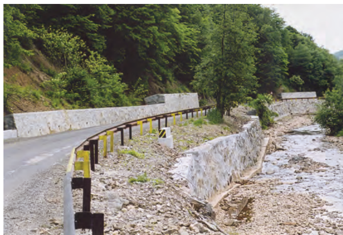
Lucrări complexe, de ridicat nivel tehnic, care au dat o viață nouă drumurilor județene
