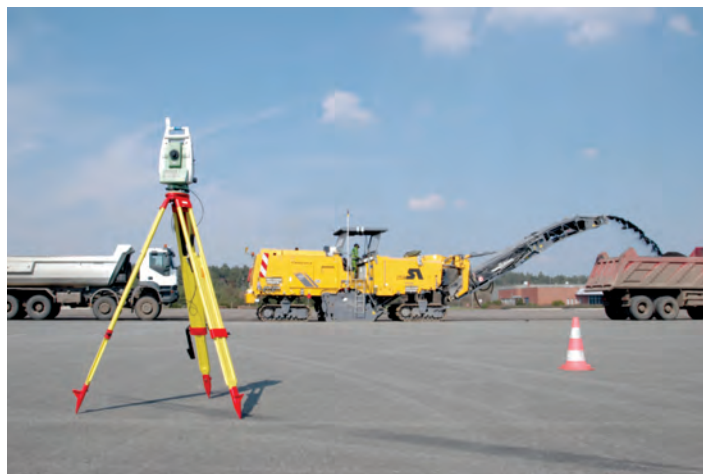
Fig. 3: Îndepărtarea cu mare precizie a asfaltului de pe o suprafață dinamică destinată testării autovehiculelor, cu ajutorul frezelor cu comandă cu laser 3D. O stație totală „urmărește” prisma receptoare a frezei la rece și transmite valorile măsurate sistemului de comandă al mașinii.
