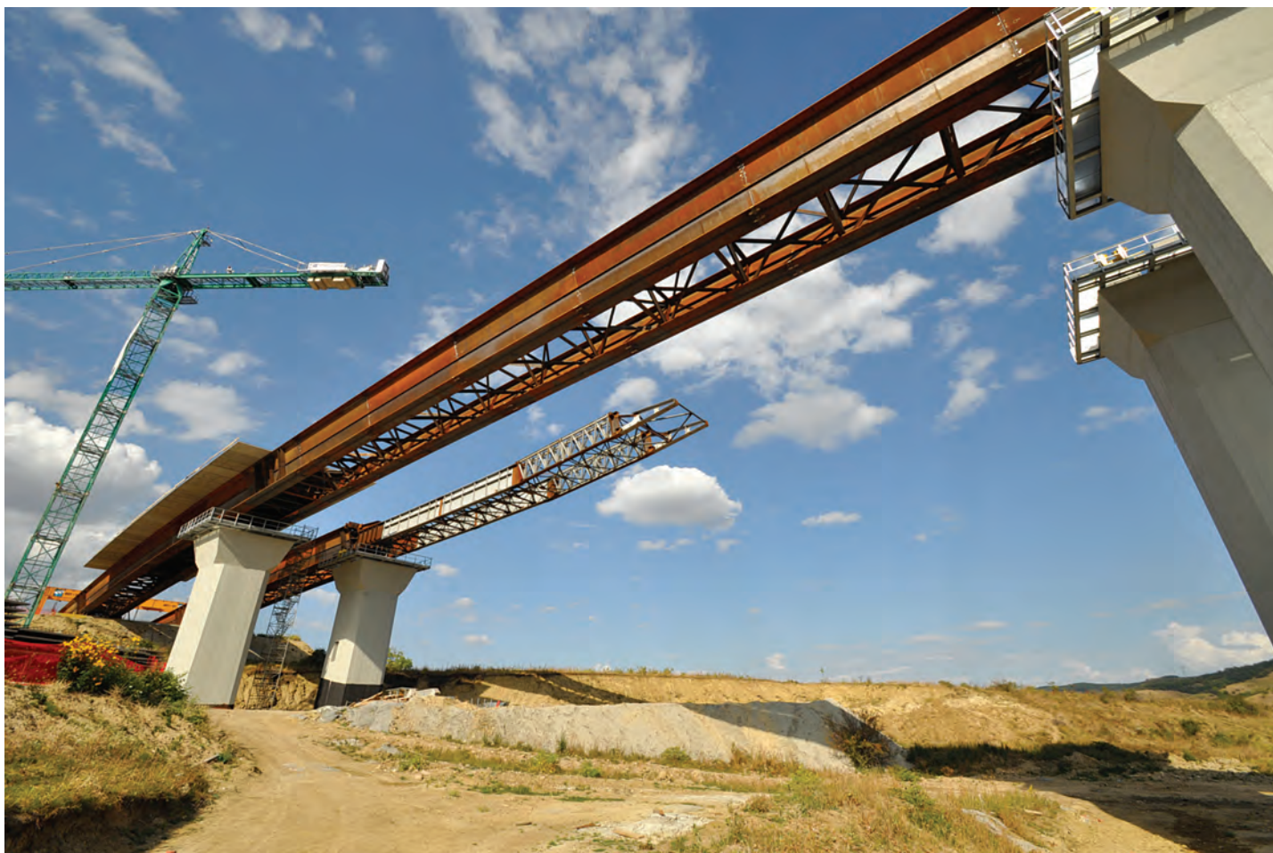
O sanie (avanbec) cu lungimea de 52 m și cu o greutate de 100 de tone lansează tronsoanele grinzii
