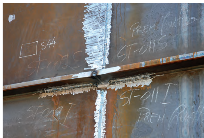
Sudorii Firmei VILBUC PROD S.R.L. - Târgu Jiu unesc tronsoanele cu înălțimea de 3,150 m și lungimi cuprinse între 8.820 mm și 13.055 mm și finalizează grinda Viaductului lung de 1.010 m. Utilizează aparate MIG-MAG și tractoare liniare și pendulare
