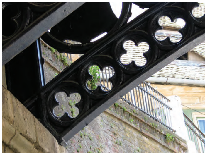
Fig. 071 - Detaliu de rezemare a grinzilor de fontă (Foto S. FLOREA, 2007)
