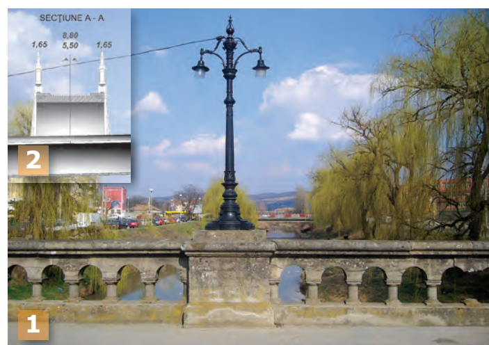
Fig. 060 - 1. Podul de piatră peste râul Cibin, parapetul din amonte
