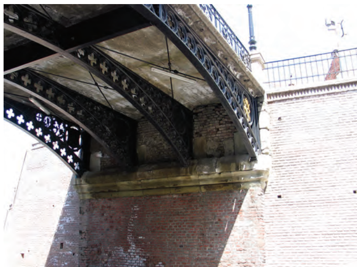
Fig. 068 - Podul Minciunilor văzut de pe strada Ocnei, structura de rezistență (Foto S. FLOREA, 2007)
