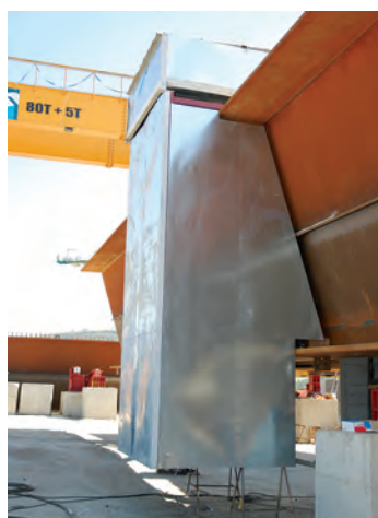
Sudorii Firmei VILBUC PROD S.R.L. - Târgu Jiu unesc tronsoanele cu înălțimea de 3,150 m și lungimi cuprinse între 8.820 mm și 13.055 mm și finalizează grinda Viaductului lung de 1.010 m. Utilizează aparate MIG-MAG și tractoare liniare și pendulare
