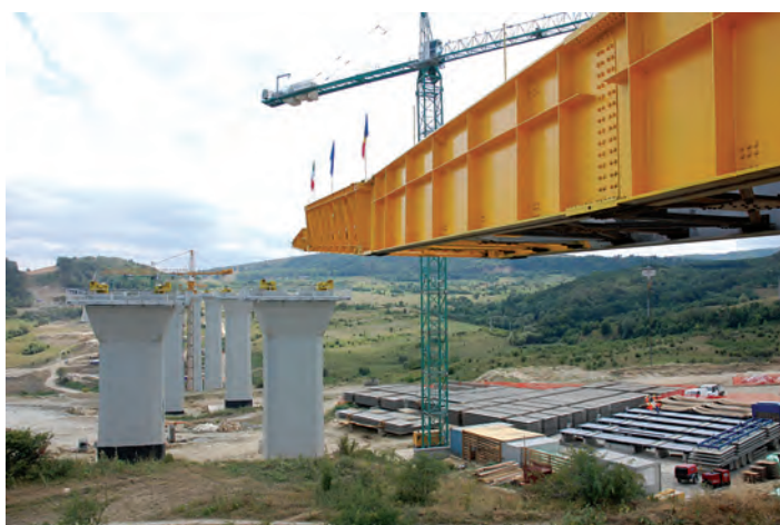
Așezată pe role, grinda avansează către locul de amplasare
