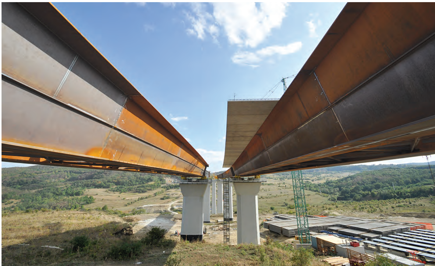
Grinzile paralele, cu înălțimea de 3,15 m și cu lungimea totală de 1.010 m
