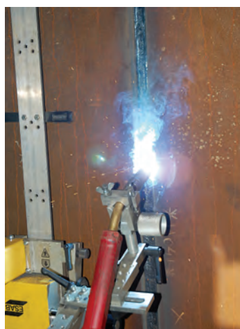
Sudorii Firmei VILBUC PROD S.R.L. - Târgu Jiu unesc tronsoanele cu înălțimea de 3,150 m și lungimi cuprinse între 8.820 mm și 13.055 mm și finalizează grinda Viaductului lung de 1.010 m. Utilizează aparate MIG-MAG și tractoare liniare și pendulare
