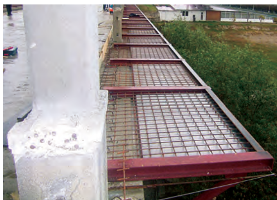
Figura 11: Structura trotuar în consolă
