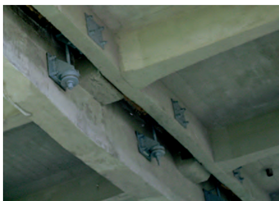
Figura 13: Tensionarea articulației Gerber
