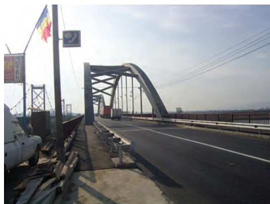
Figura 23: Vedere cale la podul reabilitat: a) pod pe arce;
