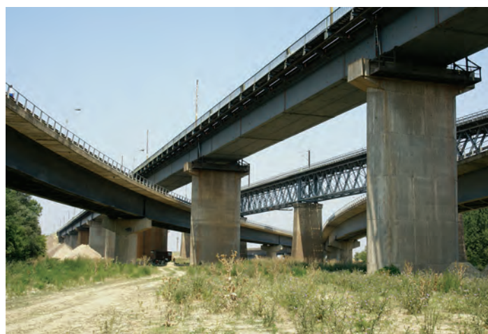
Viaductele podurilor peste Dunăre, la Fetești și Cernavodă
