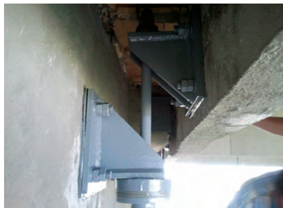
Figura 14: Dispozitiv tensionare articulație
