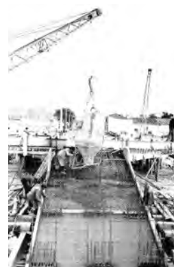
Fig. 044 - Suprabetonarea bolții existente (Foto Octavian DIMITRIU, 1977)
