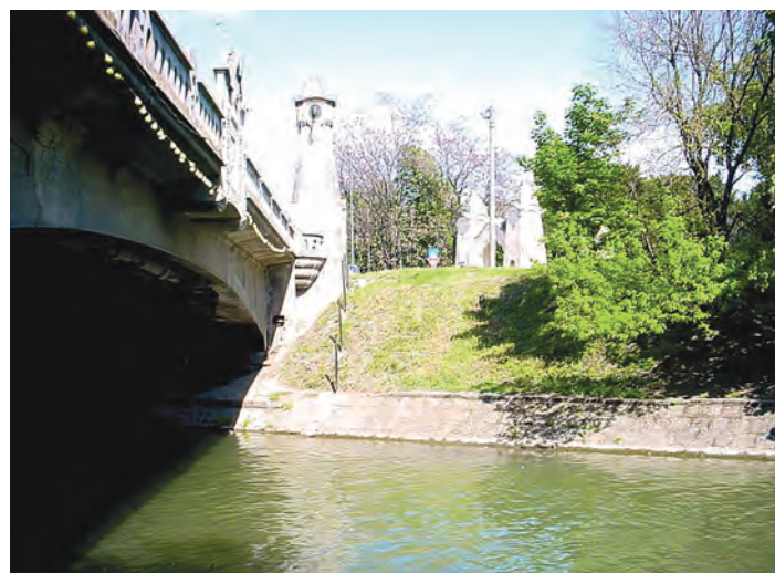
Fig. 057 - Podul Decebal, elevația aval (Foto S. FLOREA, 2002)
