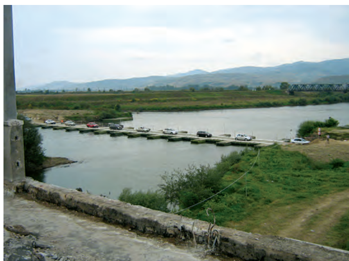
Figura 10: Pod provizoriu din pontoane
