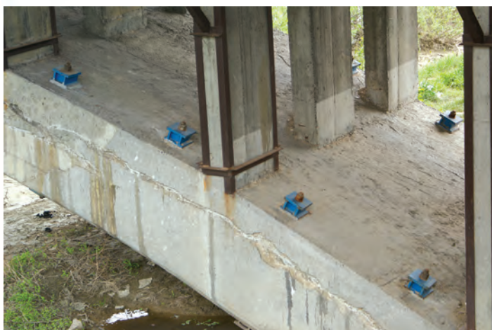
Fig. 047 - Detaliu cu consolidarea cu bare Macalloy a bolții (Foto, S. FLOREA, 2012)
