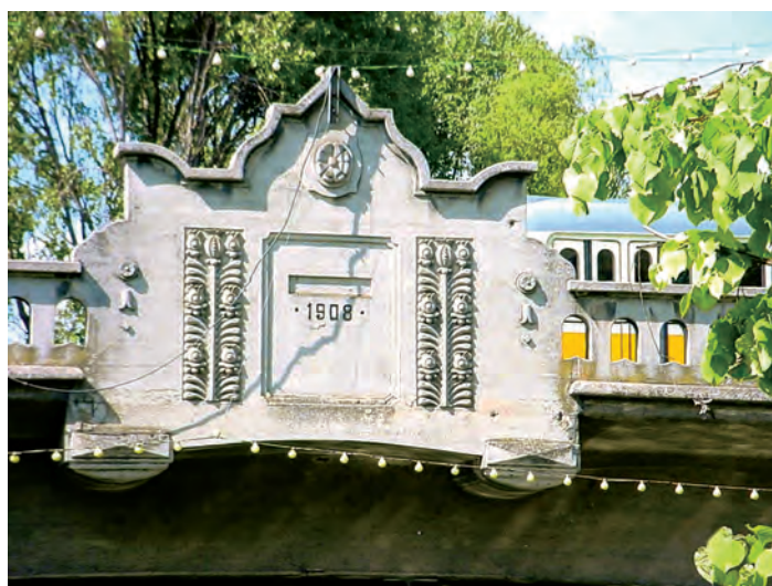
Fig. 054 - Detaliu cu ornamentul de pe parapet (Foto S. FLOREA, 2002)
