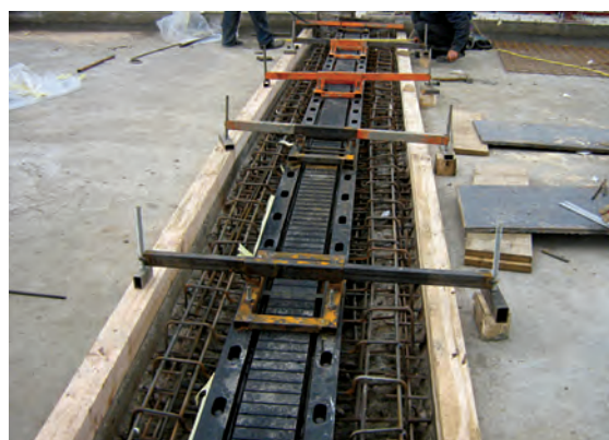
Figura 17: Montaj dispozitiv rost
