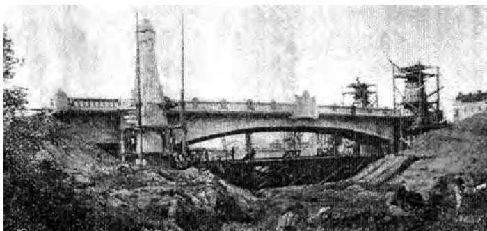
Fig. 048 - Aspecte de la execuția podului Decebal din 1908 (Colecția Árpád JANCȘÓ)
