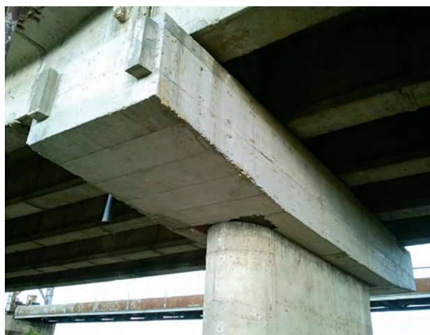
Figura 22: Rigla pilei - precomprimat
