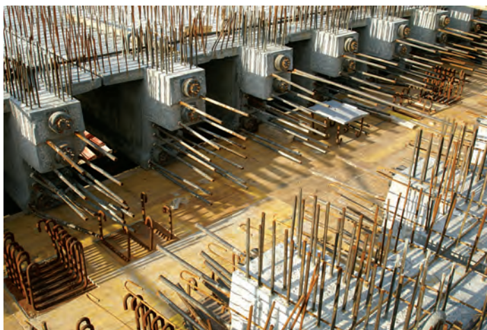
Grinzi pretensionate pozate la pasajele rutiere Băneasa, pe D.N. 1
