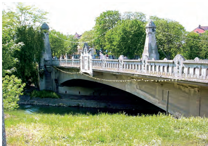
Fig. 051 - Elevația aval a podului văzută de pe malul stâng al râului Bega regularizat (Foto S. FLOREA, 2002)
