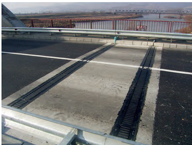
Figura 18: Rosturi de dilatație pe pilă (pod arce)
