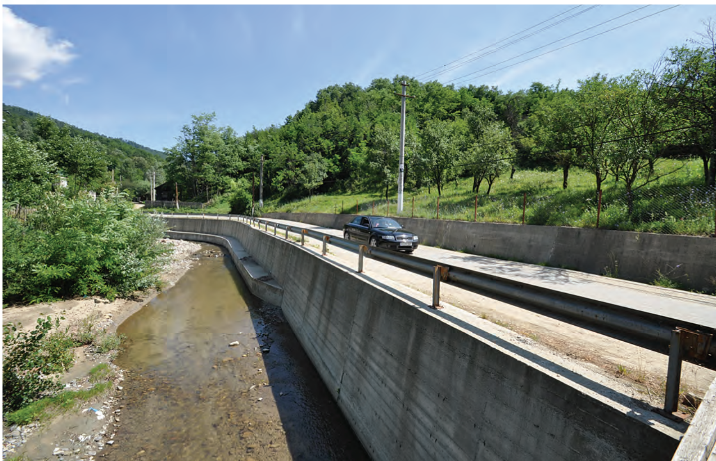
D.J. 658, lucrări de consolidare a malurilor
