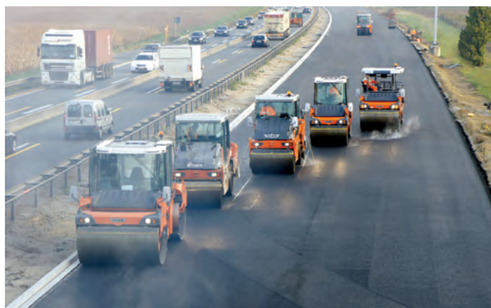
Foto 2 - Antena DGPS de pe plafon este un semn sigur al unui compactor cu HCQ-Navigator Premium. Sistemul de la Hamm poate conecta datele de compactare de la mai multe compactoare prin WLAN în timp real. În acest fel, fiecare operator de compactor cunoaște situația întregii zone de compactare.
