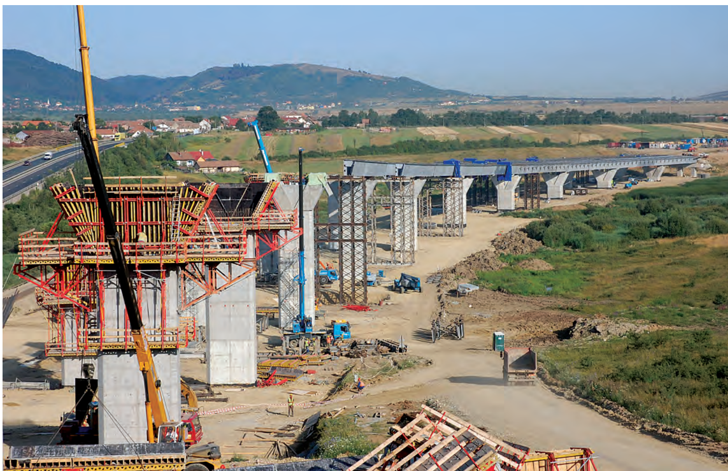
„Desfășurarea” pilelor la Viaductul Mare
