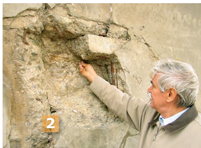
Fig. 028 - Detaliu de alcătuire în elevație a soluției adoptate în 1908-1910
