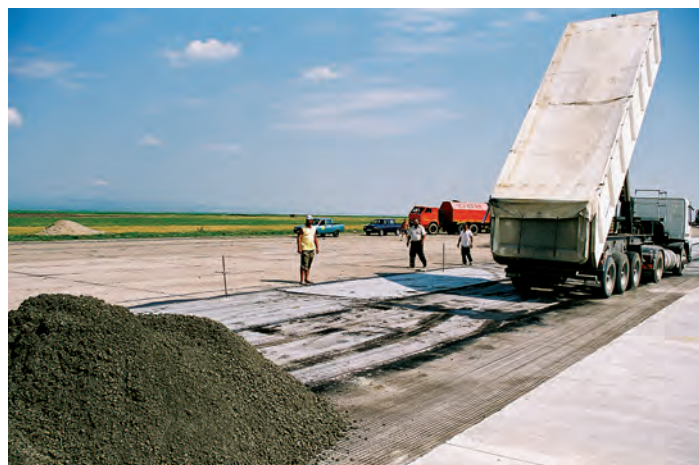
Lucrări la pista aeroportului Bobocu
