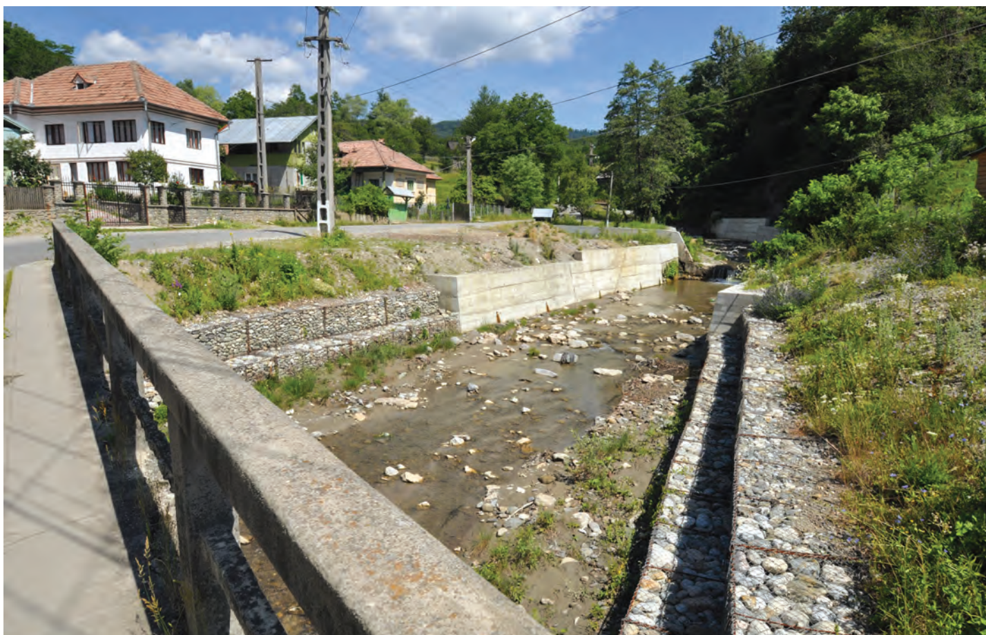
D.J. 658, gabioane și apărări de maluri
