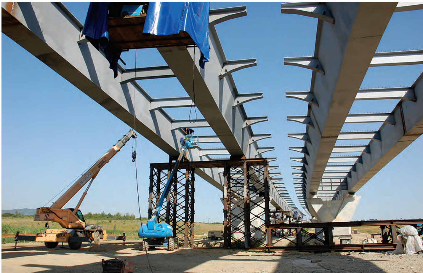
„Alinierea” grinzilor metalice la Viaductul Mare
