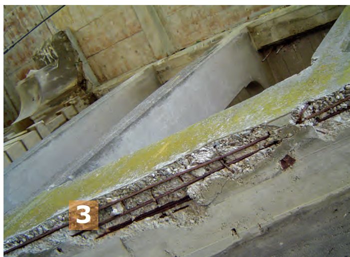
Fig. 027 - Degradări ale structurii existente (Foto S. FLOREA, 2004)
