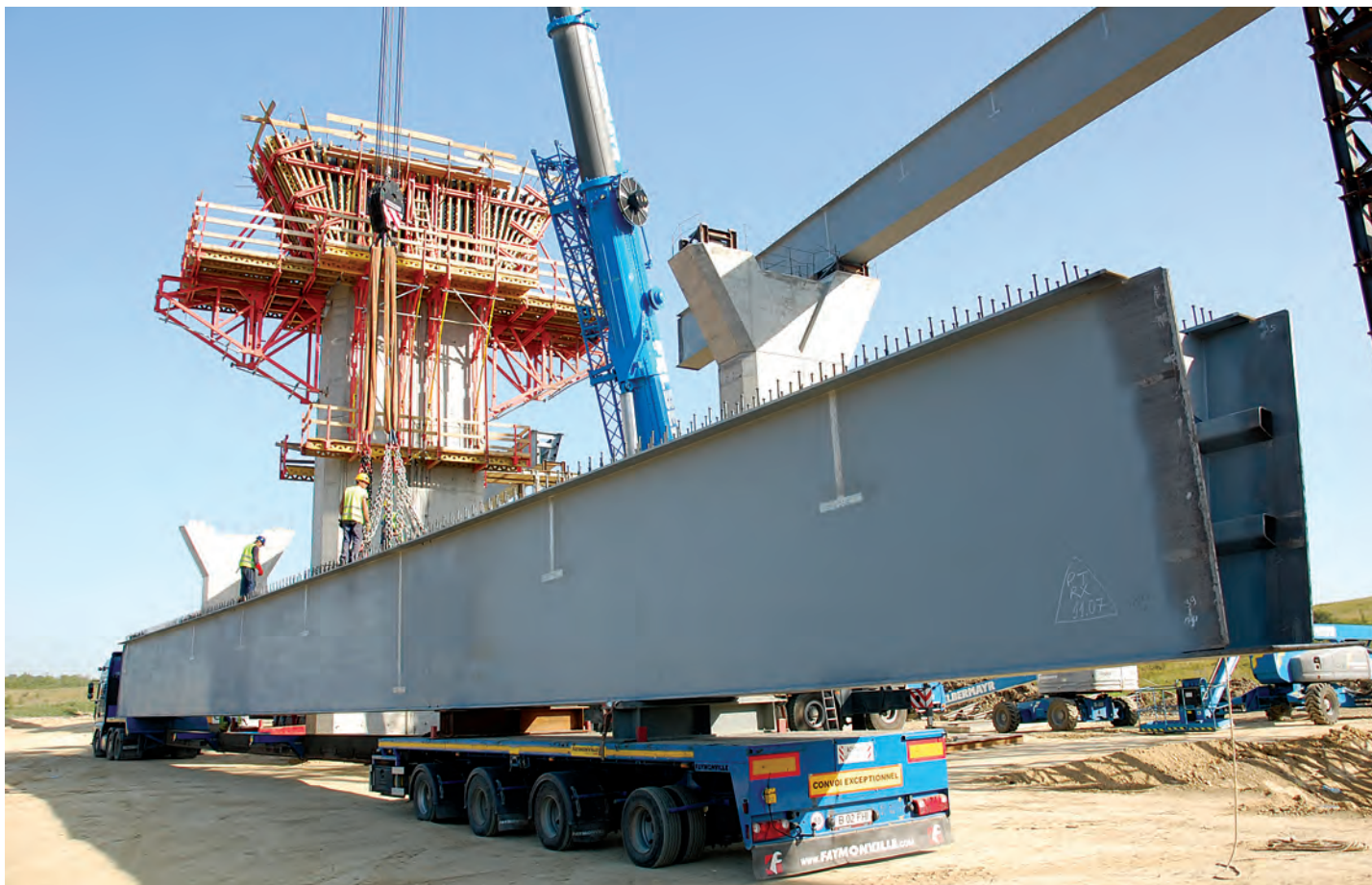
Uriașa grindă metalică adusă la locul de montare
