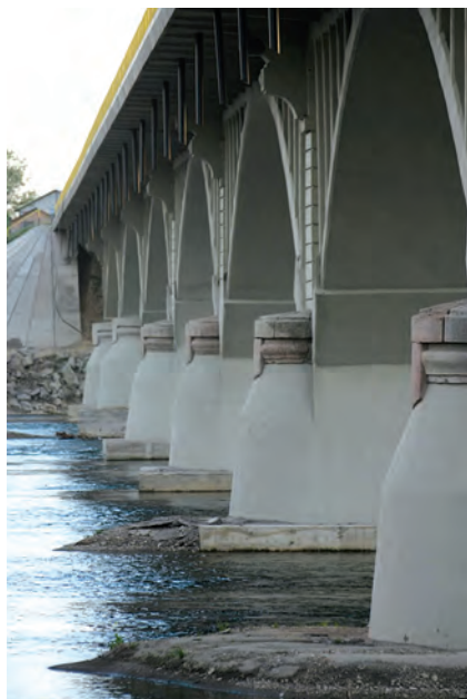
Fig. 032 - Elevația aval a podului după efectuarea lucrărilor de reparații capitale din perioada 2005-2007 (Foto S. FLOREA, 2007)
