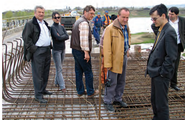
Fig. 031 - Armarea plăcii de suprabetonare (Foto S. FLOREA, 2006). De la stânga la dreapta, ing. Ilie ȘTEFAN, ing. Mirela POPESCU de la D.R.D.P. Iași, sing. Ioan BLAGOVICI, Ing. Mihai HUMĂ, de la constructor S.C. ARCADIA COMPANY S.A. - Galați și ing. Constantin ZBÂRNEA de la beneficiar D.R.D.P. Iași
