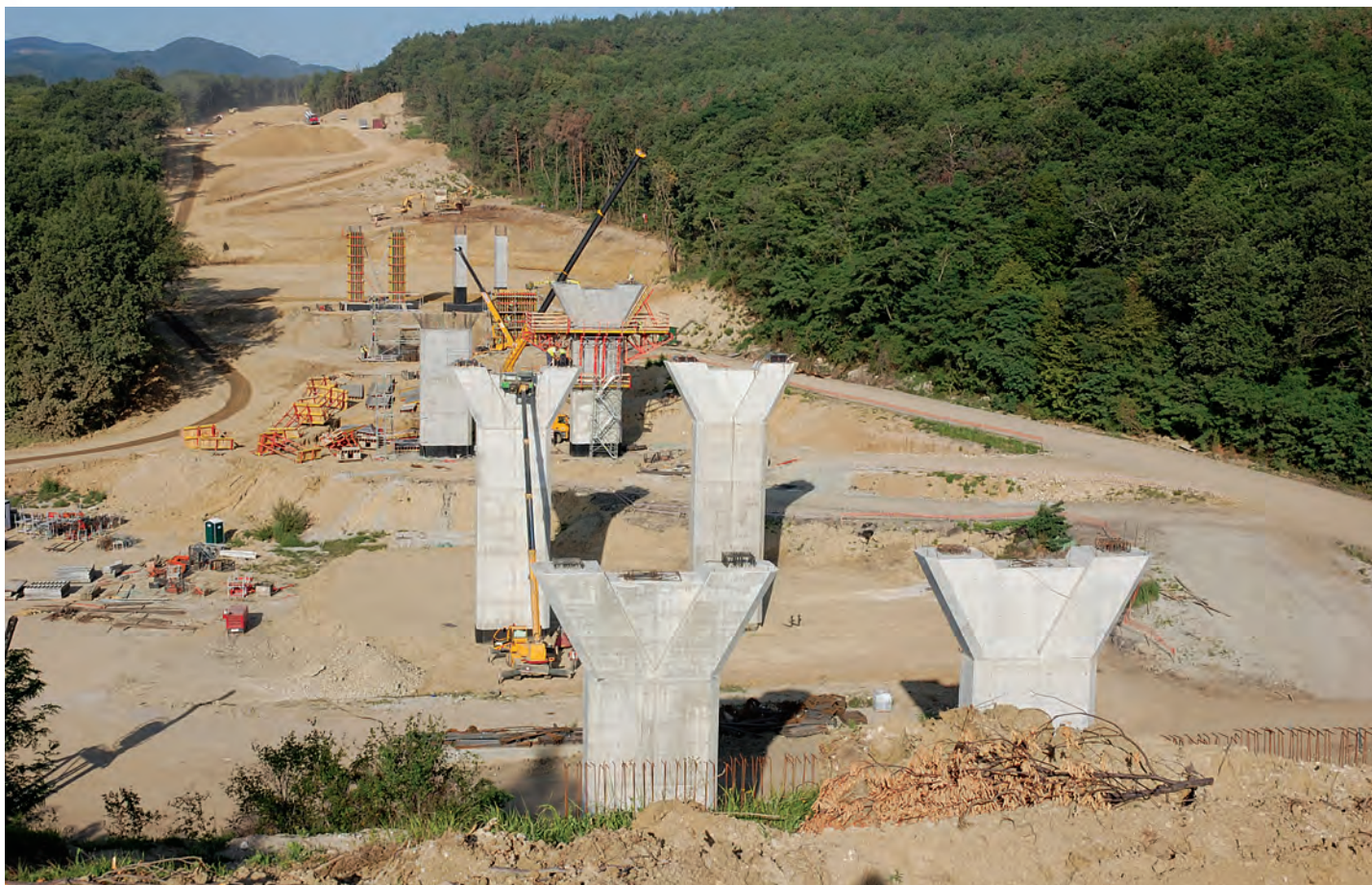
Pilele de la Viaductul Mic - în execuție
