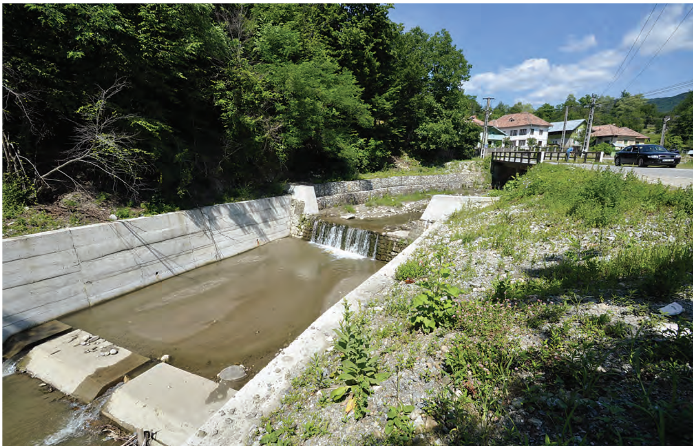
Lucrări complexe pe cursul pârlului, pe D.J. 658
