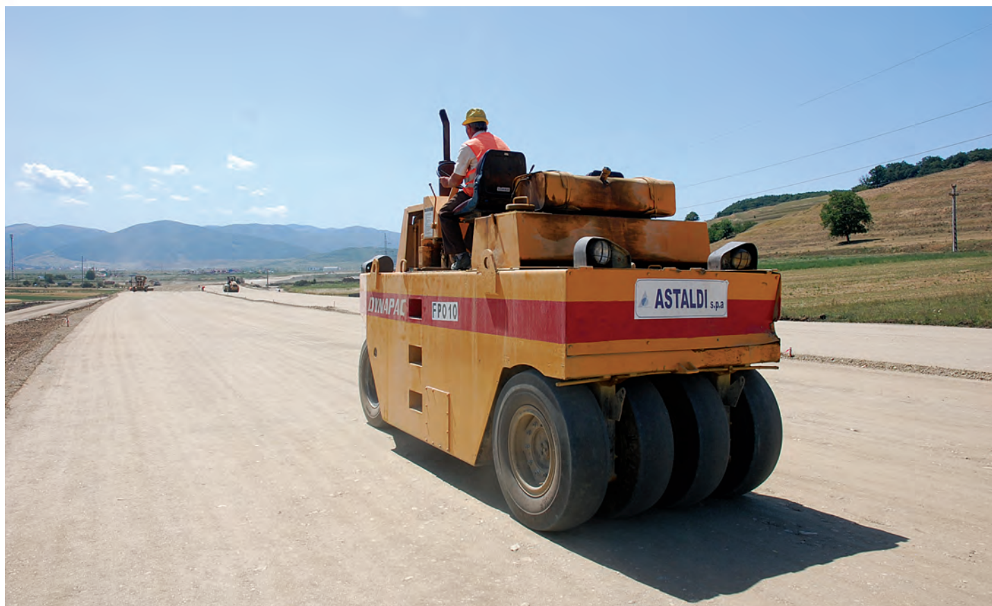
Compactarea straturilor de balast stabilizat la km 77+000
