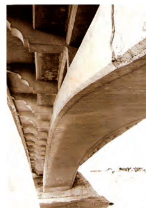
Fig. 035 - Podul peste râul Bârlad, secțiunea transversală A-A la cheie, releu și intradosul consolei aval a tablierului de beton armat și a bolții, văzut de pe malul stâng al râului Bârlad (Foto și desen S. FLOREA, 1976)
