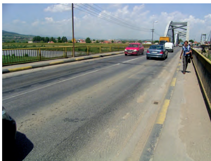
Figura 2 - Vedere generală cale pe pod - pod descărcare
