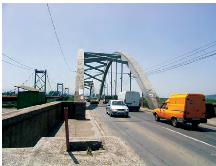
Figura 1 - Vedere generală cale pe pod - pod arce
