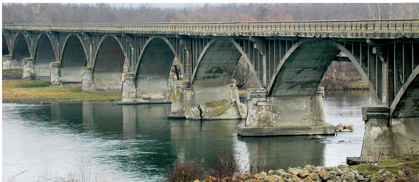
Fig. 022 - Dispoziția generală a lucrării realizată în anii 1908-1910. (Desen G. URDEA) În fotografie, elevația podului văzută din amonte de pe malul drept al râului Siret (Foto M. HUMĂ, 2004)
