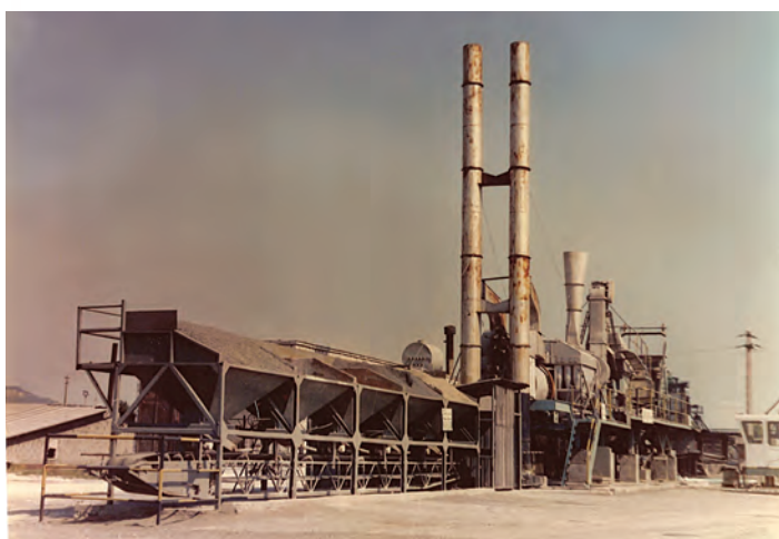
FMB Mintia. LPX achiziționat prin transfer, reparat și pus în funcțiune în zona SDN Deva
