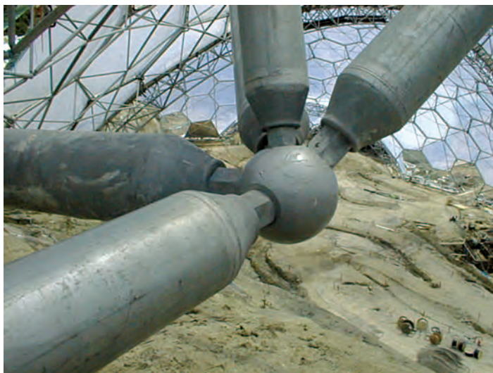
Fig. 7. Conectarea grinzilor inferioare [1]
