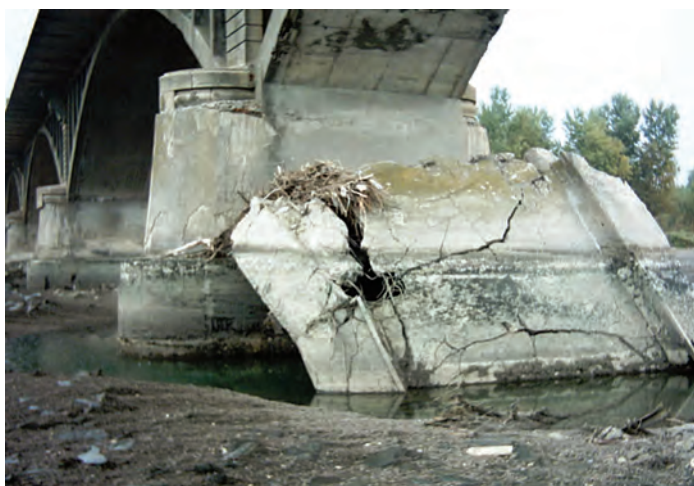
Resturile tablierului rămase în secțiunea podului la dinamitarea din timpul celui de-al doilea război mon- dial. (Foto, S. FLOREA, 2004)
