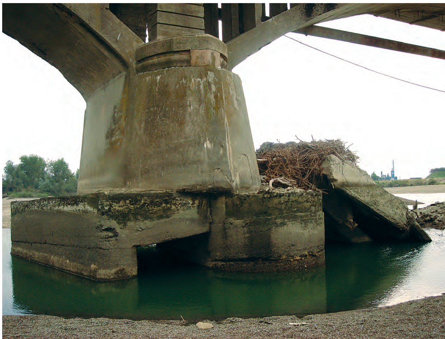
Fig. 026 - Fundația pilei P03 dezvelite în vara anului 2006 (Foto O. BARBIER, 2006)
