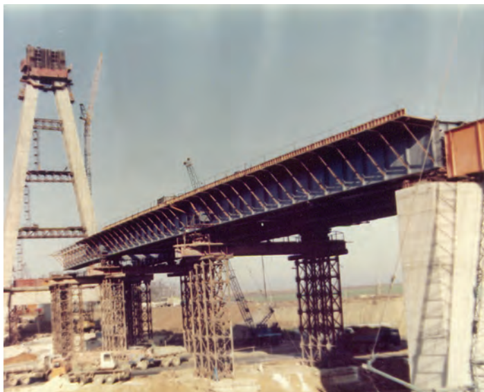
Pod peste Canalul Dunăre - Marea Neagră. Montare structură metalică.
