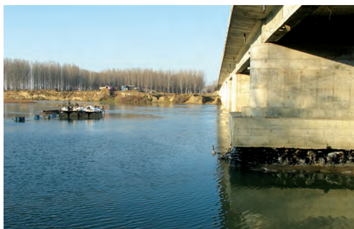
Fig. 016 - Lansarea la apă și umplerea geotubului cu material local (Foto S. FLOREA, 2004)
