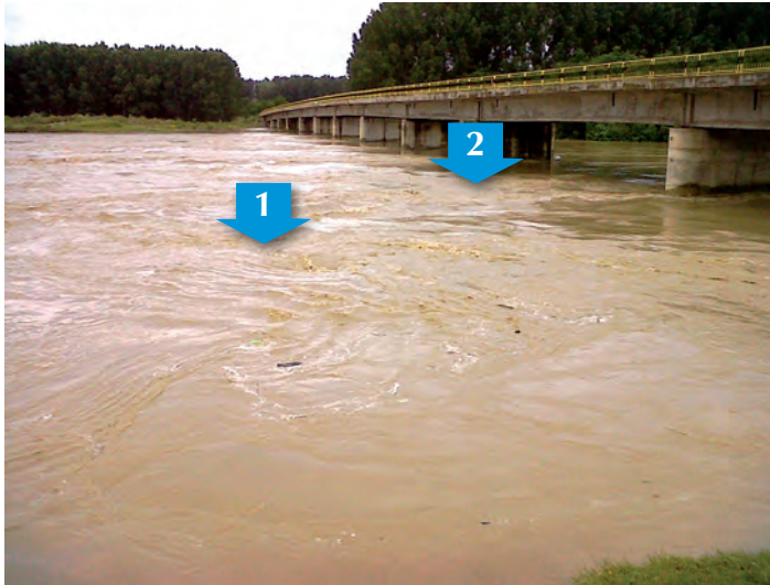
Fig. 018 - Pod peste râul Siret la Ion Creangă. Viitura din 2010, 2 iulie orele 0,00 a.m., la 10 ore după atingerea debitului maxim de 2814,00 m 3 /sec. Privind din avalul podului spre amonte luciul de apă se desprind două zone evidente:
