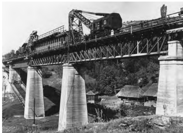
Verificarea și schimbarea unei grinzi la suprastructura unui pod de pe linia Salva - Vișeu.
