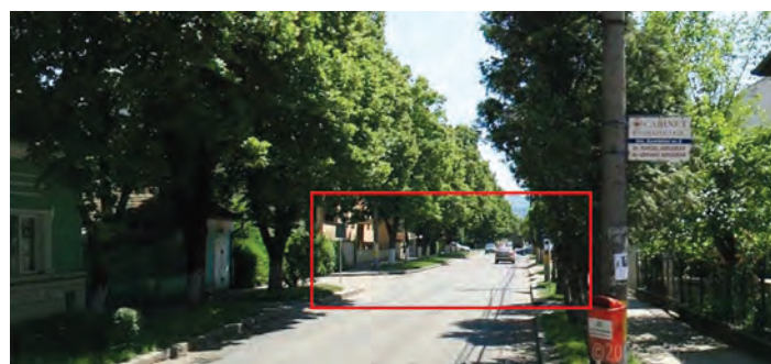
Fig. 3 – Trecere de pietoni insuficient semnalizată
