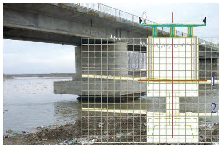
Fig. 011 Secțiune prin deschiderea 10, privind spre elevația pilei P10. Evoluția talvegului în perioada 1978-1997 (20 de ani).
