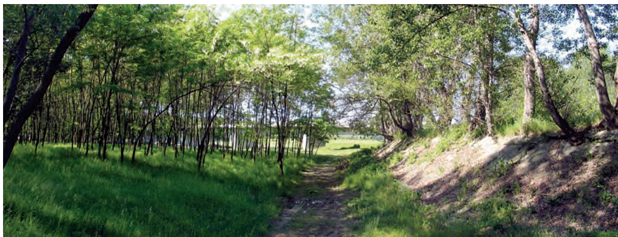
Fig. 010 DJ 207 C Horia – Ion CREANGĂ, km 6 + 075 Pod peste Siret la Ion CREANGĂ. În prim plan, pe dreapta, digul de dirijare a apelor la viitură construit conform avizului de gospodărire a apelor din 1973, iar pe stânga, plantația care acoperă 70 % din secțiunea de curgere la viitură și care pune în pericol de prăbușire podul existent, plantație creată de oameni în intervalul 1978-2005.
