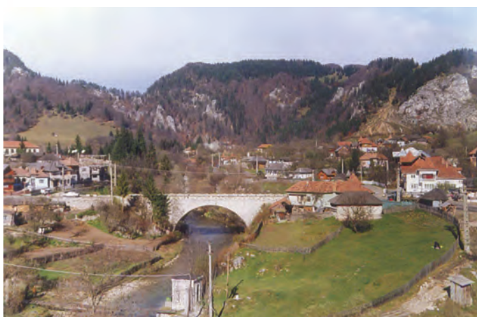
Foto 2 - Vedere generală a podului în localitatea Podul Dâmboviței
