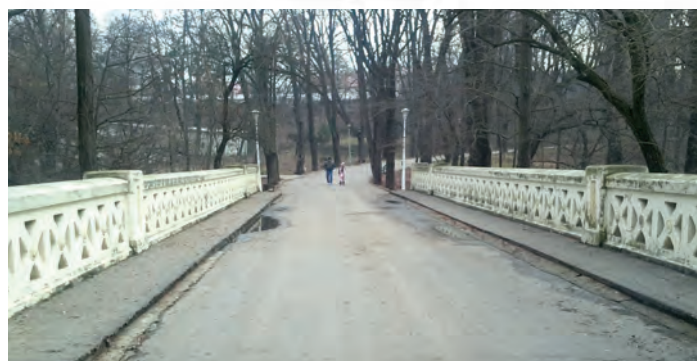
Fig. 008 - Secțiunea transversală a podului lui Gogu CONSTANTINESCU (Foto și relevu Marian BORODI, 2012). Detaliu parapet.
