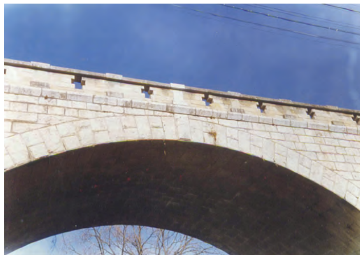
Foto 5 - Parapet bolțar de la cheie
