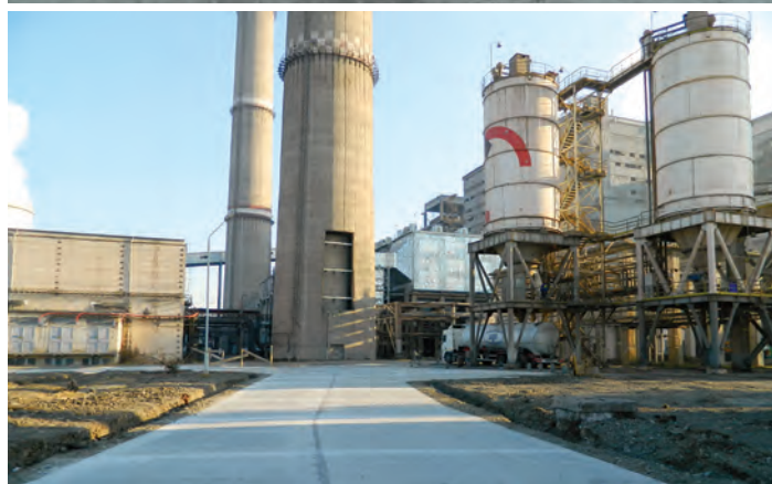
Figura 3 c – aspectul stratului stabilizat din agregate naturale și liant puzzolanic pe bază de cenușă și aspectul drumului la finalul execuției (drum cu îmbrăcăminte din beton de ciment)
