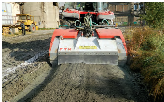
Figura 3 b - faza amestecului „in-situ” (agregate naturale - liant și apă)
