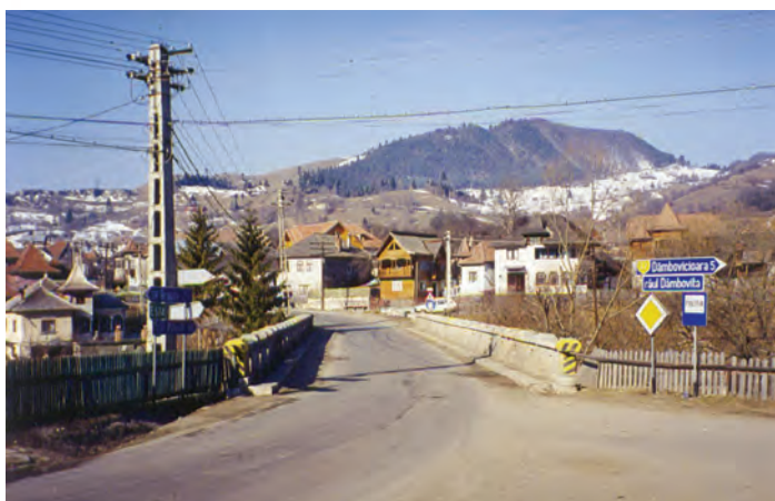
Foto 1 - Vedere generală pod cale
