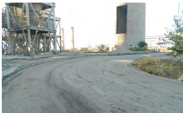
Figura 3 b - faza amestecului „in-situ” (agregate naturale - liant și apă)
