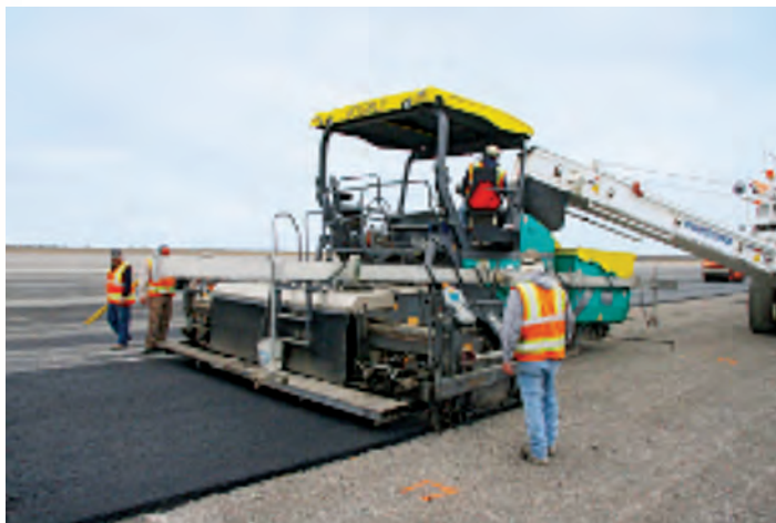
Pentru nivelare, finisorul a fost prevăzut cu o grindă de palpăre VÖGELE Big-MultiPlex-Ski.
