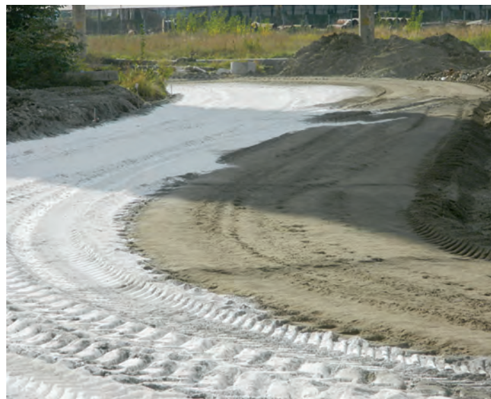
Figura 3a – răspândirea cenușii și a activatorului
