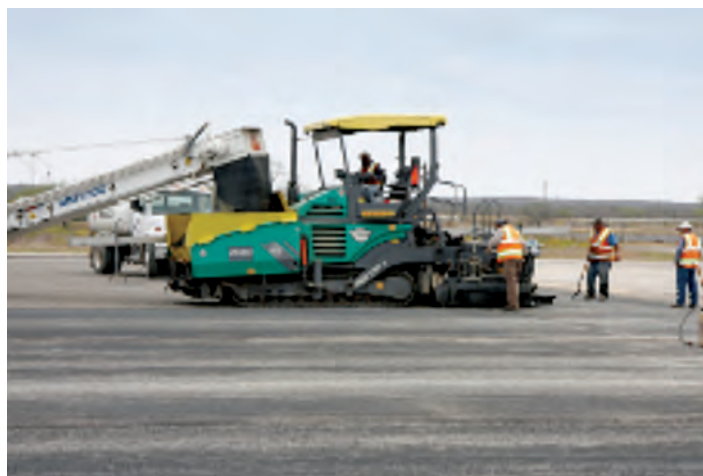
Reabilitarea pistei de încercări dinamice de formă pătrată s-a realizat cu finisorul SUPER 2100-2.
