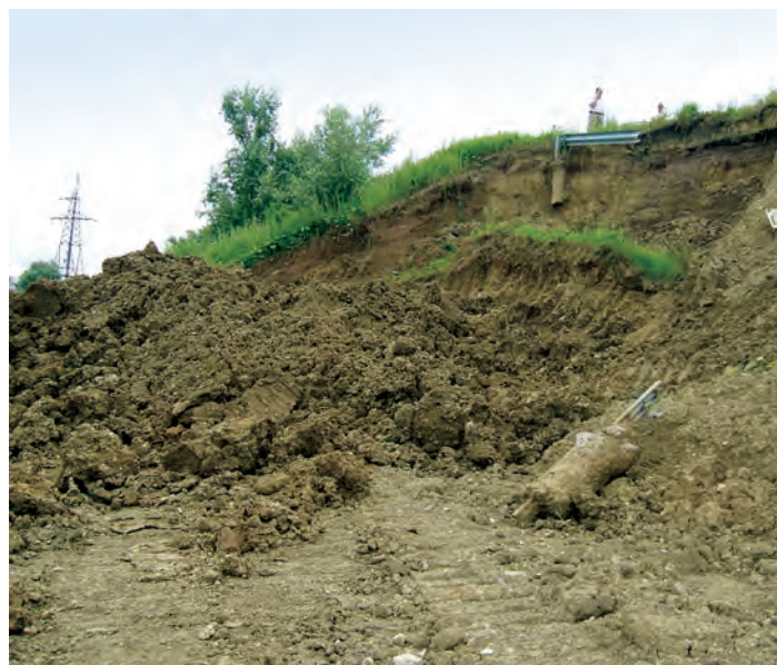
Figura 1. Vedere a alunecării taluzului rampei de acces la podul peste calea ferată
