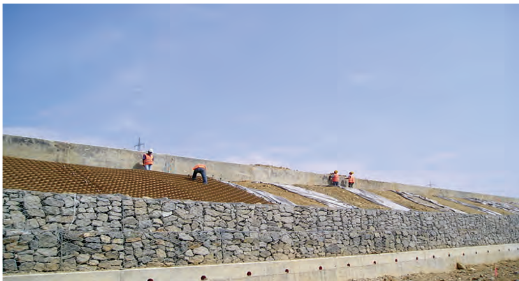
Figura 10. Folosirea geocelulelor pentru protecția taluzurilor
