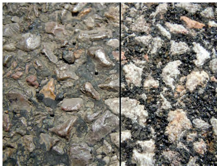
înainte de sablare după sablare
