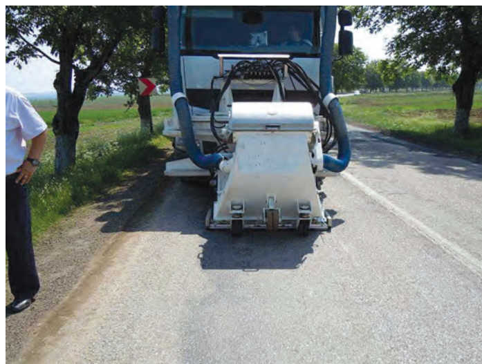
Execuția sablării pe D.N. 29B
