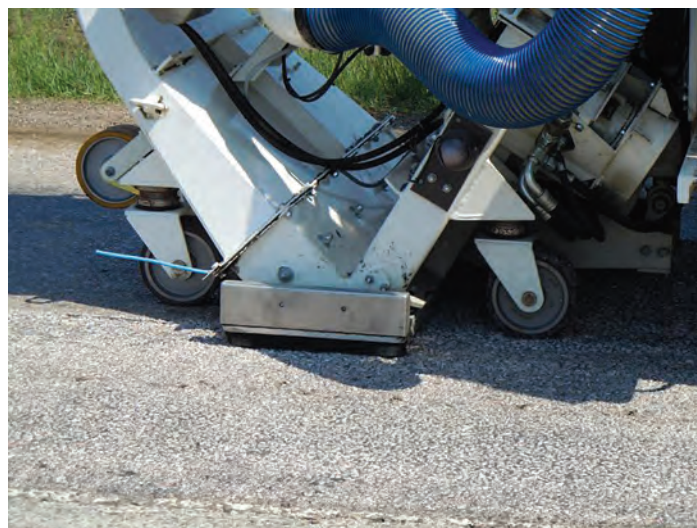
Execuția sablării pe D.N. 29B
