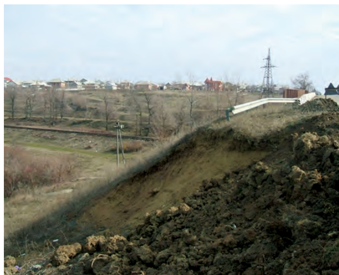
Figura 2. Una dintre cauzele alunecării - folosirea în rambleu a argilei grase
