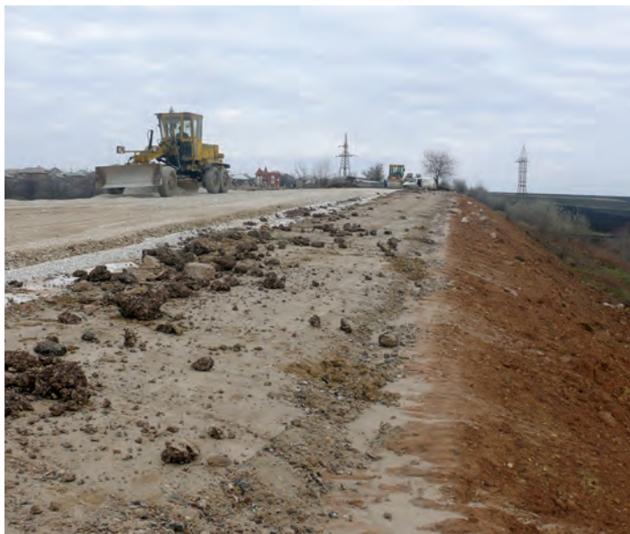
Figura 6. Lucrările de restabilire a rampei de acces în faza finală
