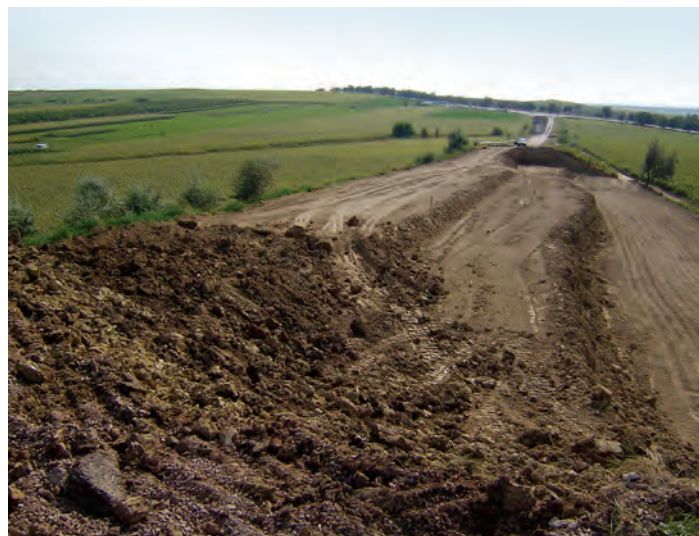
Figura 5. Rambleu cu trepte de înfrățire pregătit pentru plasarea geotextilului
