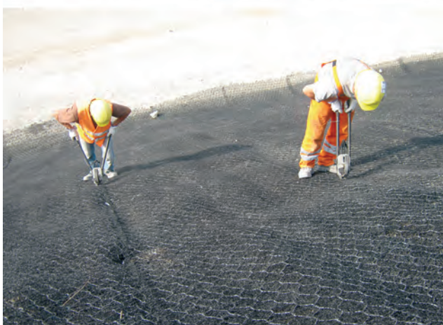
Figura 8. Folosirea geocompozitelor pentru protecția taluzurilor
