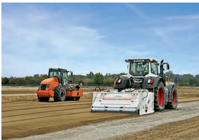
Foto 2. Concasor „in situ” – stabilizatorul purtat pe tractor WIRTGEN WS 250 – pentru care nu este nici o problemă realizarea unei granulații de max. de 32 sau 45 mm dintr-o singură trecere
