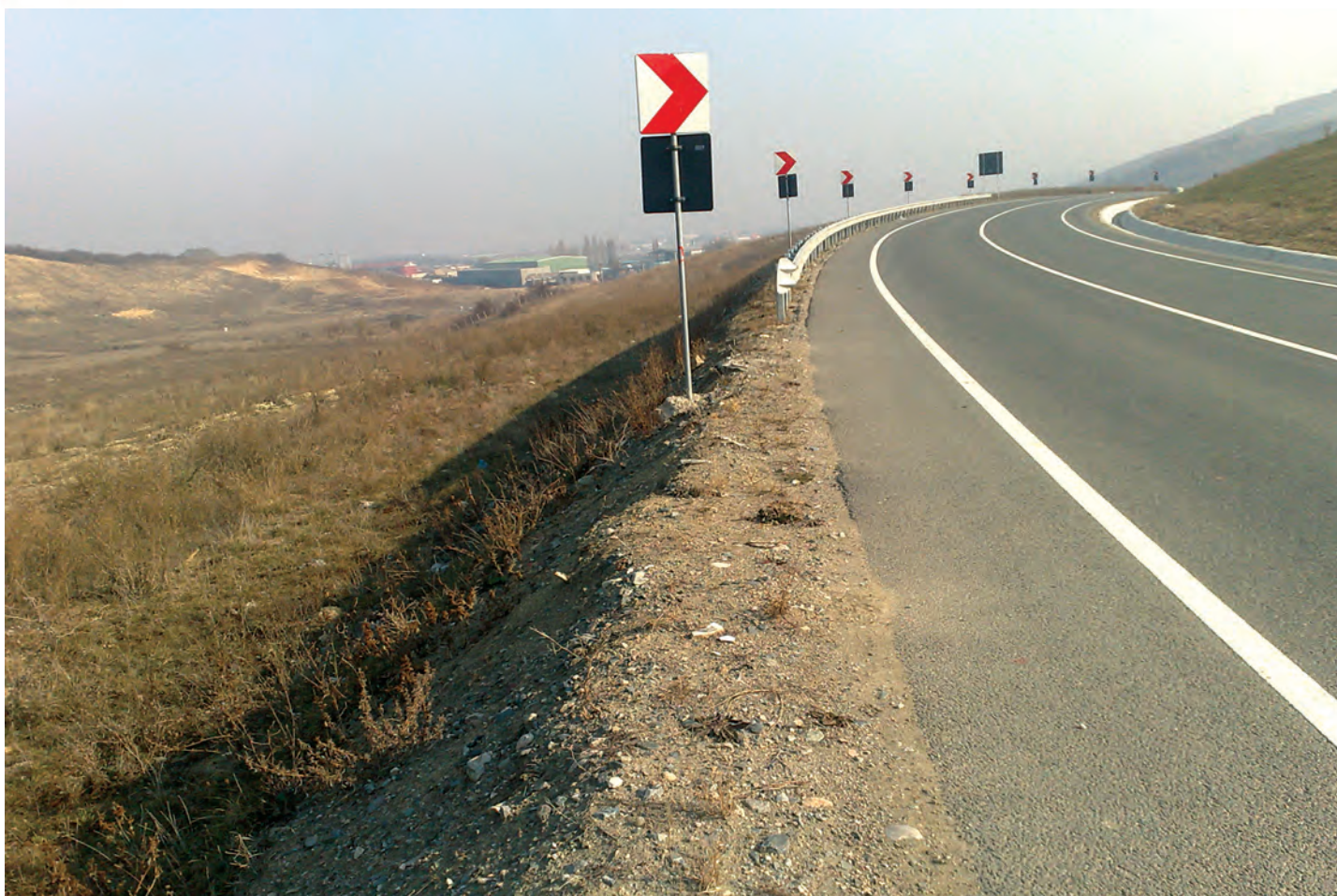
Varianța ocolitoare Cluj - Est km 15+700. Marcaj în curbă (zona industrială).
