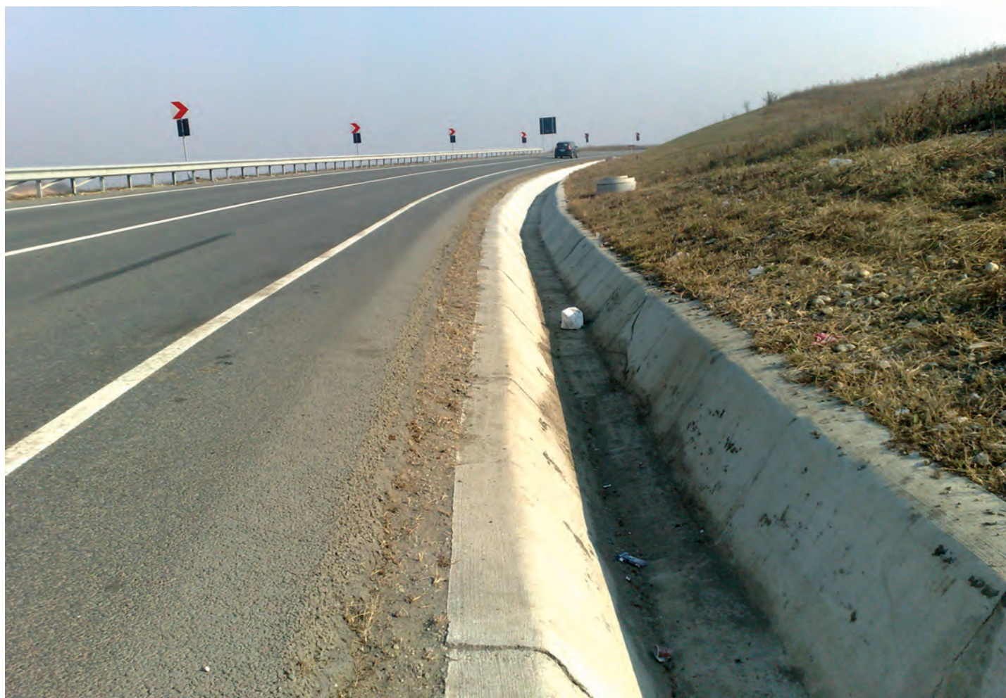
Varianța ocolitoare Cluj - Est km 15+600. Curbă protejată de un parapet de tip greu
