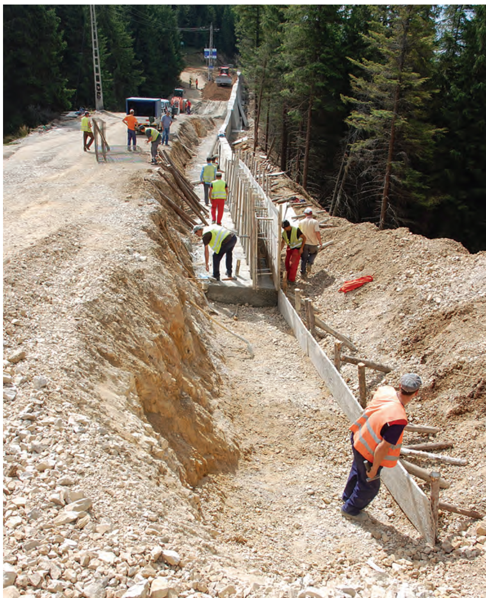
Șanțul și drumul în construcție
