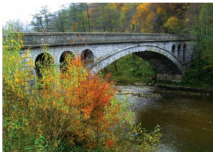
Fig 13 - Elevația podului de zidărie de piatră văzută din amonte de pe malul stâng al râului Motru (Foto S. FLOREA ; 2006)
