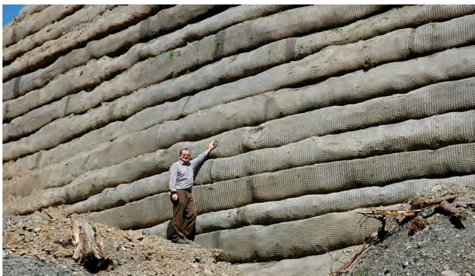
Rambleu din straturi succesive din pământ armat cu geogrilă
