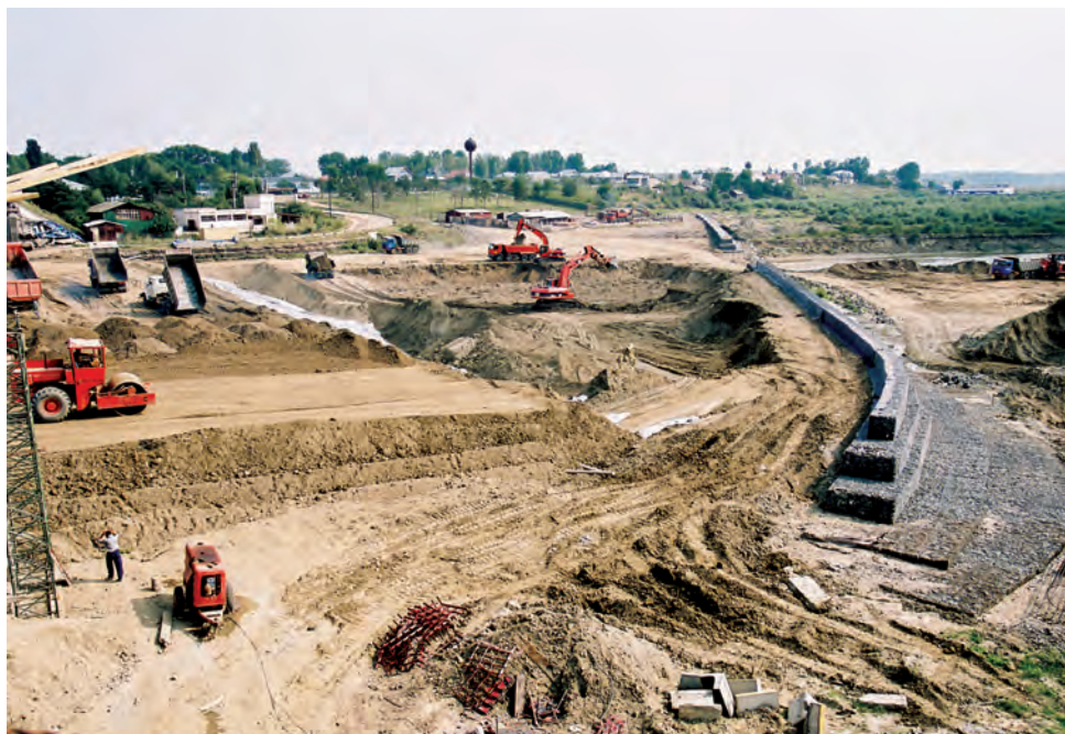
Execuție prag de fund la Podul de la Mărăcineni
