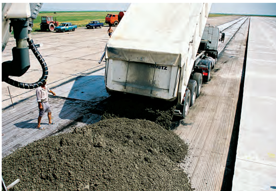
Execuție pistă din beton - Aeroportul Militar Boboc
