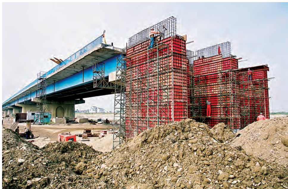
Execuție culee calamităță - Pod Mărăcineni
