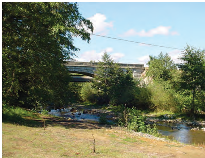
Fig 11 - Elevația podului de zidărie de piatră văzută din aval de pe malul drept al râului Motru (Foto S. FLOREA ; 2002)
