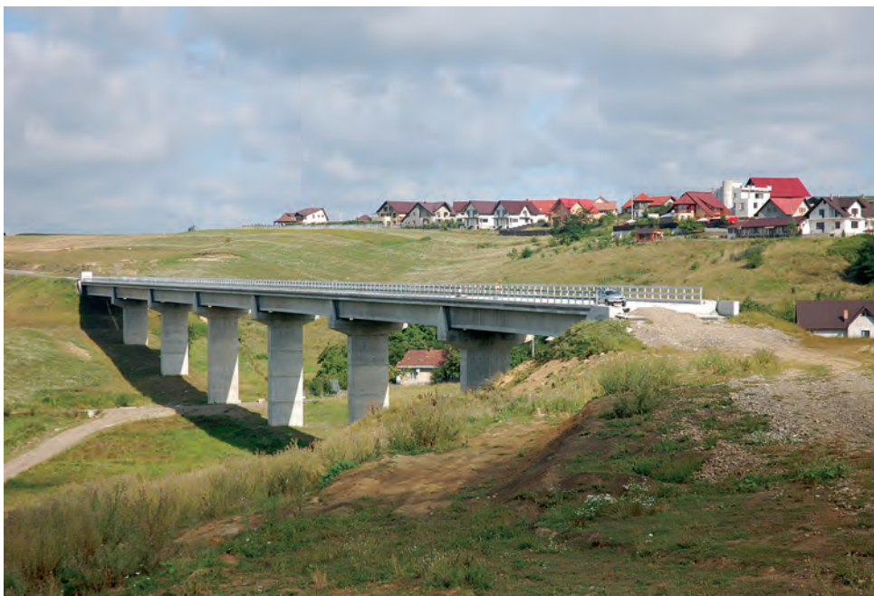
Viaduct cu 7 deschideri, în construcție, peste Valea Mănăstirii Hagigadar
