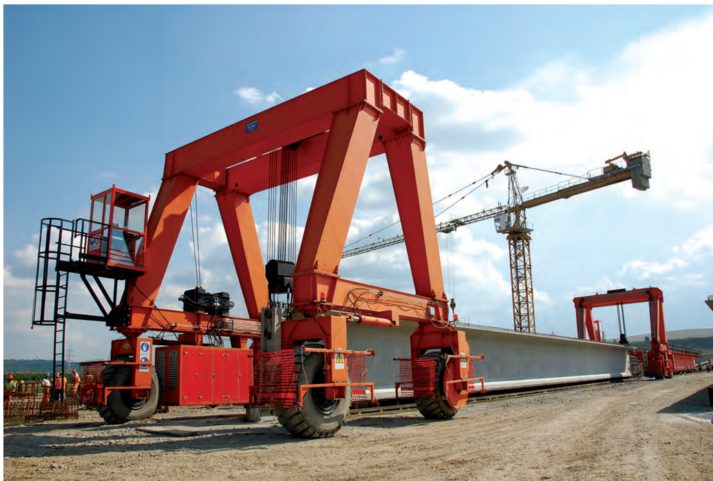
Macaralele portal transportă uriașele grinzi la locul de montare
