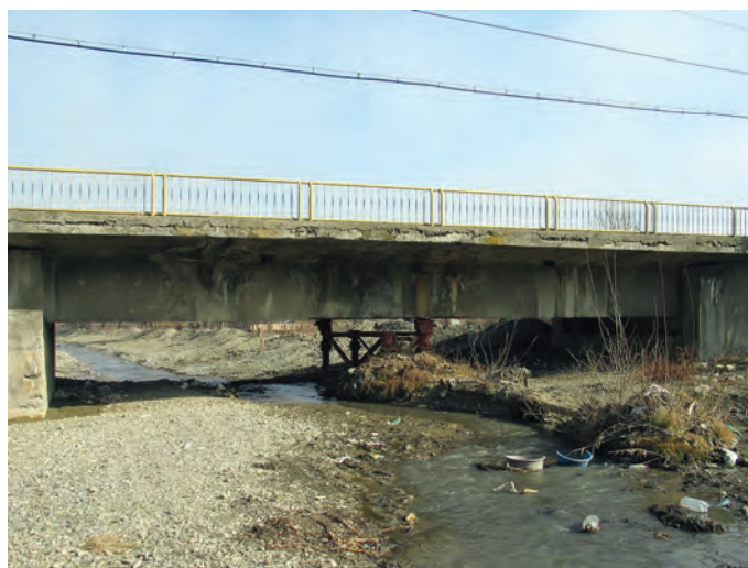
Elevația podului văzută din amonte
