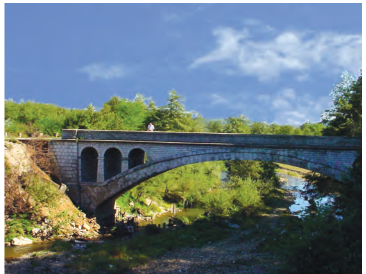
Fig. 08 - Elevația podului de zidărie de piatră văzută din amonte de pe carosabilul noului pod (Foto S. Florea ; 2001)
