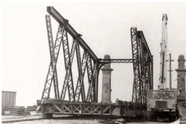
Fig. 4.44 Dezmembrarea vechilor tabliere din oțel pudlat din deschiderile 1 și 5 (foto Ion Ionescu)
