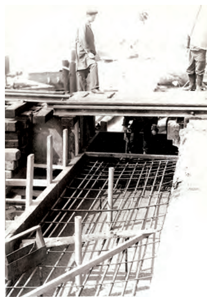
Fig. 4.46 Armarea zonei de supraînălțare a culeii C05, culeea Slatina. Maistrul Stan C. Ion supra-veghează operația de betonare. (foto Ion Ionescu)
