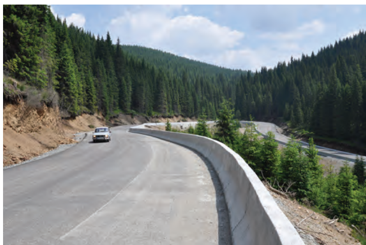
Serpentine cu parapeți din beton
