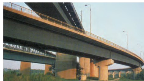
Viaductul de acces pentru cale ferată dublă, cu secțiune casetată la Podul peste Dunăre de la Cernavodă
