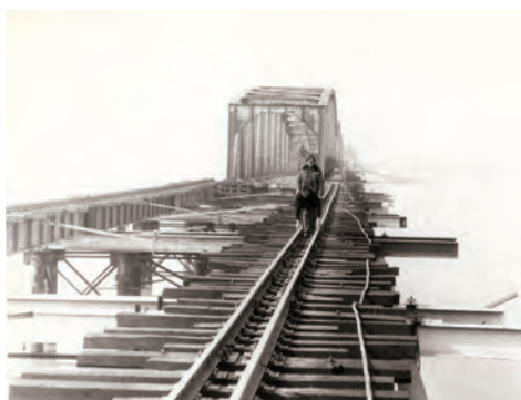
Fig. 4.39 Eșafodajul din deschiderea 5. Fotografie din colecția ing. Ion IONESCU
