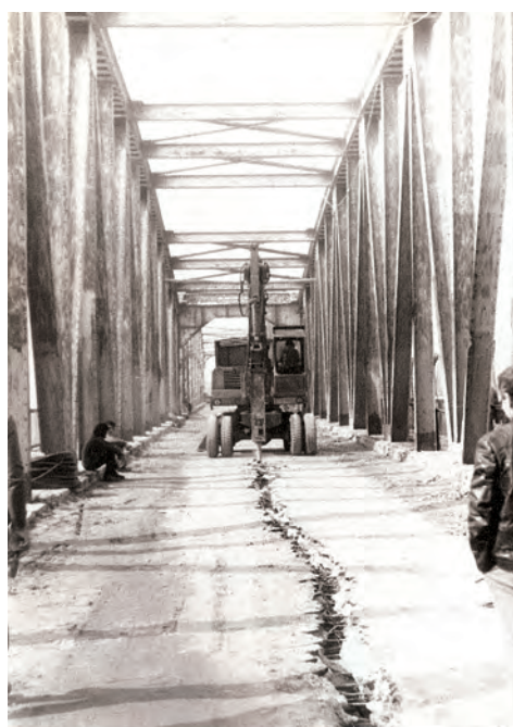
Fig. 4.40 Demolarea straturilor căii și a plăcii de beton armat existente. Fotografie din colecția ing. Ion IONESCU
