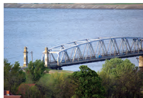
Fig. 4.38 Detaliu cu Elevația tablierului din deschiderea 5, văzută din amonte de pe dealul Grădiștei, malul stâng al râului Olt. Foto S. Florea
