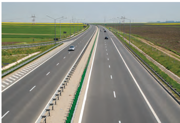
Autostrada A2, București - Constanța
