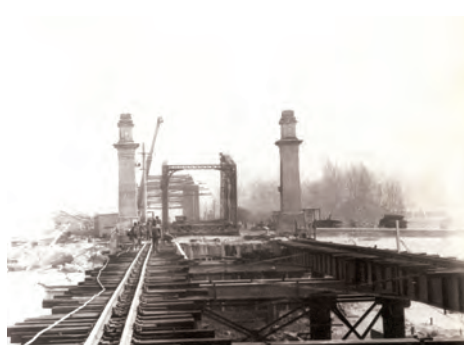
Fig. 4.43 Eșafodajul și calea de lansare din deschiderea 1. Fotografie din colecția ing. Ion IONESCU
