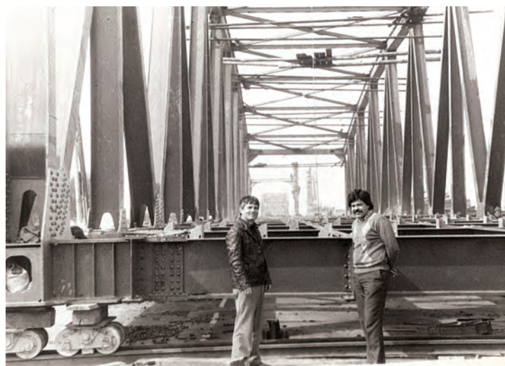
Fig. 4.41 Ripare la poziție a unei grinzi principale din deschiderile centrale. Fotografie din colecția ing. Ion IONESCU
