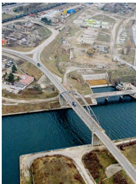
Viaductul de acces pentru cale ferată dublă, cu secțiune casetată la Podul peste Dunăre de la Cernavodă
