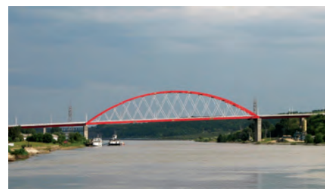
Podul rutier cu arce peste Canalul Dunăre-Marea Neagră la Cernavodă
